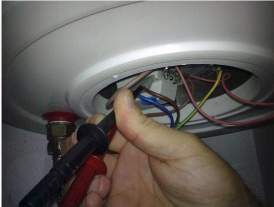
Figura 7.3: Momento de colocação das pinças do multímetro para efetuar a medição da corrente elétrica no termoacumulador.
