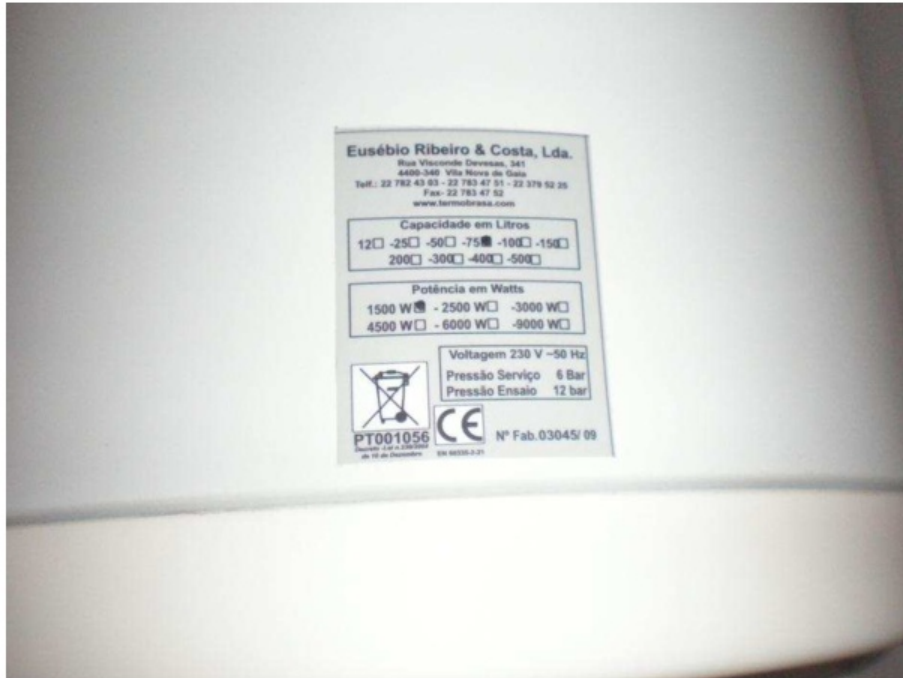
Figura 4.1: Chapa de informação de características afixada no termoacumulador.
