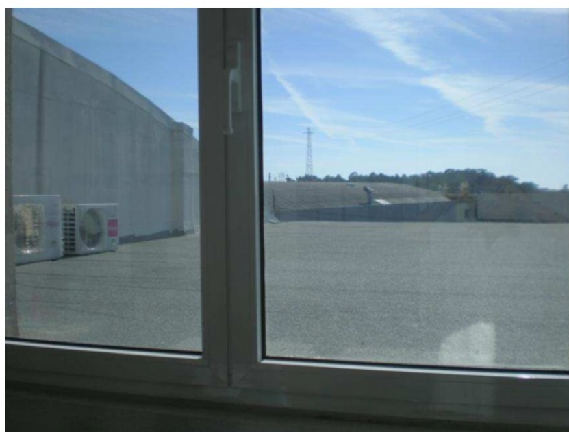
Figura 9.1: Vista do terraço a partir do gabinete da gerência com visualização da fronteira a este com o edifício contíguo.
