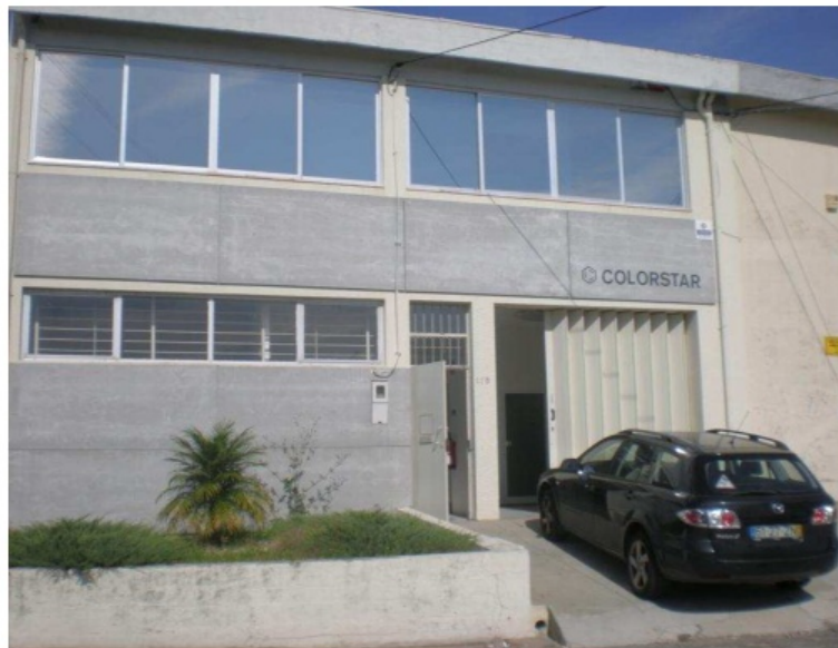
Figura 3.2: Vista frontal do edifício da Colorstar e das duas empresas que ocupam os dois gabinetes do 1º andar (os únicos com vista para o exterior)
