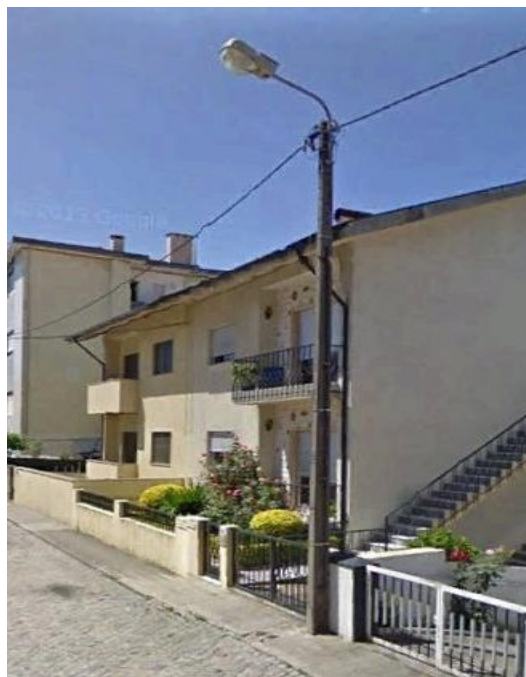
Figura 5. Tipo de poste existente
