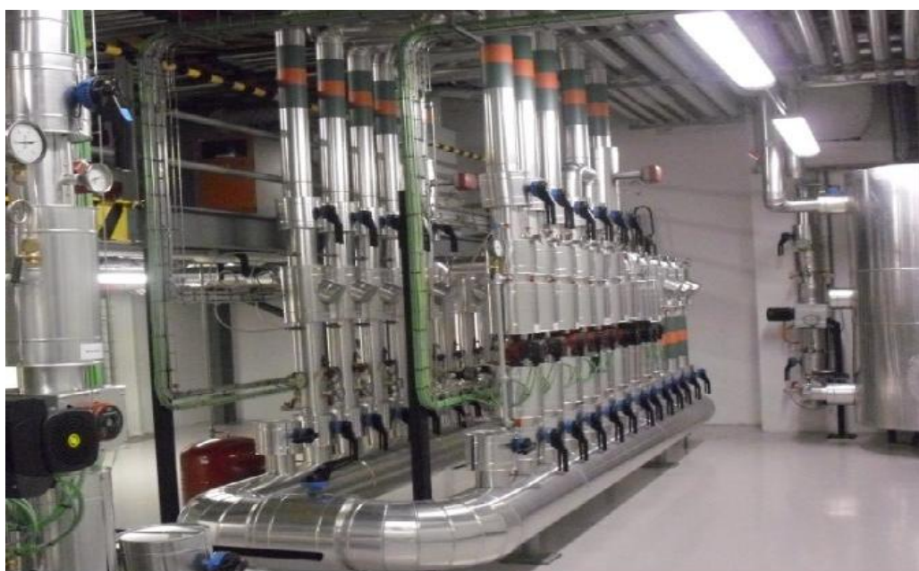
Figura 25 Coletores de admissão e retorno Água Fria
