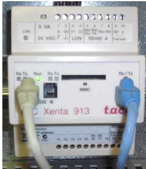
Figura 30 Gateway (Q.E. AVAC)
