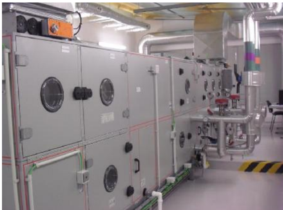
Figura 22 Unidade de Tratamento de Ar 3
