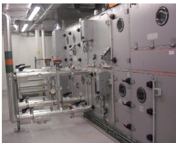
Figura 20 Unidade de Tratamento de Ar 1
