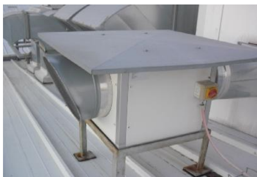
Figura 27 Ventilador de Extração das Instalações Sanitárias/Balneários
