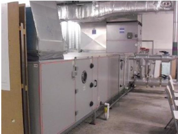
Figura 21 Unidade de Tratamento de Ar 2
