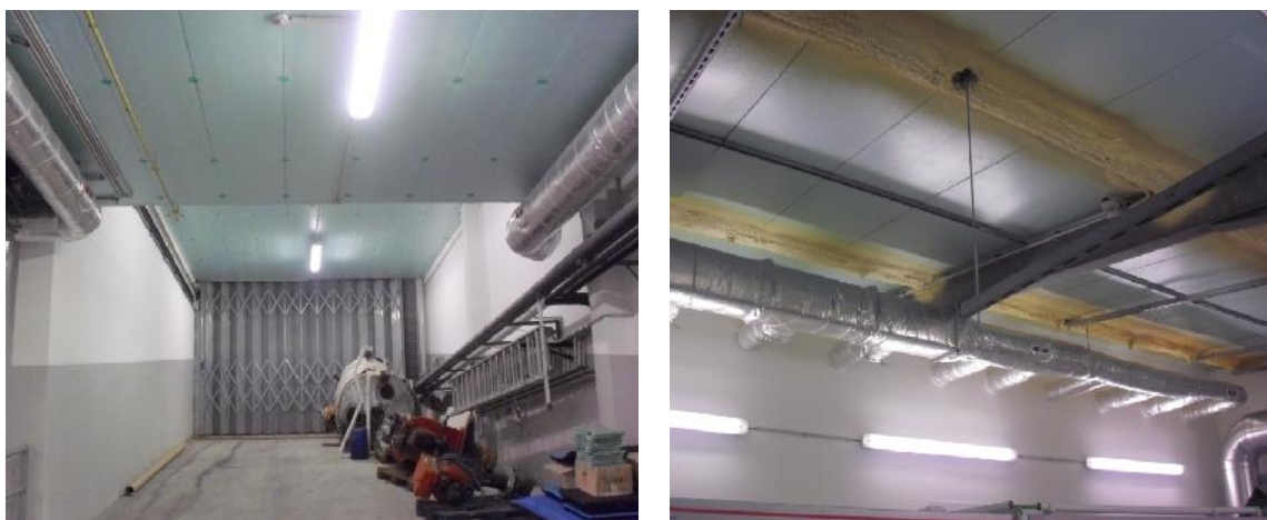
Figura 7 Pormenores de isolamento térmico existente no edifício
