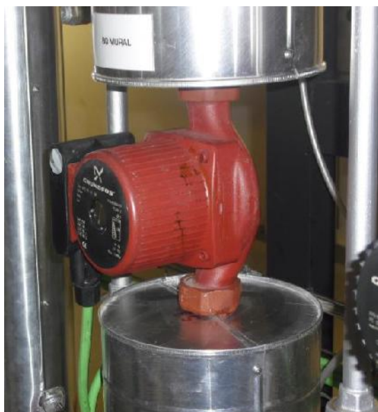
Figura 39 Bomba Circulação AQ (Caldeira Mural) com variação velocidade
