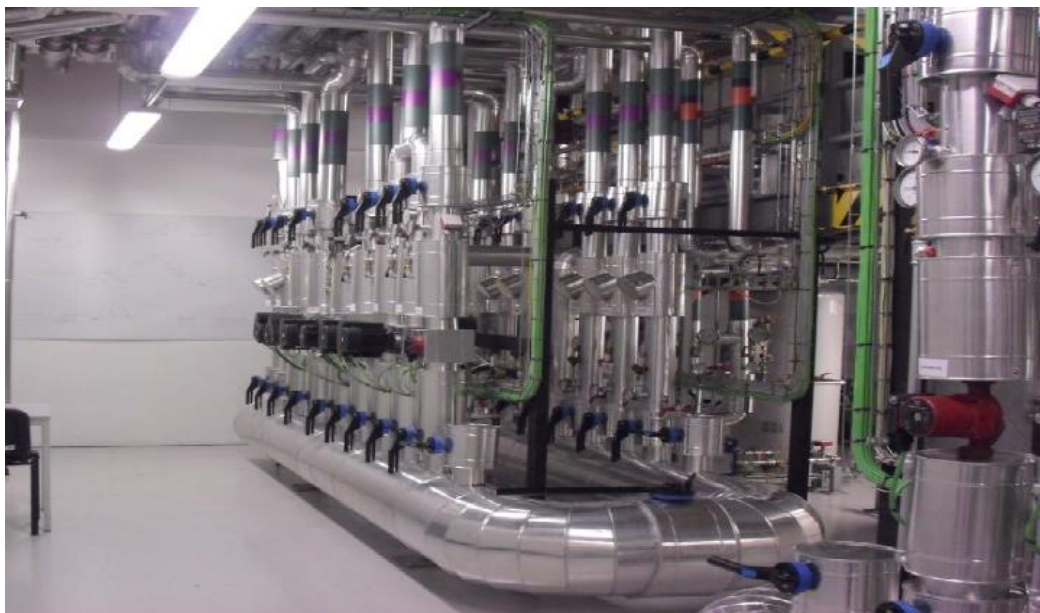
Figura 25 Coletores de admissão e retorno Água Fria
