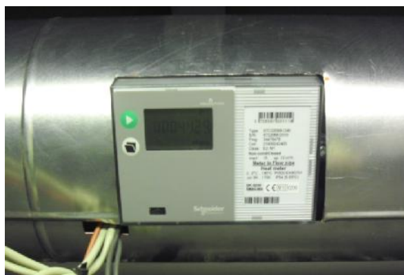
Figura 46 Contador de Entalpia
