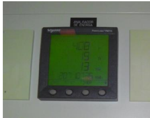
Figura 44 Analisadores de rede – Q.E. Entrada
