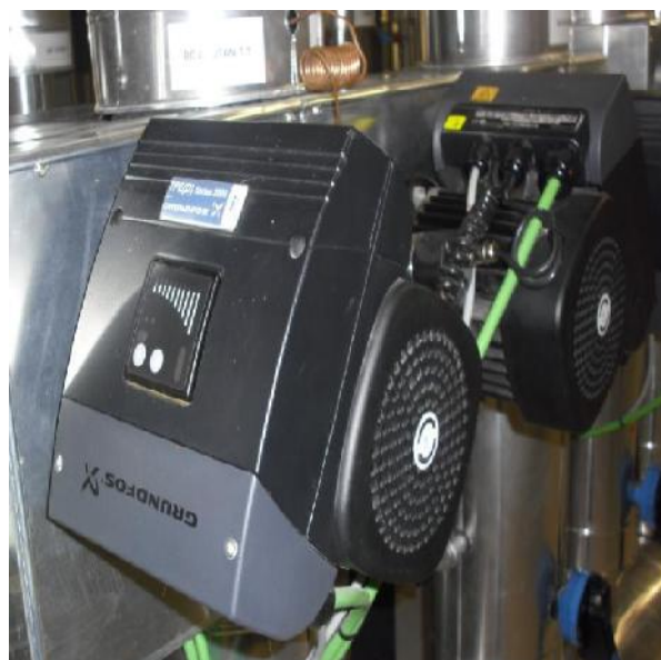
Figura 40 Bomba Circulação AF (UTA 1) com variação velocidade
