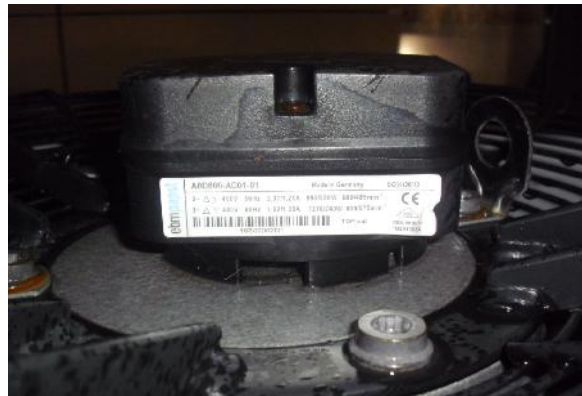
Figura 18 Dry Cooler – Torre de arrefecimento seca
