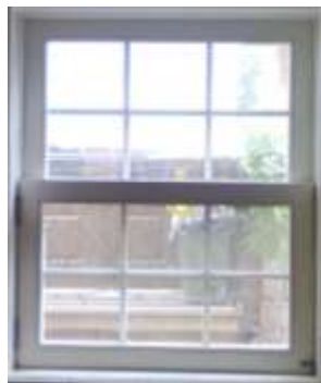
Figura 5.20 - Vista real interior da caixilharia
