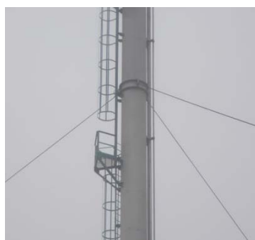
Figura 13 - Ligação das espigas à flare
