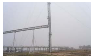
Figura 12 – Ligação de 36” balão-flare
