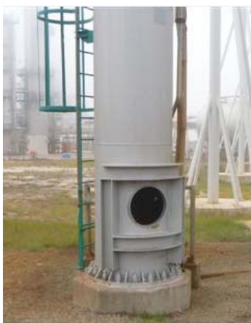
Figura 11 – Ligação das espigas à fundação
