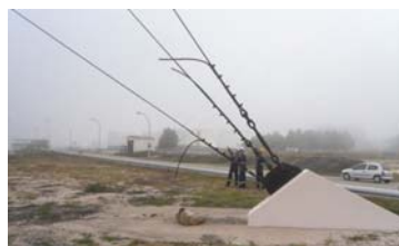
Figura 11 – Ligação das espigas à fundação
