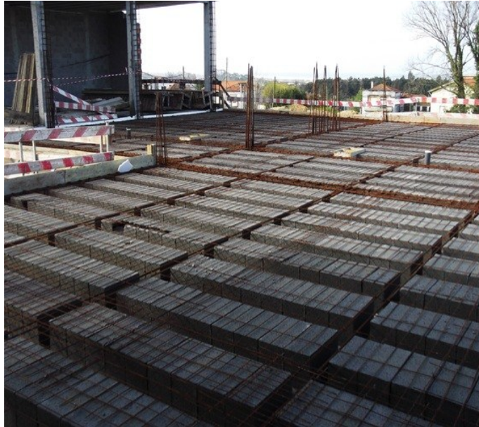
FIGURA 31 - ARMADURAS DA LAJE
