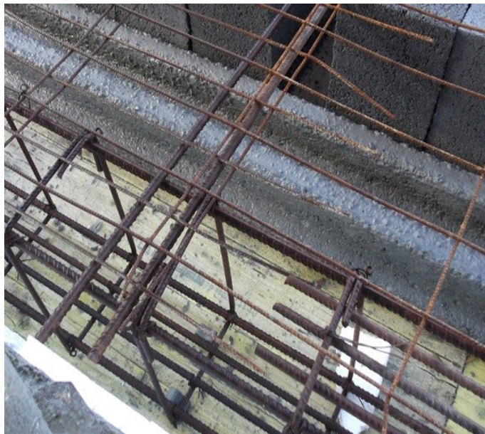
FIGURA 32 - PORMENOR DE AMARRAÇÃO DAS ARMADURAS
