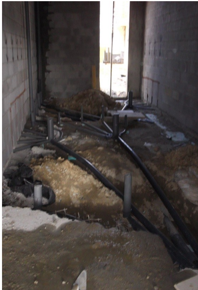
FIGURA 30 - ABERTURA PARA CANALIZAÇÃO
