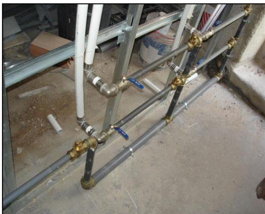
Figura 9 - Instalação da rede de abastecimento de água
