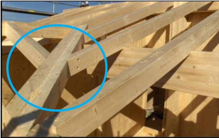
Figura 26 - Exemplo da fixação dos barrotes de madeira num edifício no Porto
