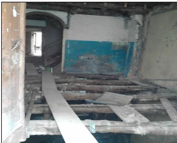
Figura 11 - Pavimento danificado e estrutura de madeira
