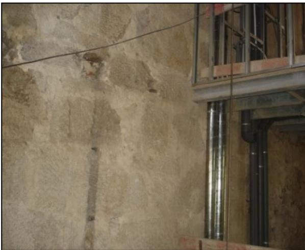
salientar que paredes de grande espessura, como por exemplo, a parede ilustrada na Figura 27, apresenta outro papel preponderante, nomeadamente nas paredes exteriores, que têm como função, proteger o interior do edifício dos agentes atmosféricos, como a ação do vento e da
