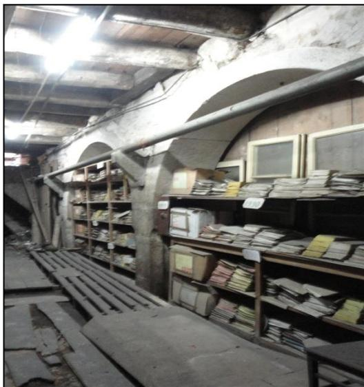
devido à estrutura utilizada ser em pedra ou em tijolo maciço, materiais que têm um bom comportamento à compressão e precário a esforços de flexão e de tração. Então, através do sistema estrutural em arco, é conseguida uma predominância das compressões face a esforços de flexão, assegurando-se, assim, a estabilidade da estrutura do pavimento que
