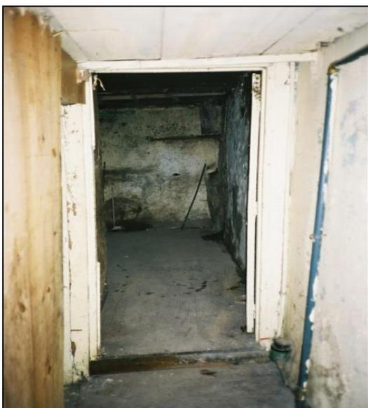
Quanto aos **pavimentos** é de notar que o piso térreo é de betão, e se encontra em mau estado de conservação. A estrutura do pavimento dos restantes pisos é em vigas de madeira, estando estas em estado razoável, sendo revestidas a soalho de madeira, em alguns casos já sem soalho e sem acesso às divisões, visualizando-se pequenas intervenções posteriores (emendas),
