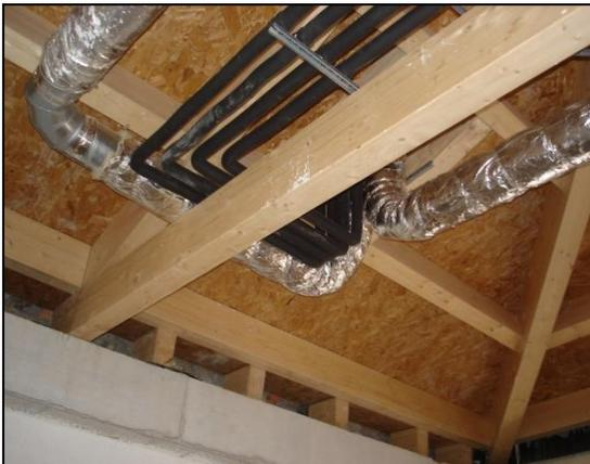
Figura 11 - Cobertura com redes de ventilação já instaladas
