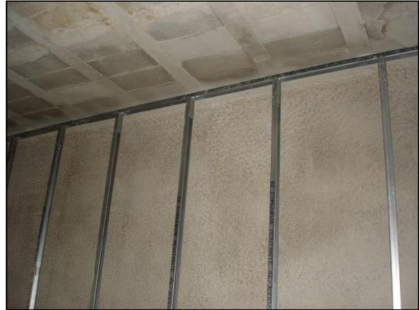
Figura 11 - Instalação dos perfis metálicos e paredes já rebocadas
