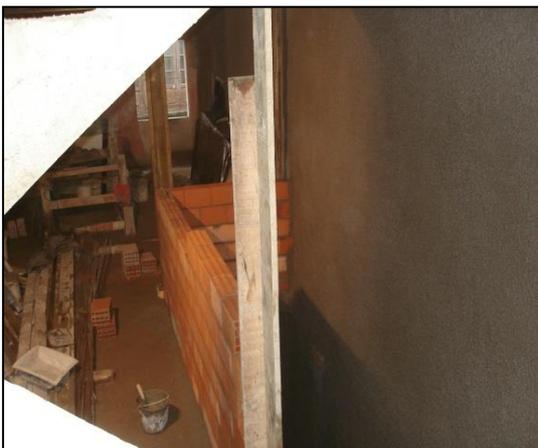
Figura 6 - Execução da parede de alvenaria de tijolo
