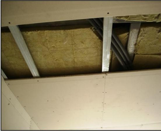
Figura 17 - Colocação dos painéis de gesso cartonado
