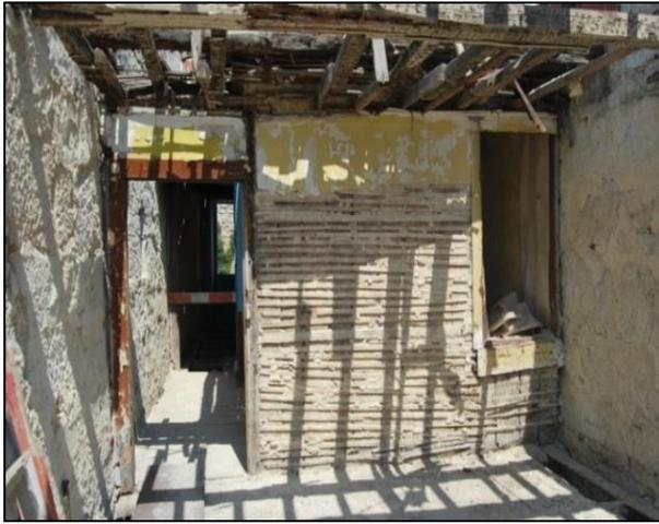
Figura 17 - Parede divisória em tabique em edifício no Morro da Sé, na cidade do Porto
