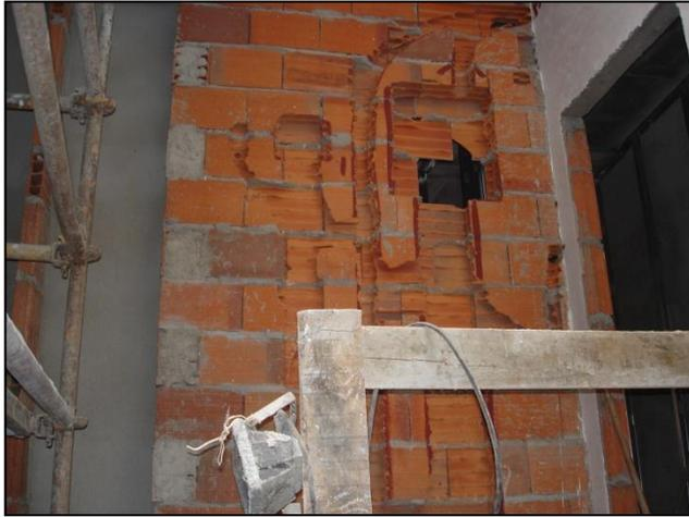
Figura 14 - Parede de alvenaria de tijolo preparada para receber tubagem
