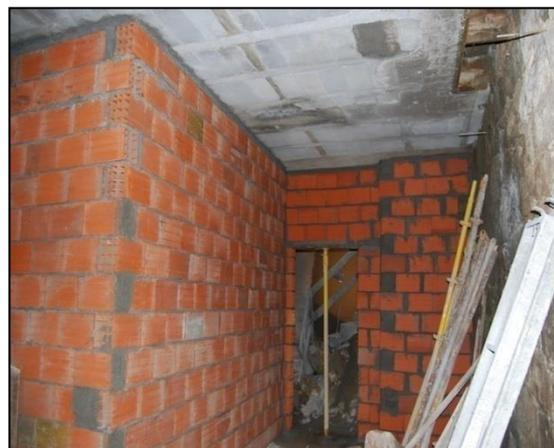
Figura 6 - Parede de alvenaria de tijolo
