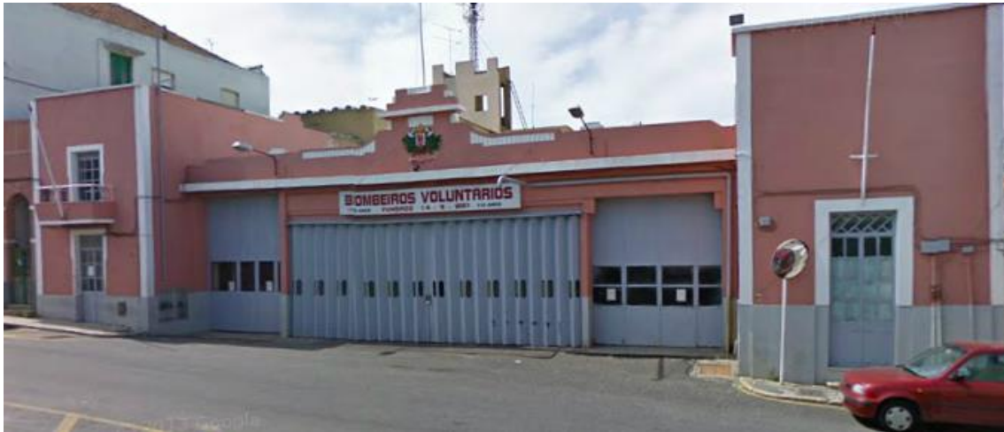
Figura 7 - Antigo Quartel dos Bombeiros de Sacavém
