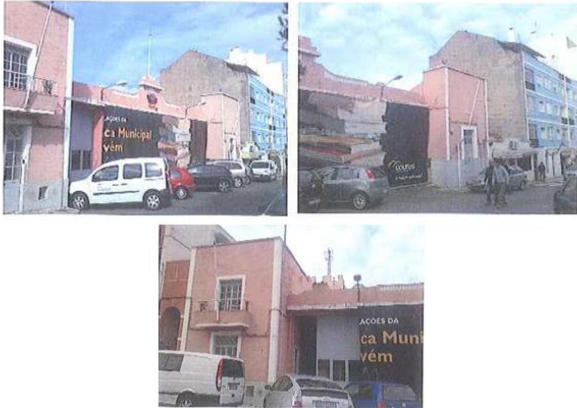
Figura 9 - Levantamento Fotográfico da Visita à Obra
