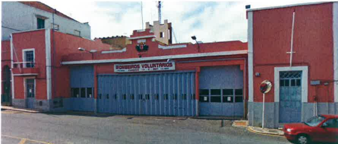
Figura 2: Antigo Quartel dos Bombeiros de Sacavém
