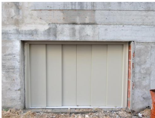
Figura 3.11 Ombreiras do vão de elevador ainda não concluídas
