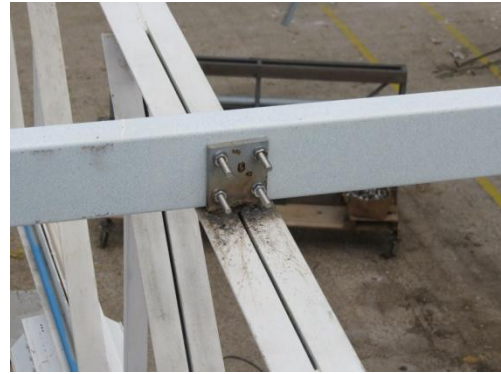
Figura 4.113: Ligação entre estrutura existente e madre C120
