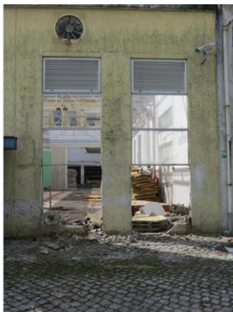
Figura 4.65: Abertura dos vãos V1 e V2
