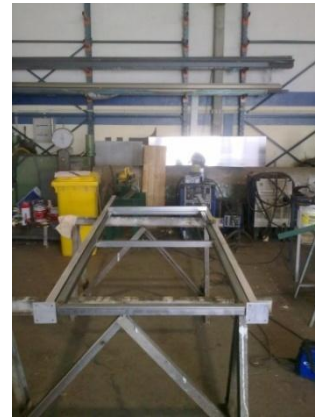
Figura 4.91: Fabricação da porta de vedação
