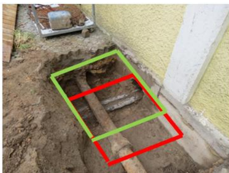
Figura 4.12: Sapata S3 - Movimentação de terra
