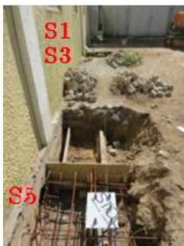
Figura 4.28: Alinhamento dos chumbadouros das sapatas S1, S3, S5
