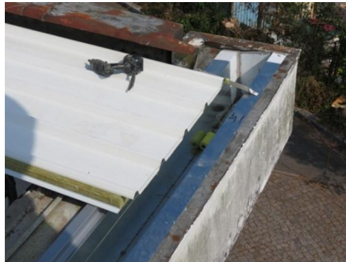
Figura 4.118: Montagem do primeiro painel e colocação do fio guia
