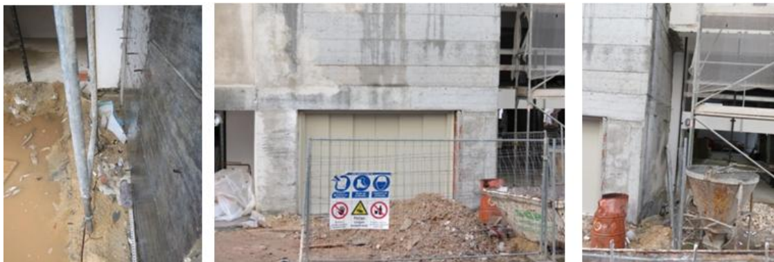
Figura 3.5: Alçado esquerdo, fachada e alçado direito junto ao pavimento do passeio
