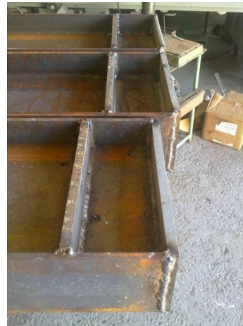
Figura 4.39: Soldadura dos reforços estruturais
