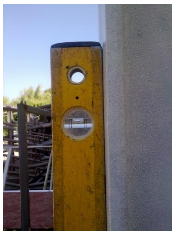
Figura 4.50: Verificação da verticalidade dos pilares
