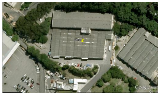
Figura 4.97: Imagem aérea do local
