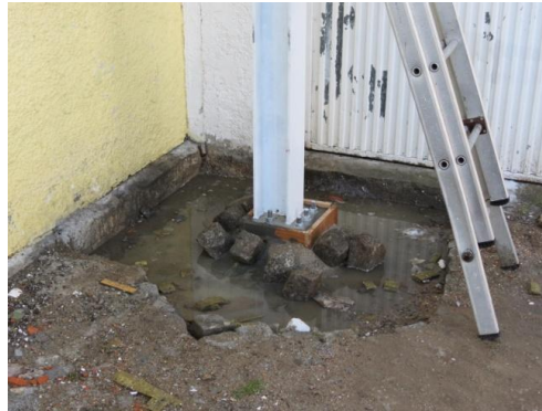
Figura 4.55: Colocação da argamassa tipo "grout" na sapata S1
