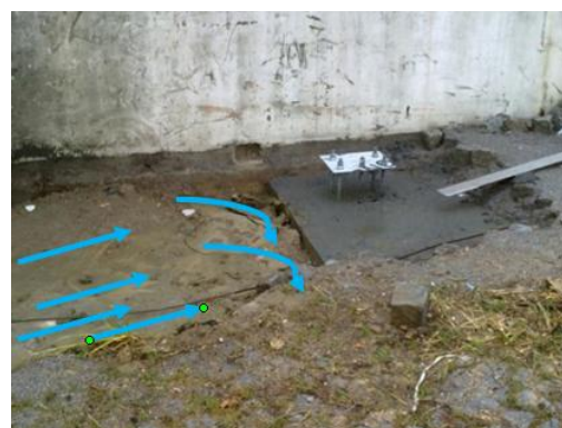
Figura 4.23: Estado do solo e sentido de infiltração da água
