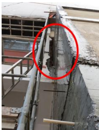
Figura 3.7 Demolição da fachada
