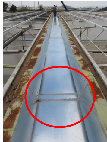
Figura 4.116: Alinhamento final da caleira - Interior oficina
