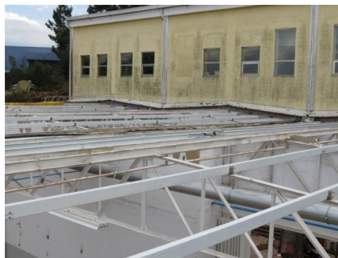
Figura 4.114: Alinhamento final das madres C120
