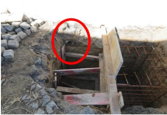
Figura 4.17: Colocação de cofragem da Sapata S2 e armadura
