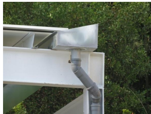
Figura 4.45: Aplicação da caleira de recolha de águas pluviais
