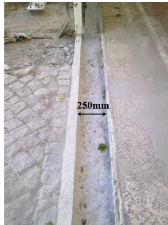
Figura 4.78: Rasgo para colocação da calha guia
