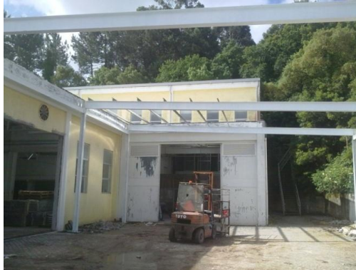
Figura 4.48: Utilização do empilhador para colocação das madres Z140
