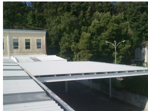
Figura 4.57: Vista da cobertura do coberto
