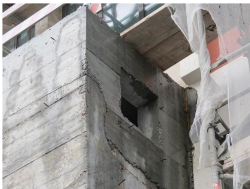
Figura 3.12 Vão da casa das máquinas
