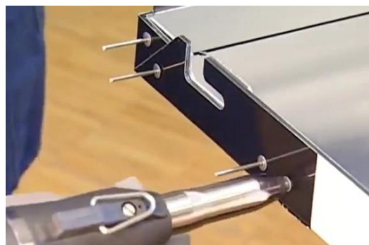
Figura 3.28: Aplicação do reforço do perno exterior
