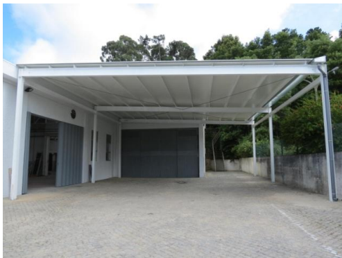
Figura 4.56: Vista frontal do coberto
