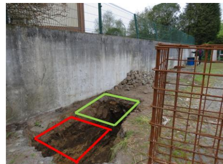
Figura 4.13: Sapata S6 - Movimentação de terra
