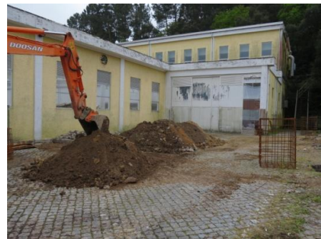
Figura 4.14: Movimentação de terra devido a replantação das sapatas
