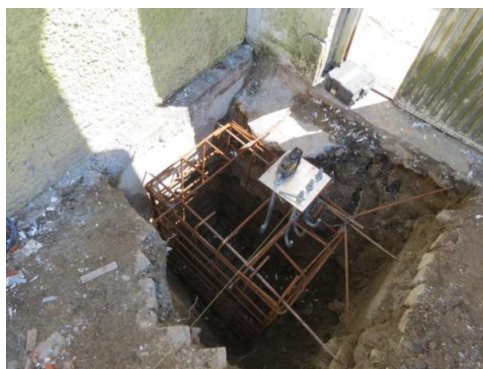
Figura 4.26: Posicionamento do chumbadouro na sapata S1
