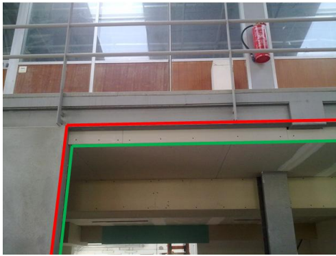
Figura 4.63: Alinhamento do projeto (vermelho) e Alinhamento intermedio (verde) do vão D6
