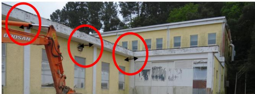
Figura 4.9: Platibanda do edifício existente
