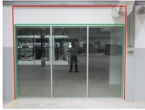
Figura 4.62: Alinhamento do projeto (vermelho) e Alinhamento final (verde) do vão D5
