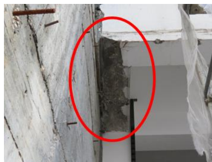
Figura 3.8 Demolição para colocação de cofragem
