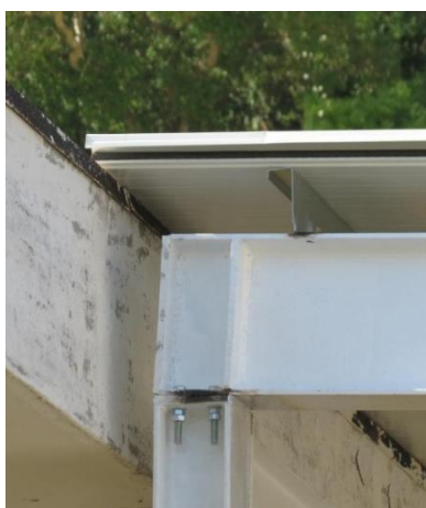
Figura 4.51: Ligação Pilar HEB160 com Viga IPE330
