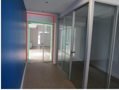
Figura 4.61: Alinhamento do projeto (vermelho) e Alinhamento final (verde) do vão D3
