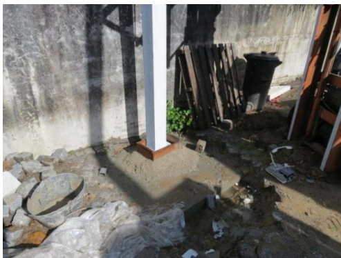
Figura 4.53 Colocação da argamassa tipo "grout" nos chumbadouro
