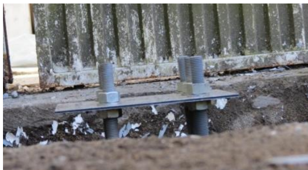
Figura 4.27: Sistema de nivelamento de porca e contra porca
