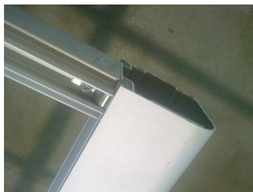
Figura 4.73: Ligação entre travessa e prumo de canto
