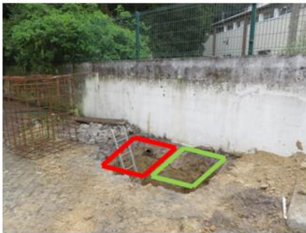
Figura 4.11: Sapata S2 - Movimentação de terra
