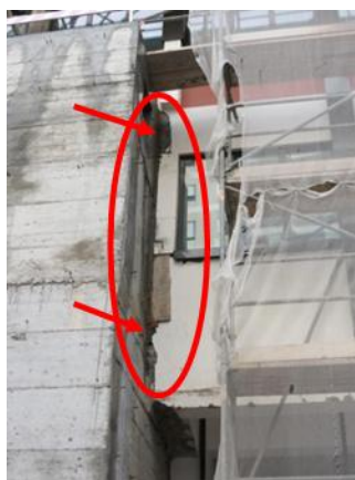
Figura 3.9 Restos de betonagem
