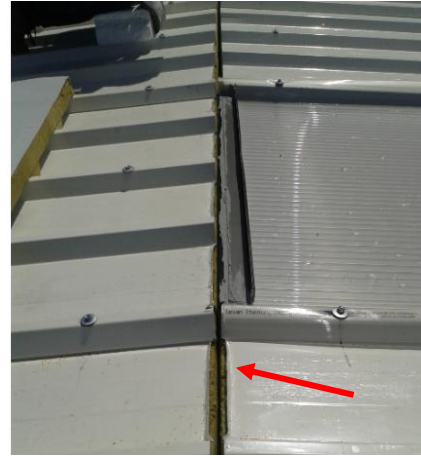
Figura 4.120: Quinagem da chapa superior do painel de cobertura
