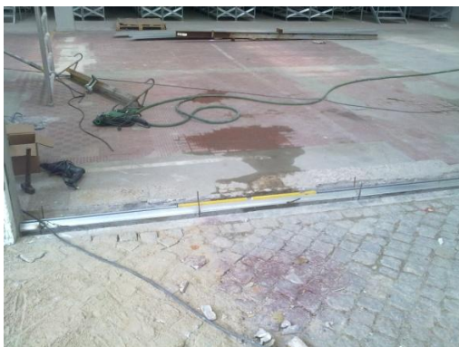
Figura 4.79: Colocação e nivelamento da calha guia
