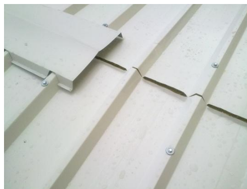
Figura 4.123: Pormenor da colocação da cumeeira
