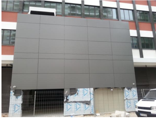
Figura 3.78 Fachada principal da zona intervencionada
