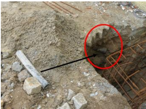
Figura 4.19: Colocação da armadura Sapata S1; Bocado de ramal de ligação de água pluvial cortado
