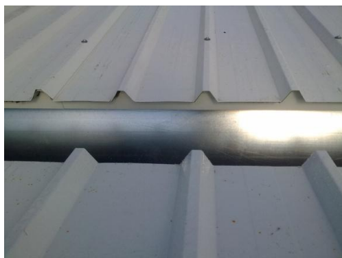
Figura 4.122: Colocação do solape
