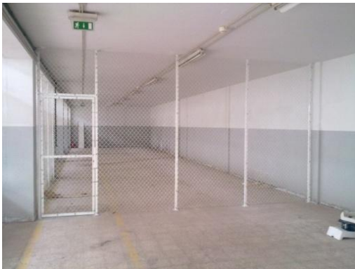
Figura 4.92: Montagem da rede de vedação
