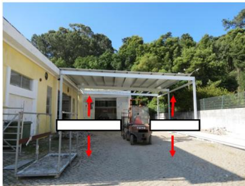
Figura 4.47: Elevação dos painéis de cobertura
