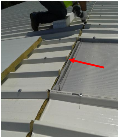
Figura 4.119: Colocação de cantoneira
