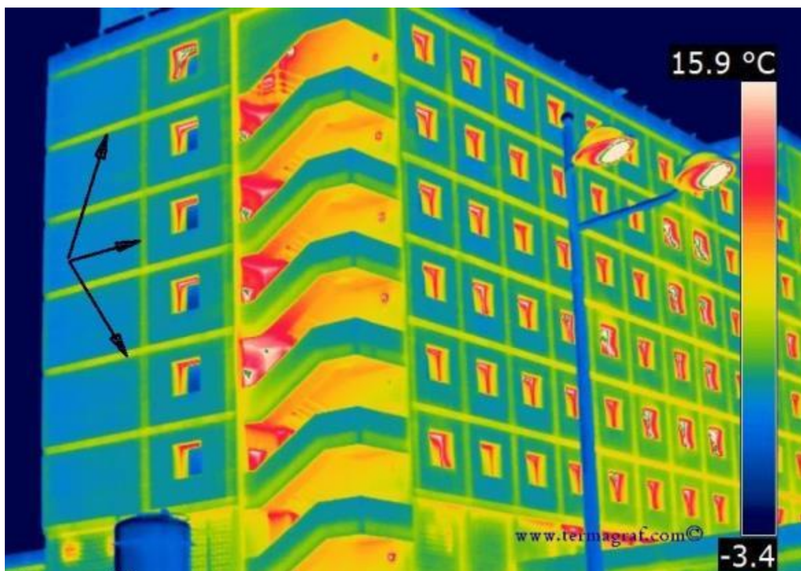
Figura 19 - Imagem termográfica de um edifício ( facingyconst.blogspot.com ).
