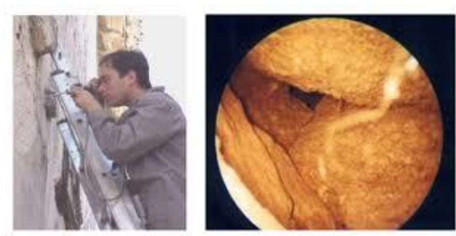
Figura 22 - Observação boroscópica de fendas e cavidades ( reabilitacaodeedificios.dashofer.pt ).
