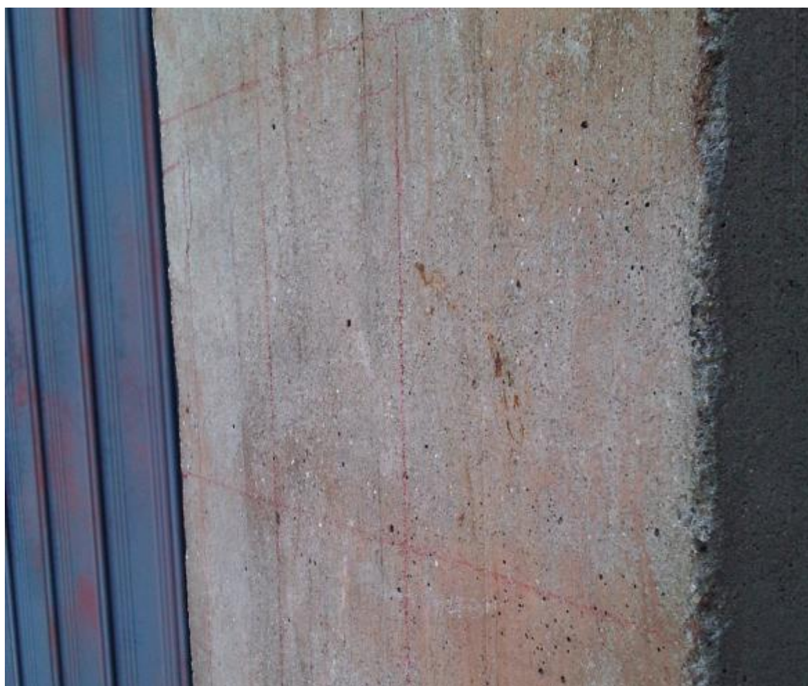
Figura 48 – Marcações da grelha das armaduras após deteção com ferramenta Quick Scan.
