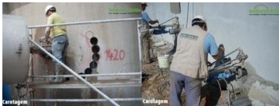
Figura 4 – Demonstração da extração de carote para análise ( www.leircortabetao.pt ).
