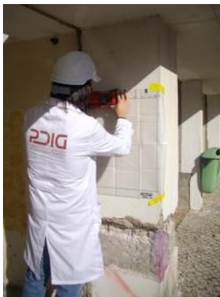
Figura 10 – Ensaio de deteção de armaduras ( www.pdig.pt ).
