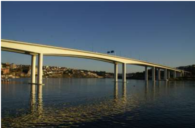
Figura 1.5 – Ponte do Freixo, no Porto (António Reis, 1995)
