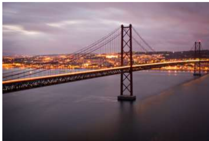
Figura 1.12 – Ponte 25 de Abril, Lisboa
