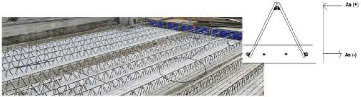
Figura 5.32 – Representação das armaduras nas treliças metálicas.
