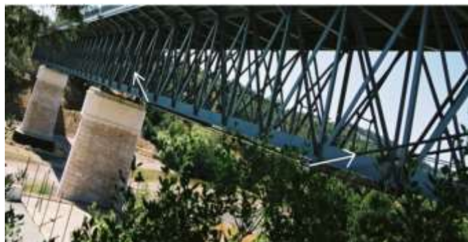
Figura 1.27 – Pré-esforço exterior para reforço da ponte sobre o rio Zêzere
