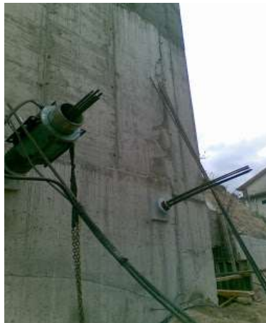
Figura 1.26 – Ancoragens em estruturas de suporte
