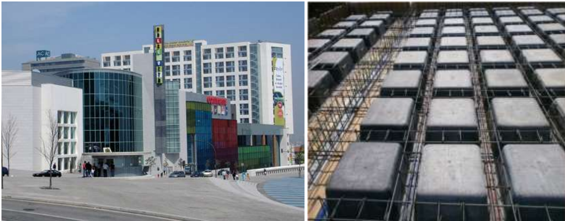
Figura 1.1 - Centro comercial Dolce Vita, com blocos recuperáveis – Porto
