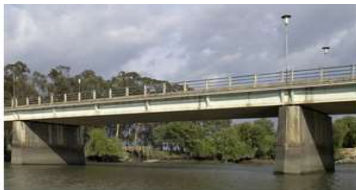
Figura 1.16 - Ponte da Vala Nova
