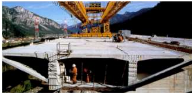
Figura 1.25 – Ponte pré-esforçada em balanços sucessivos
