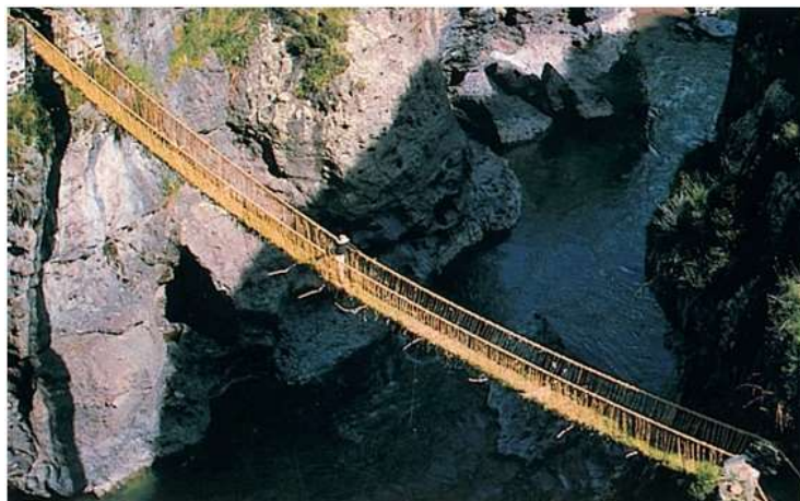
Figura 1.8 - Ponte suspensa primitiva sobre uma ravina no Peru. Constituída por cordas de fibras vegetais trançadas.
