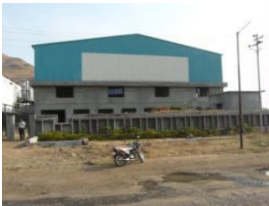
Figura 29- Vista frontal do edifício
