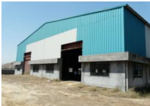
Figura 31- Vista traseira do edifício
