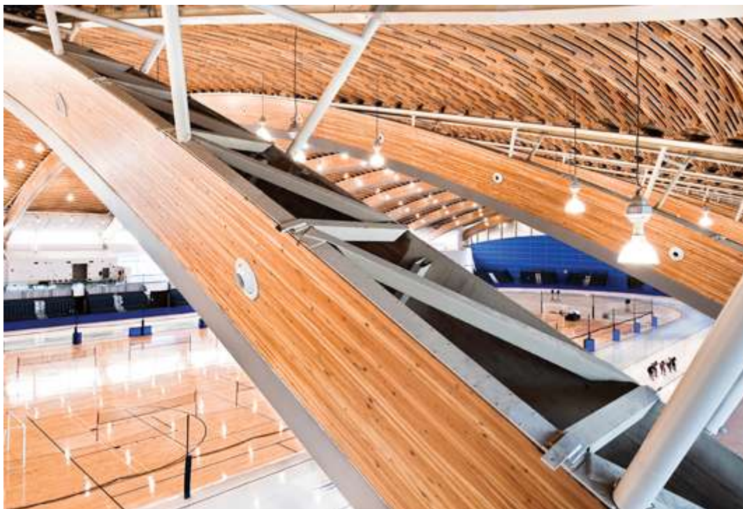
Figura 12 Exemplo de aplicação de adesivos estruturais fenólicos nas ligações entre metais e madeiras [3].
