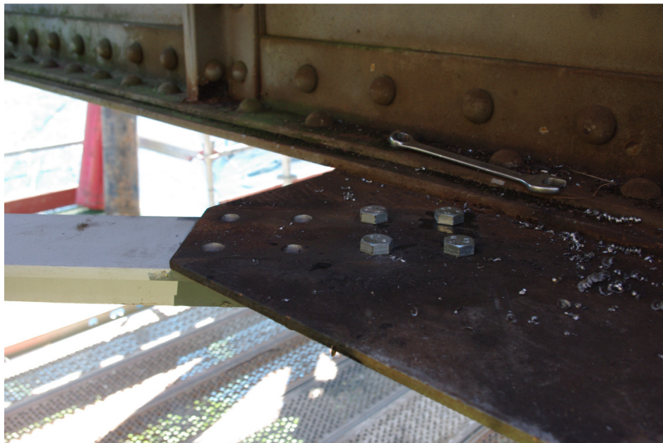
Figura 5 – Remoção dos parafusos dos perfis metálicos
