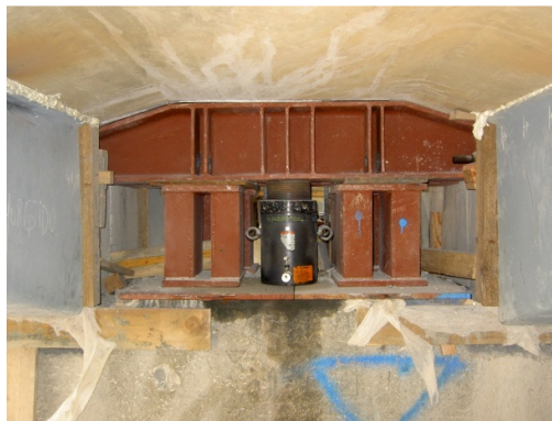
Cilindros hidráulicos com patilha de segurança "Energac"
