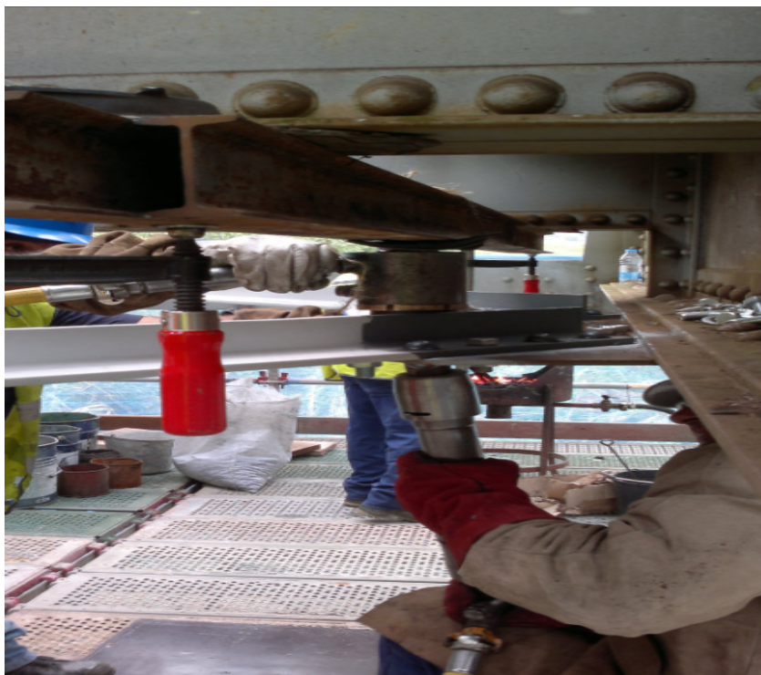
Figura 6 – Colocação de Rebites novos
