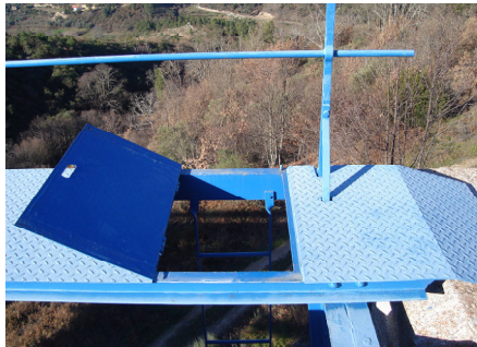
Fotografia 01: Exemplo de aplicação de chapas em prumos de guarda corpos dos passeios e pormenor da chapa de entrada e saída no passeio.
