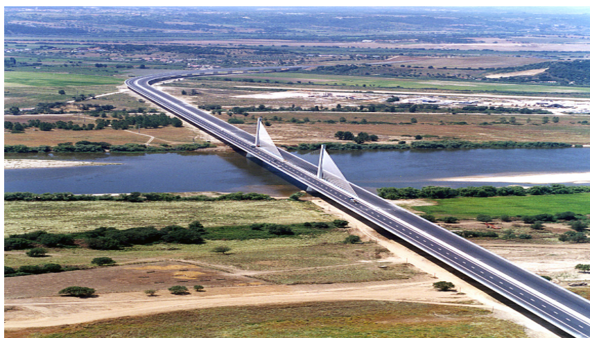
Figura 1 - Ponte Salgueiro Maia
