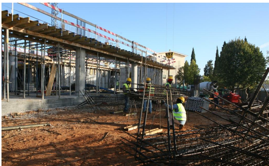
Figura 28 - Montagem da cofragem da laje do Piso 1 do edifício E da E.S. Dr. Manuel Fernandes (CONDURIL, 2011)
