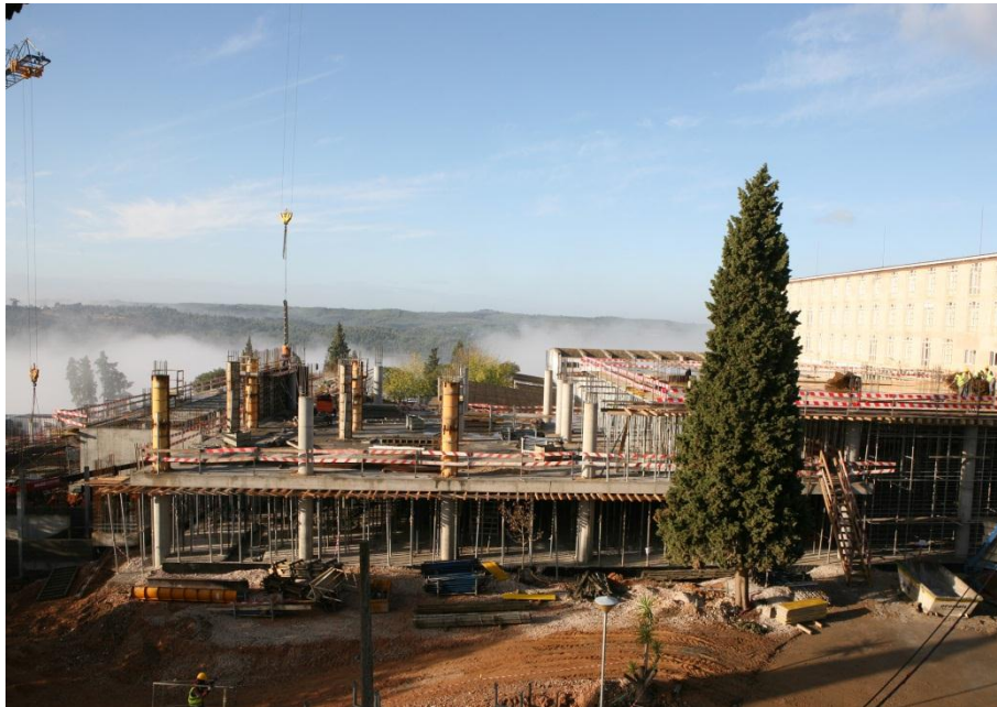
Figura 26 - Execução da estrutura do Piso 1 do edifício E da E.S. Dr. Manuel Fernandes (CONDURIL, 2011)
