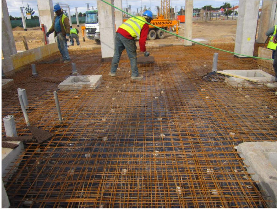
Figura 35 - Montagem das armaduras da laje de pavimento do Edifício da GNR da CAM de Grândola (CONDURIL, 2011)
