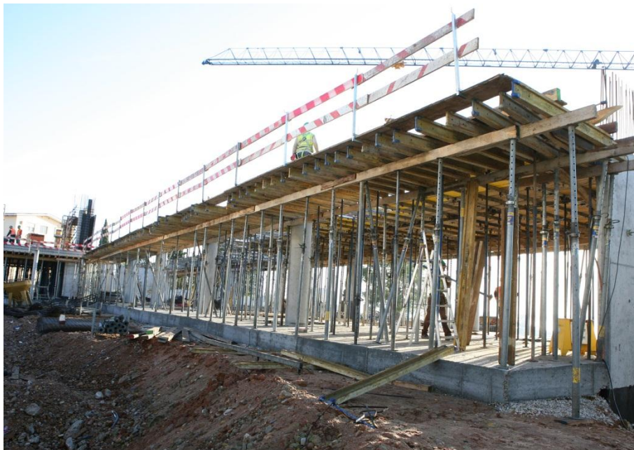
Figura 26 - Execução da estrutura do Piso 1 do edifício E da E.S. Dr. Manuel Fernandes (CONDURIL, 2011)
