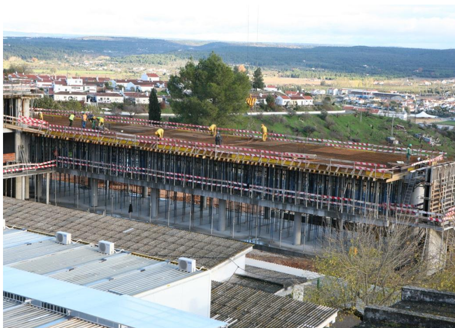
Figura 30 - Montagem da cofragem da laje do Piso 2 do edifício E da E.S. Dr. Manuel Fernandes (CONDURIL, 2011)
