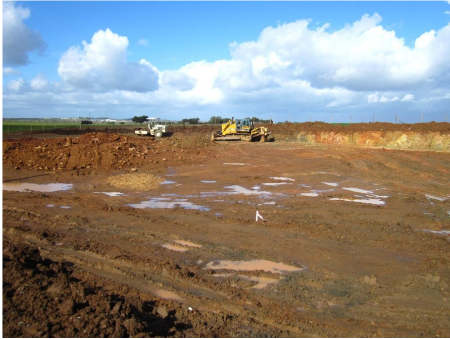
Figura 33 - Terraplanagem e compactação do terreno da CAM de Grândola (CONDURIL, 2011)
