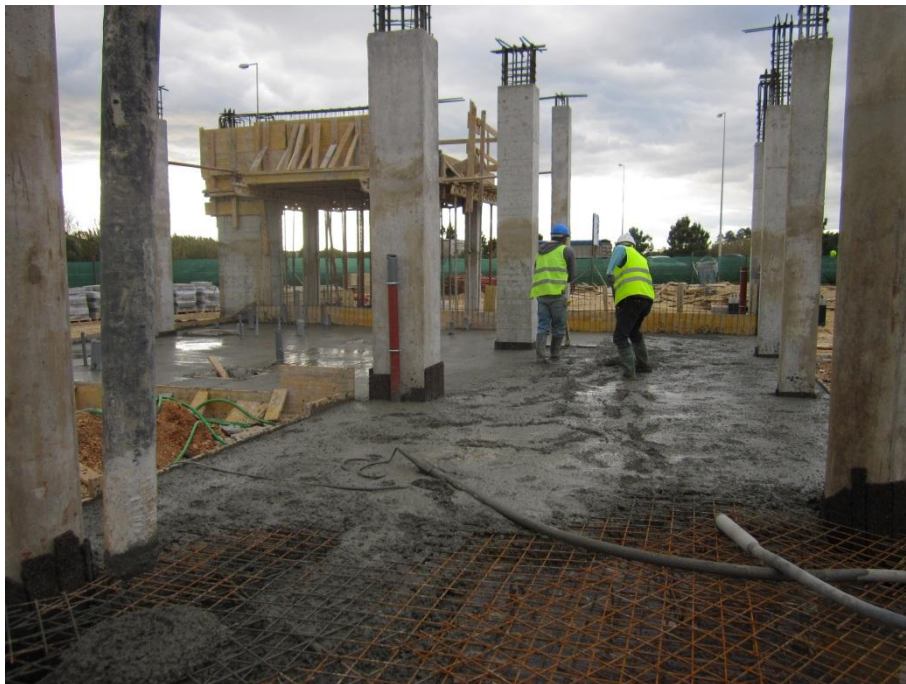
Figura 36 - Betonagem da laje de pavimento do Edifício da GNR da CAM de Grândola (CONDURIL, 2011)
