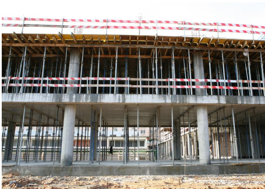
Figura 30 - Montagem da cofragem da laje do Piso 2 do edifício E da E.S. Dr. Manuel Fernandes (CONDURIL, 2011)
