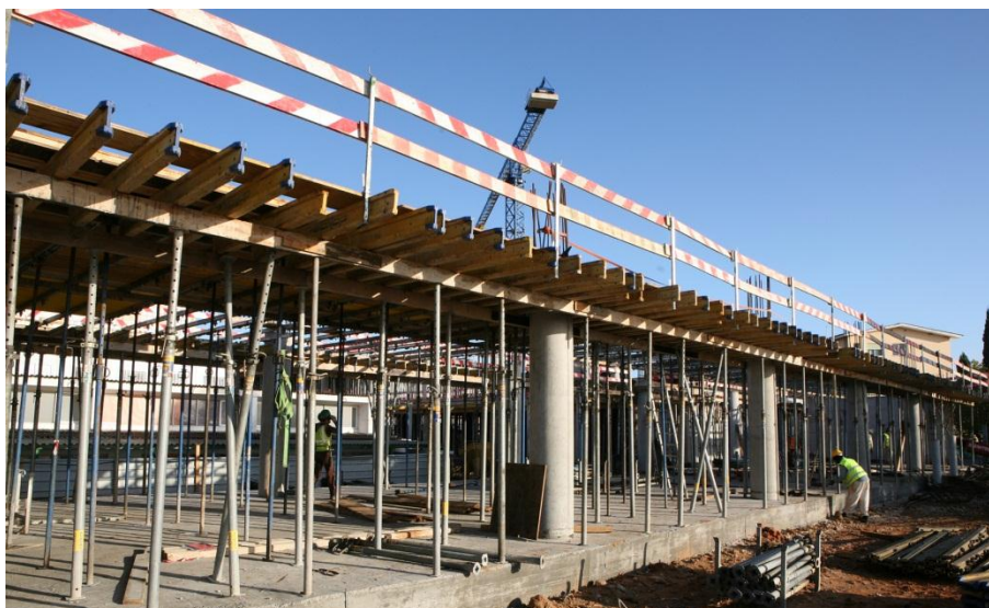
Figura 28 - Montagem da cofragem da laje do Piso 1 do edifício E da E.S. Dr. Manuel Fernandes (CONDURIL, 2011)
