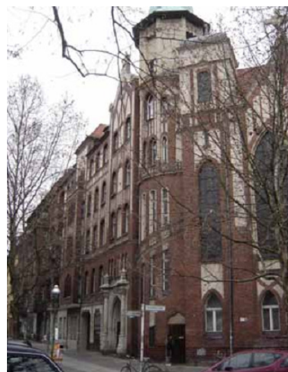
Fig. 1 – Vista do edifício em estudo
