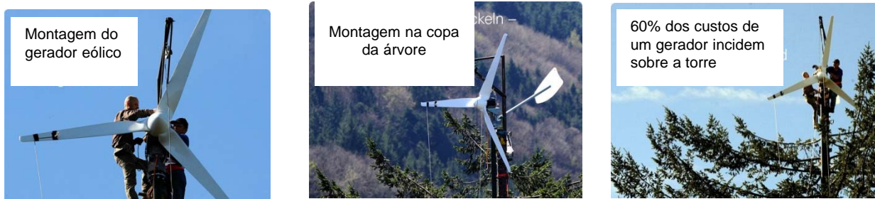
Figura 3 - Fases de montagem de geradores eólicos na copa de uma árvore (Fonte: www.freeenergyweb.eu )
