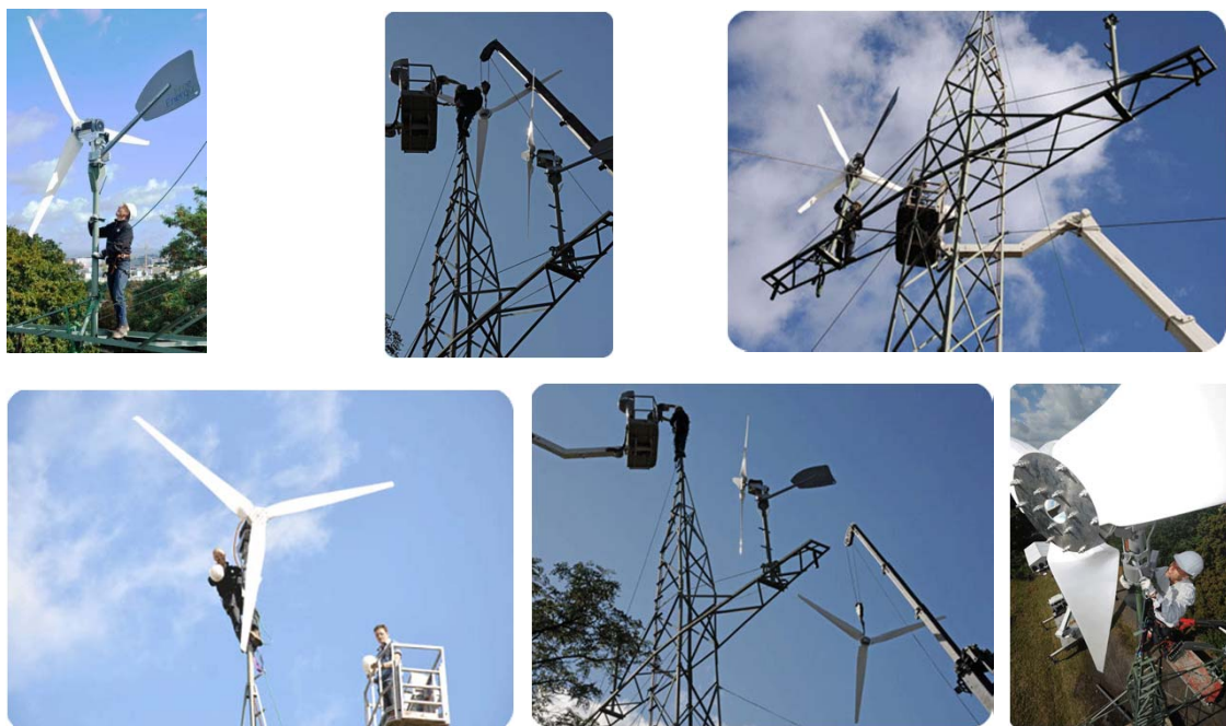
Figura 1 – Montagem dos geradores eólicos em poste elétrico existente (Fonte: www.freeenergyweb.eu )
