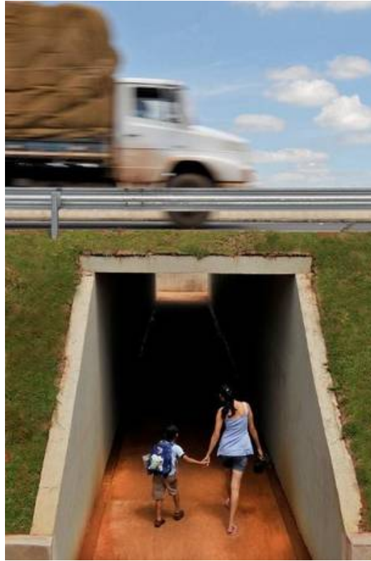
Figura 66 – Passagem inferior de peões
