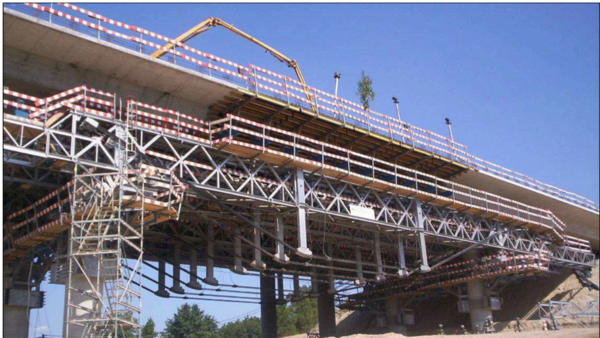
Figura 107 – Exemplo de estrutura construída com sistema OPS
