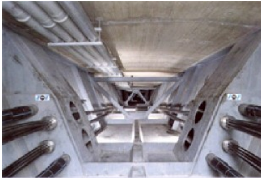
Figura 63 - Pré-esforço exterior
