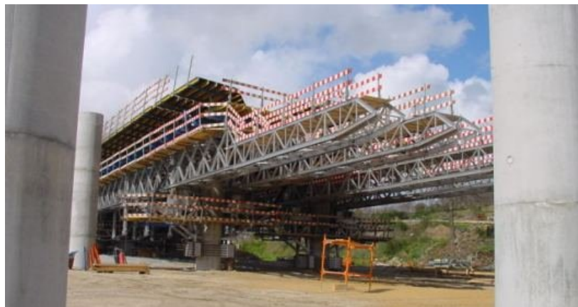
Figura 104 – Viga de lançamento inferior
