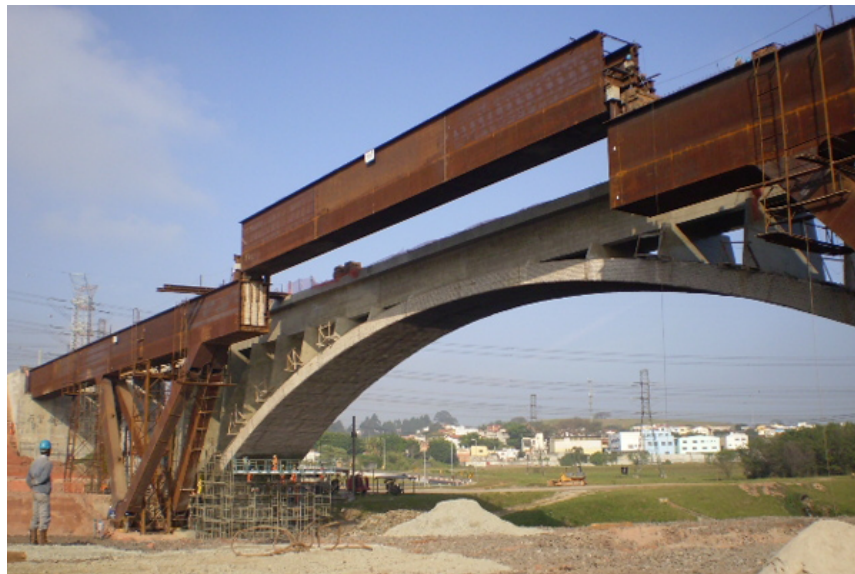
Figura 128 – Viga metálica em caixão
