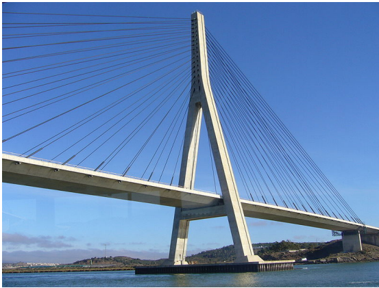
Figura 116 – Ponte do Guadiana
