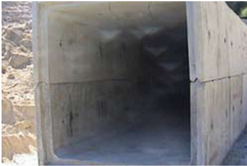
Figura 69 – Duas peças em U, Box Culvert
