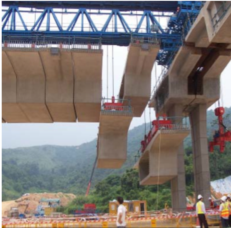
Figura 52 - Colocação de aduelas na posição final com auxílio de guinchos de elevação
