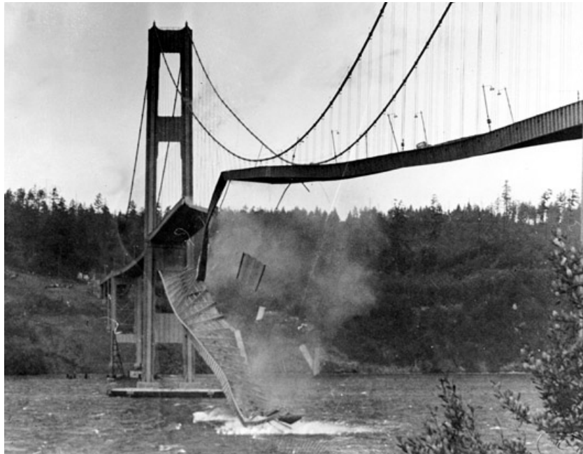
Figura 151 – Colapso da ponte Tacoma
