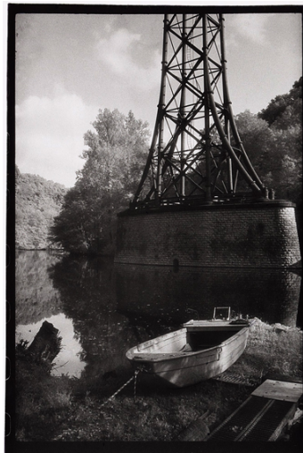
Figura 13 – Apoios do viaduto de Rouzat
