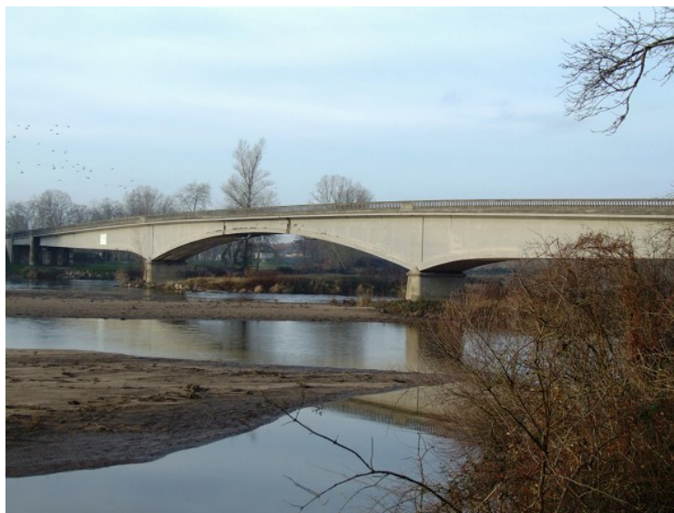
Figura 29 – Ponte La Veudre, França
