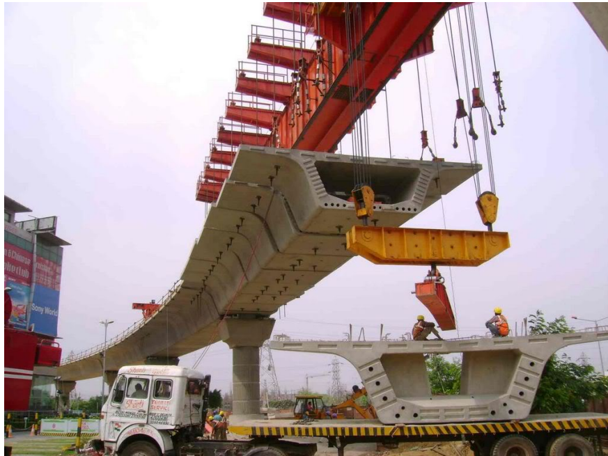
Figura 49 – Guindaste para colocação das aduelas pré-fabricadas
