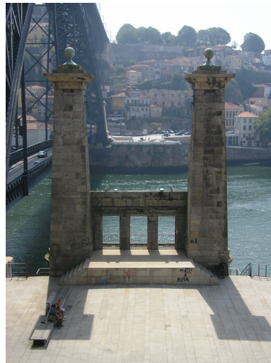
Figura 123 – Pilares de apoio da ponte D. Maria II
