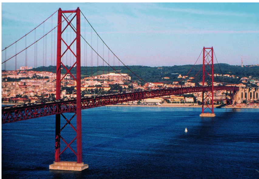
Figura 122 – Ponte 25 de Abril, Lisboa
