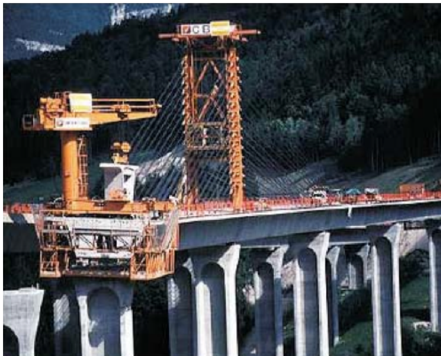
Figura 54 – Colocação de tirantes com auxílio de torres provisórias
