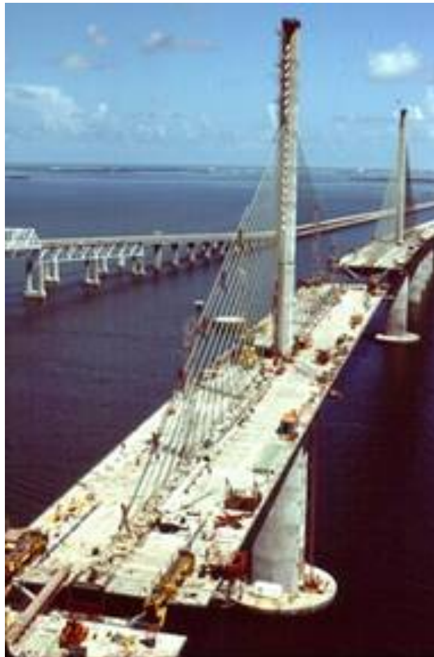
Figura 55 - Ponte Sunshine Skyway em construção, EUA
