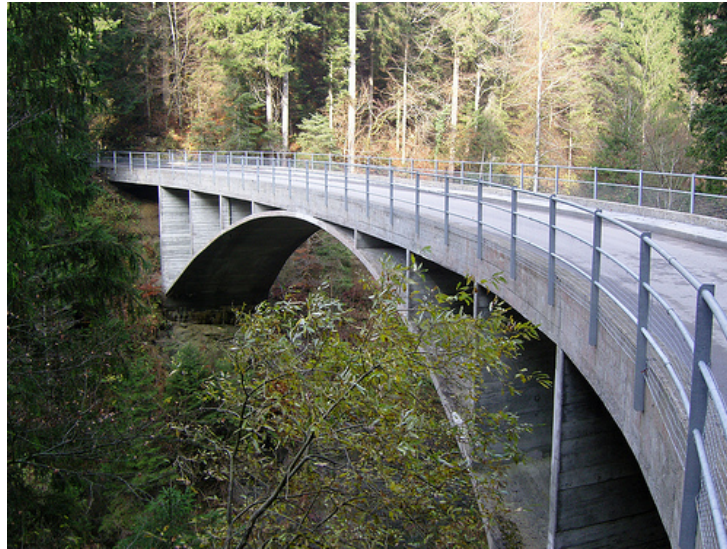
Figura 28 – Ponte Schwandbach, Suíça
