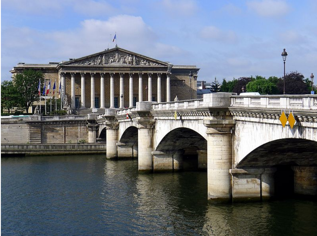
Figura 6 - Ponte de la Concorde em Paris, França
