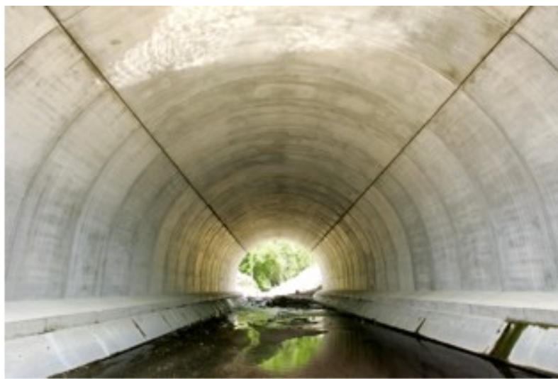
Figura 72 – Aplicação do sistema Matière
