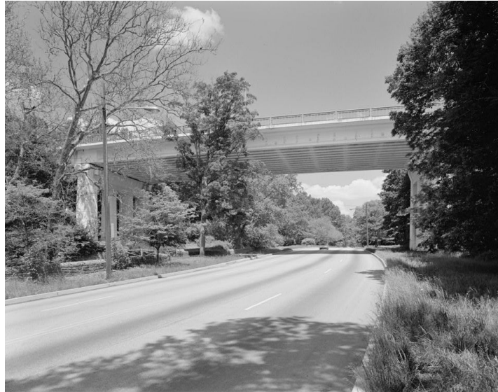
Figura 31 – Ponte Walnut Lane, EUA
