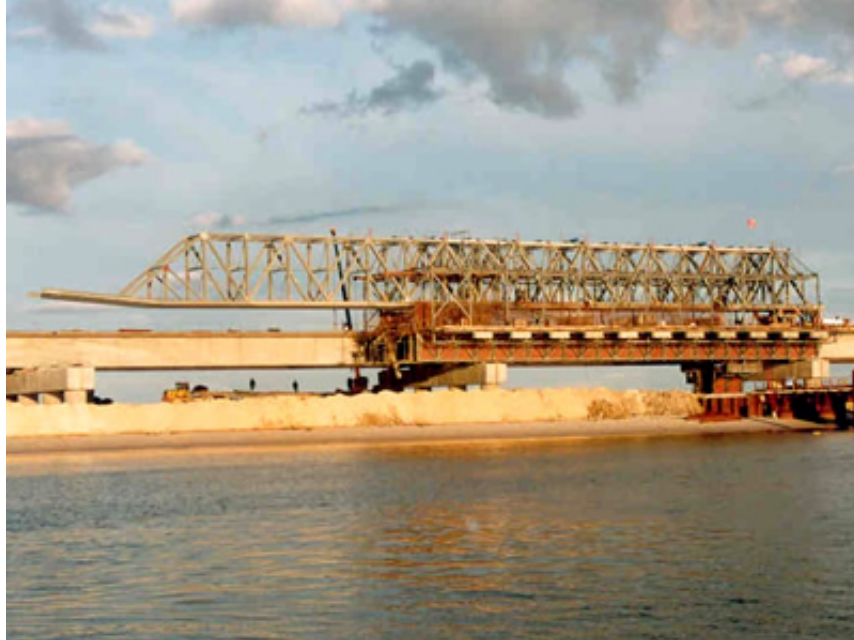
Figura 102 – Viga de lançamento
