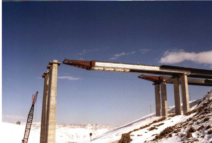
Figura 95 – Sistema de lançamento incremental
