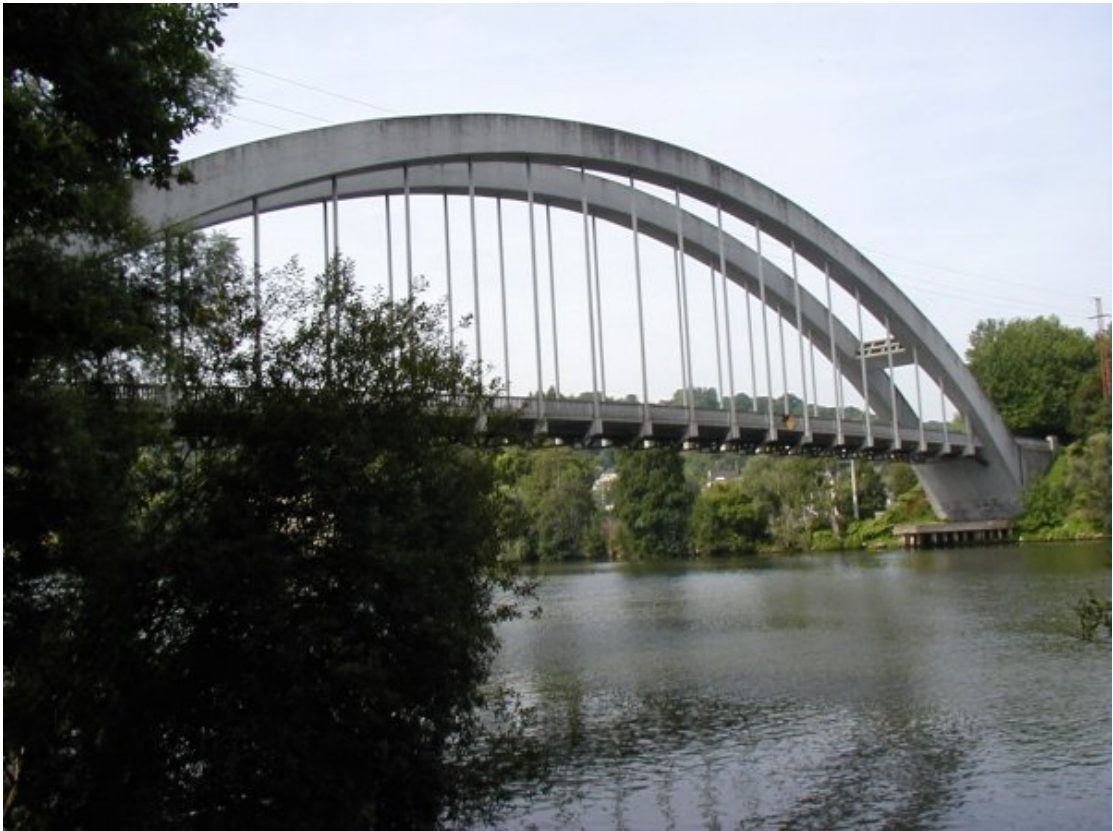
Figura 24 – Ponte Vauvray, França
