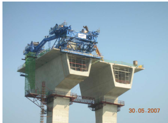
Figura 90 – Avanços Sucessivos em viga
