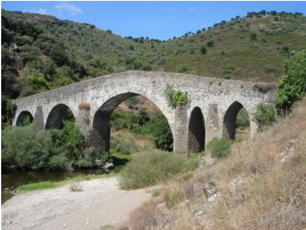
Figura 2 – Ponte com arco ogival
