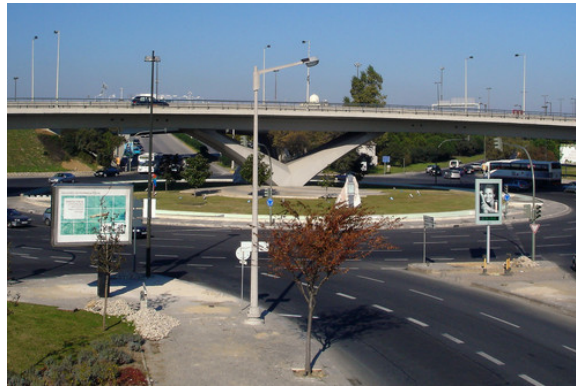
Figura 45 – Vista do Viaduto da Praça do Relógio
