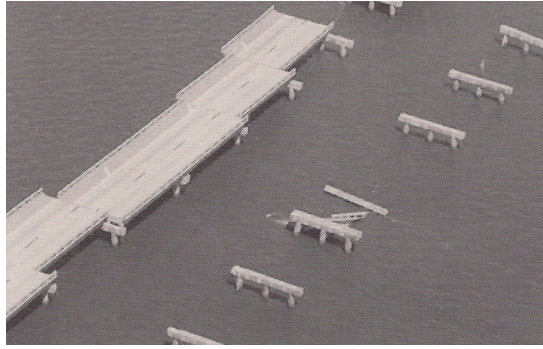
Figura 142 – Queda de uma ponte por acção de um furacão
