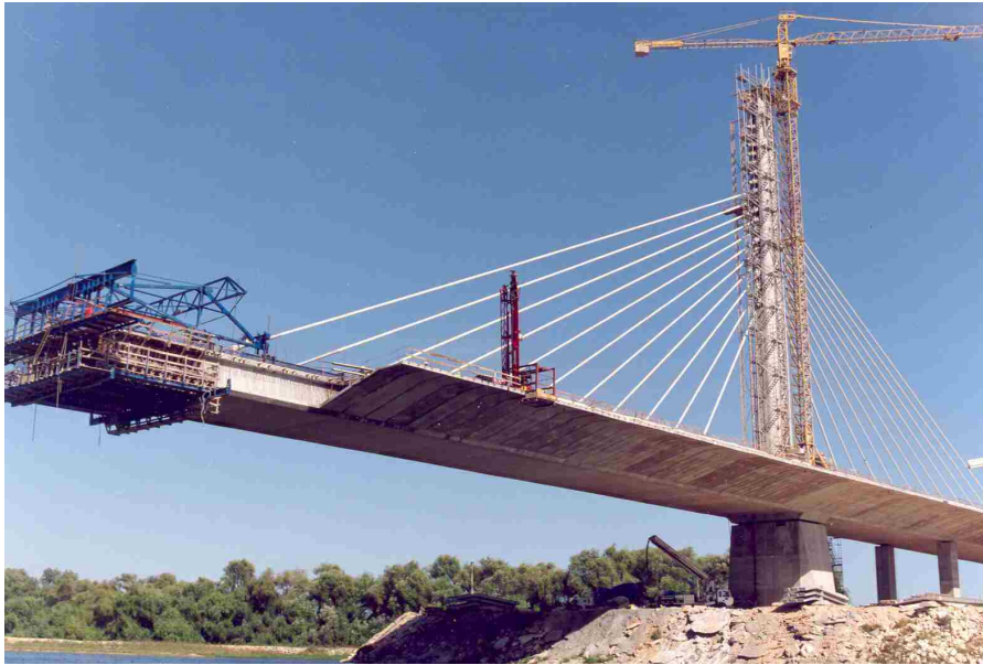
Figura 112 – Construção da ponte Salgueiro Maia, Santarém
