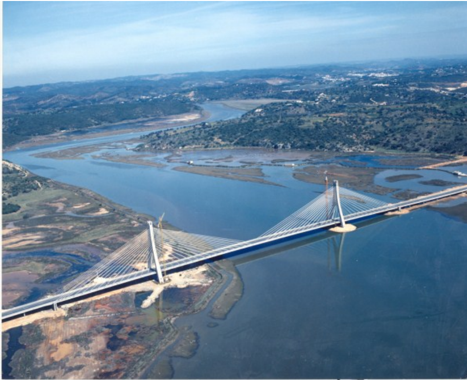
Figura 89 – Ponte sobre o Rio Arade, Portimão
