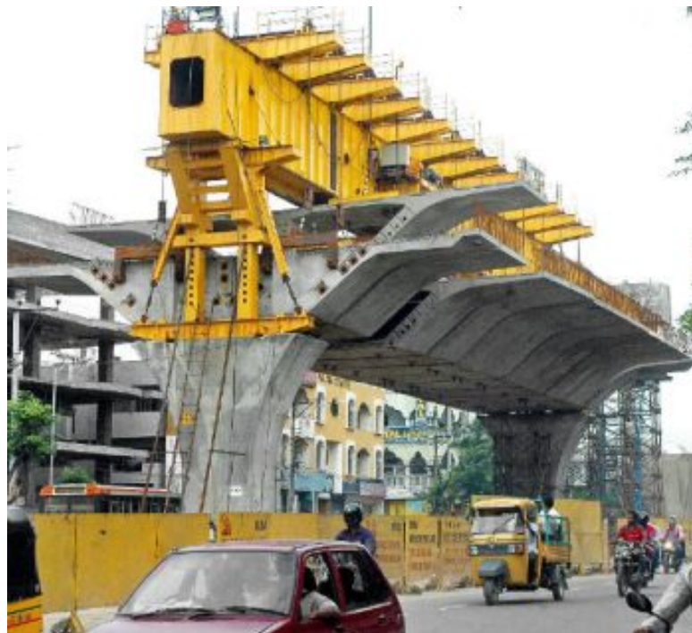
Figura 48 – Lançadeira para colocação das aduelas pré-fabricadas
