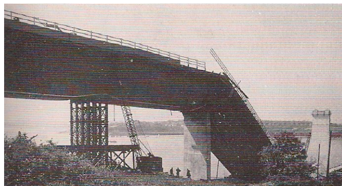
Figura 130 – Colapso da Ponte Cleddau
