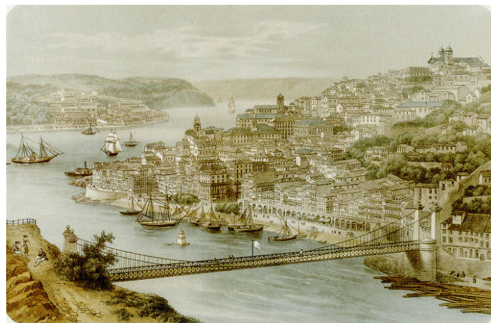
Figura 124 – Ponte D. Maria II
