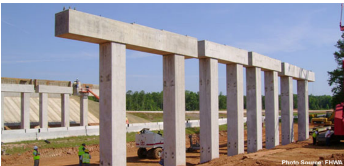
Figura 41 – Pilares de vigas de uma ponte pré-fabricados
