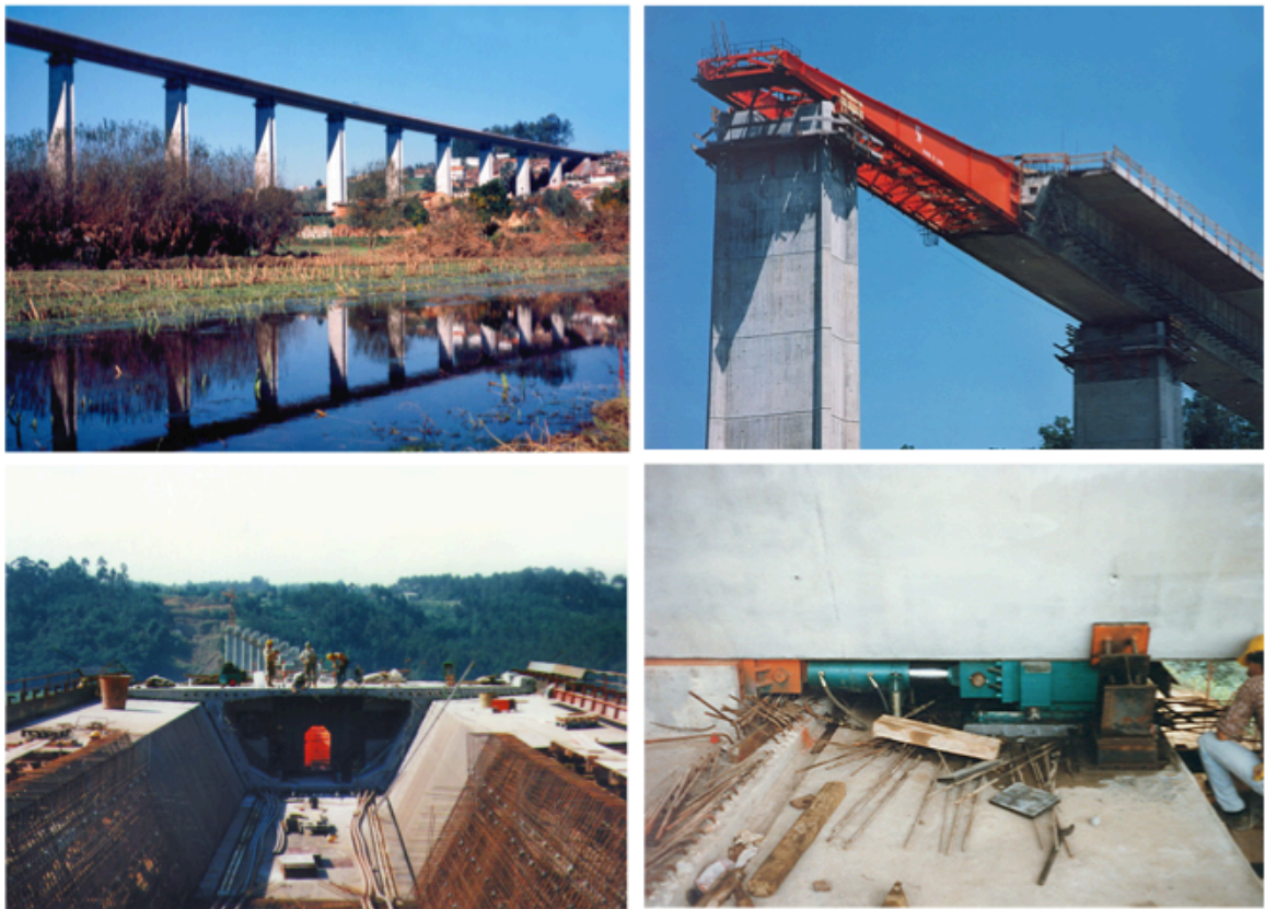
Figura 101 - Construção da ponte sobre o rio Águeda
