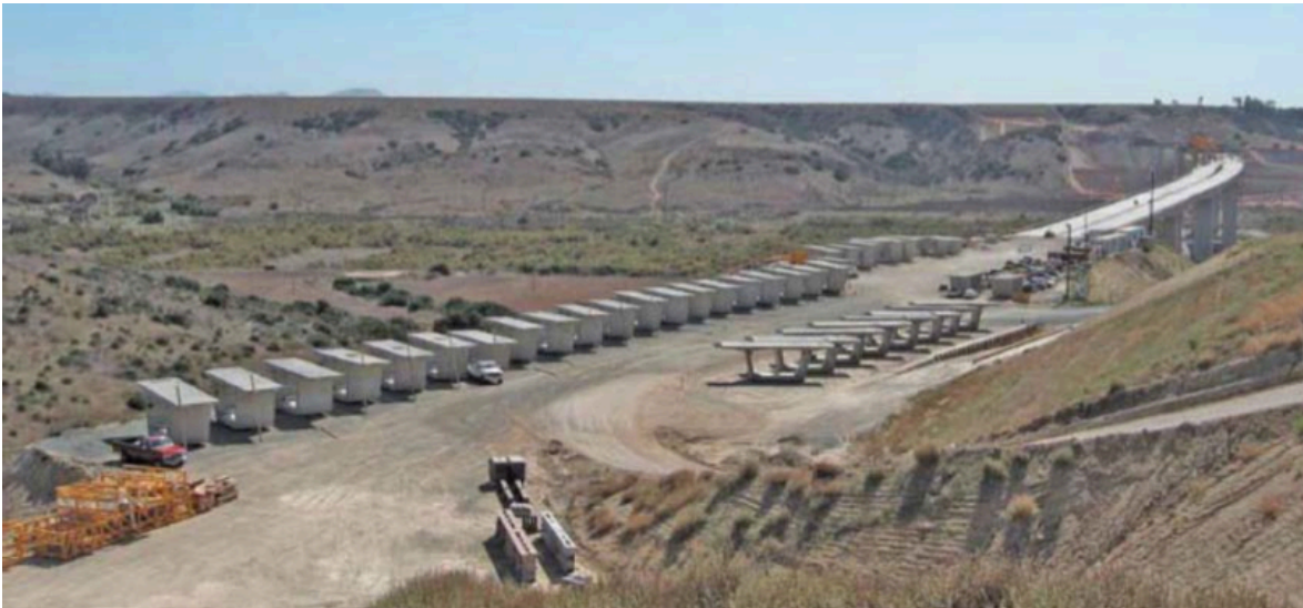
Figura 58 - Estaleiro de aduelas pré-fabricadas
