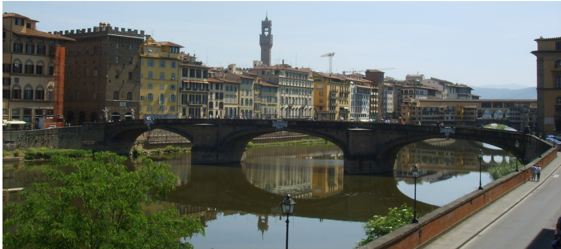
Figura 4 – Ponte Santa Trinitá em Florença, Itália
