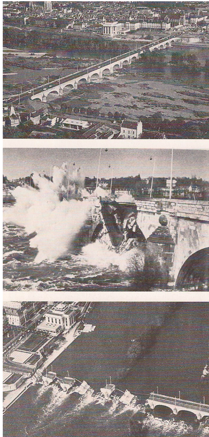
Figura 141 – Sequência da queda de uma ponte por inundação
