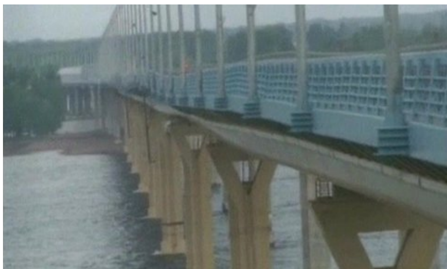
Figura 152 – Ponte Volgograd em ressonância
