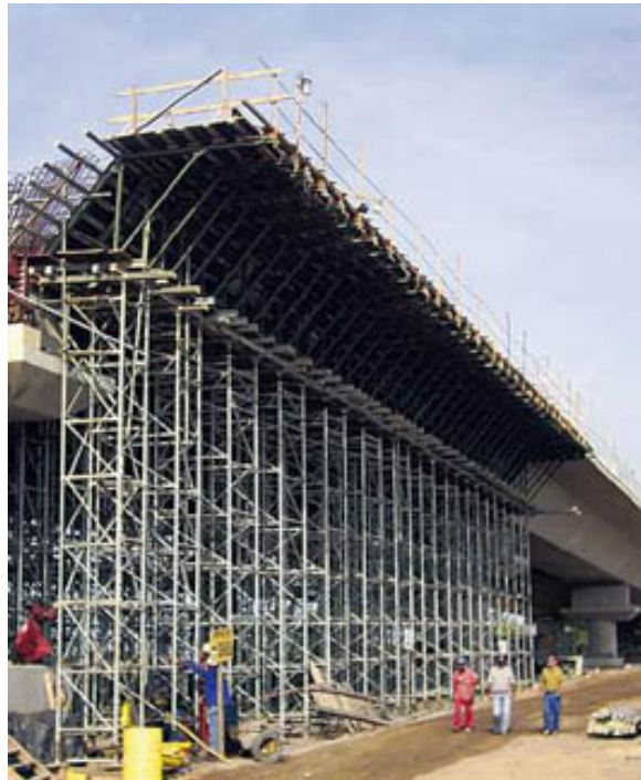
Figura 74 – Solução de cimbra ao solo
