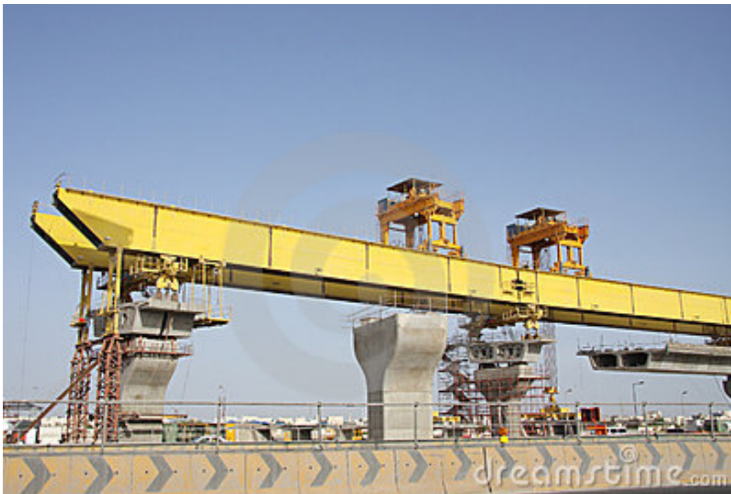
Figura 105 – Viga de lançamento de assemblagem
