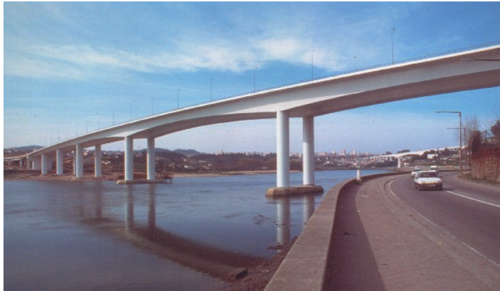
Figura 87 – Ponte do Freixo, Porto
