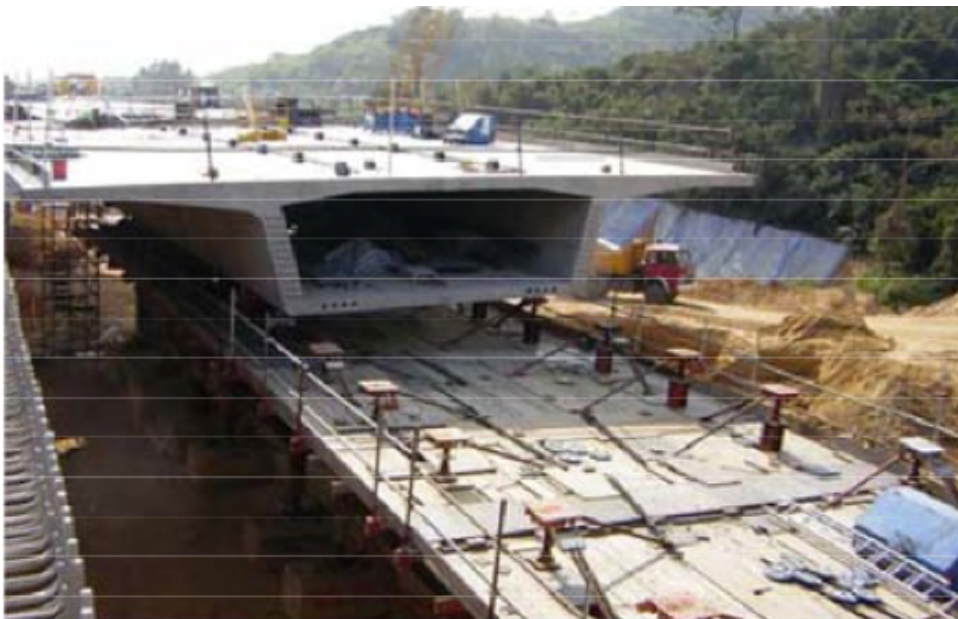
Figura 50 – Colocação das aduelas pré-fabricadas sobre o cimbra
