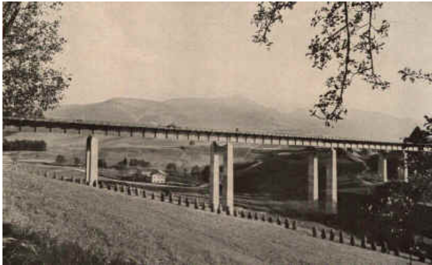
Figura 33 – Ponte Mangfall em Munique, Alemanha
