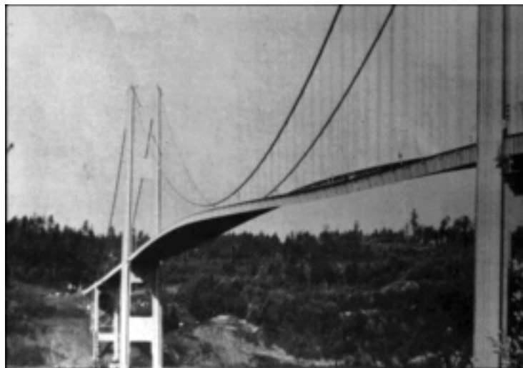
Figura 150 – Oscilação da estrutura por ressonância
