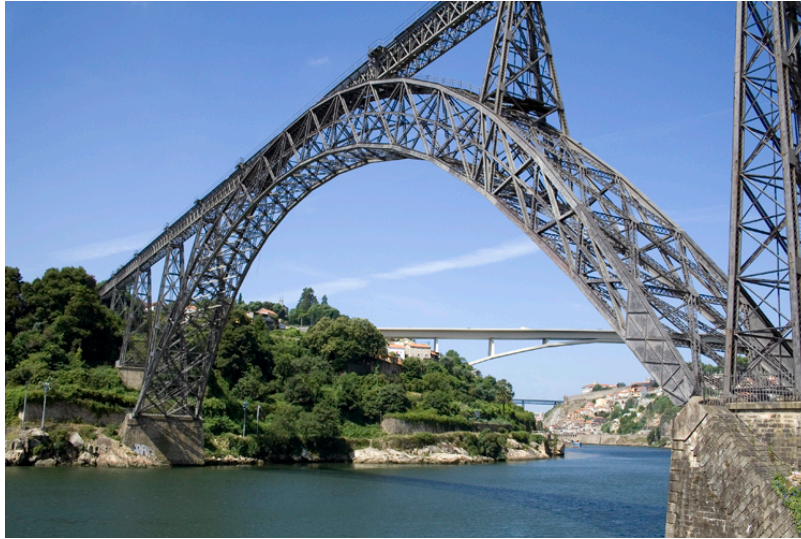
Figura 14 – Ponte Maria Pia no Porto, Portugal
