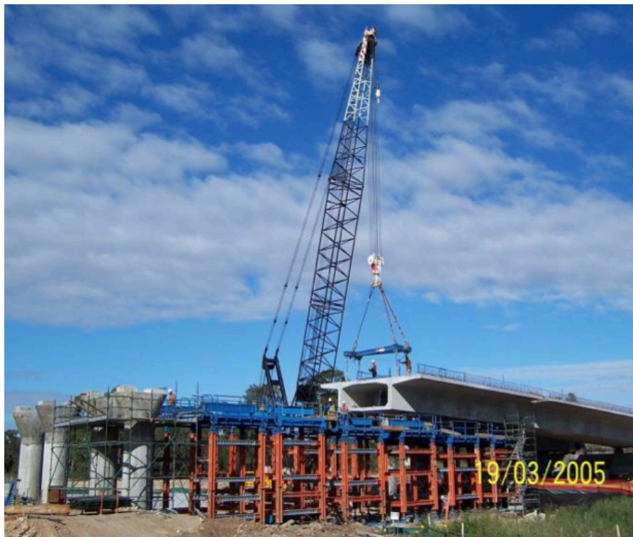
Figura 51 – Colocação de aduelas na posição final com auxílio de gruas
