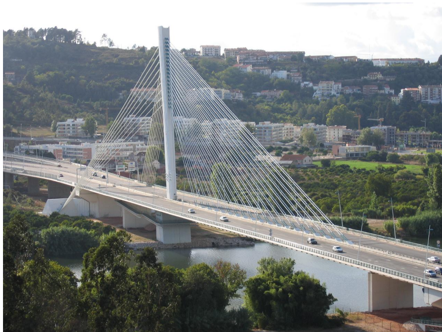
Figura 57 – Ponte Europa, Coimbra
