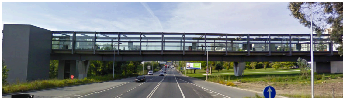
Figura 84 – Estação do Metro – Parque da Maia
