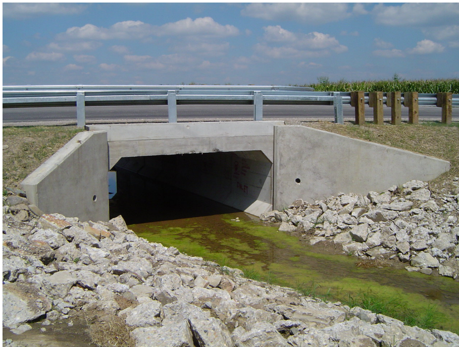
Figura 70 – Aplicação do Box-Culvert
