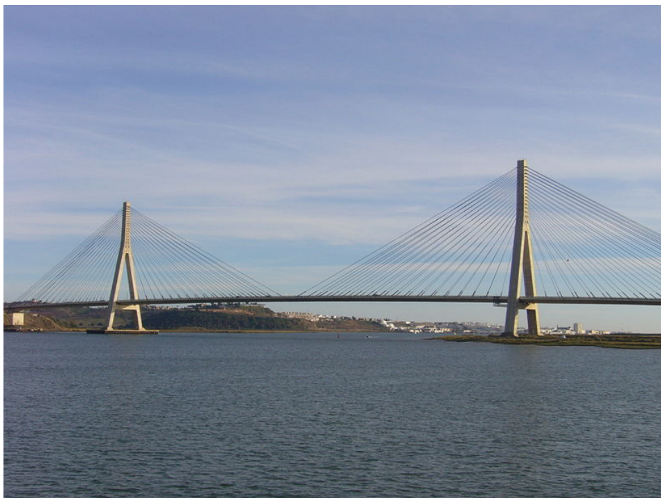
Figura 88 – Ponte sobre o rio Guadiana, Castro Marim
