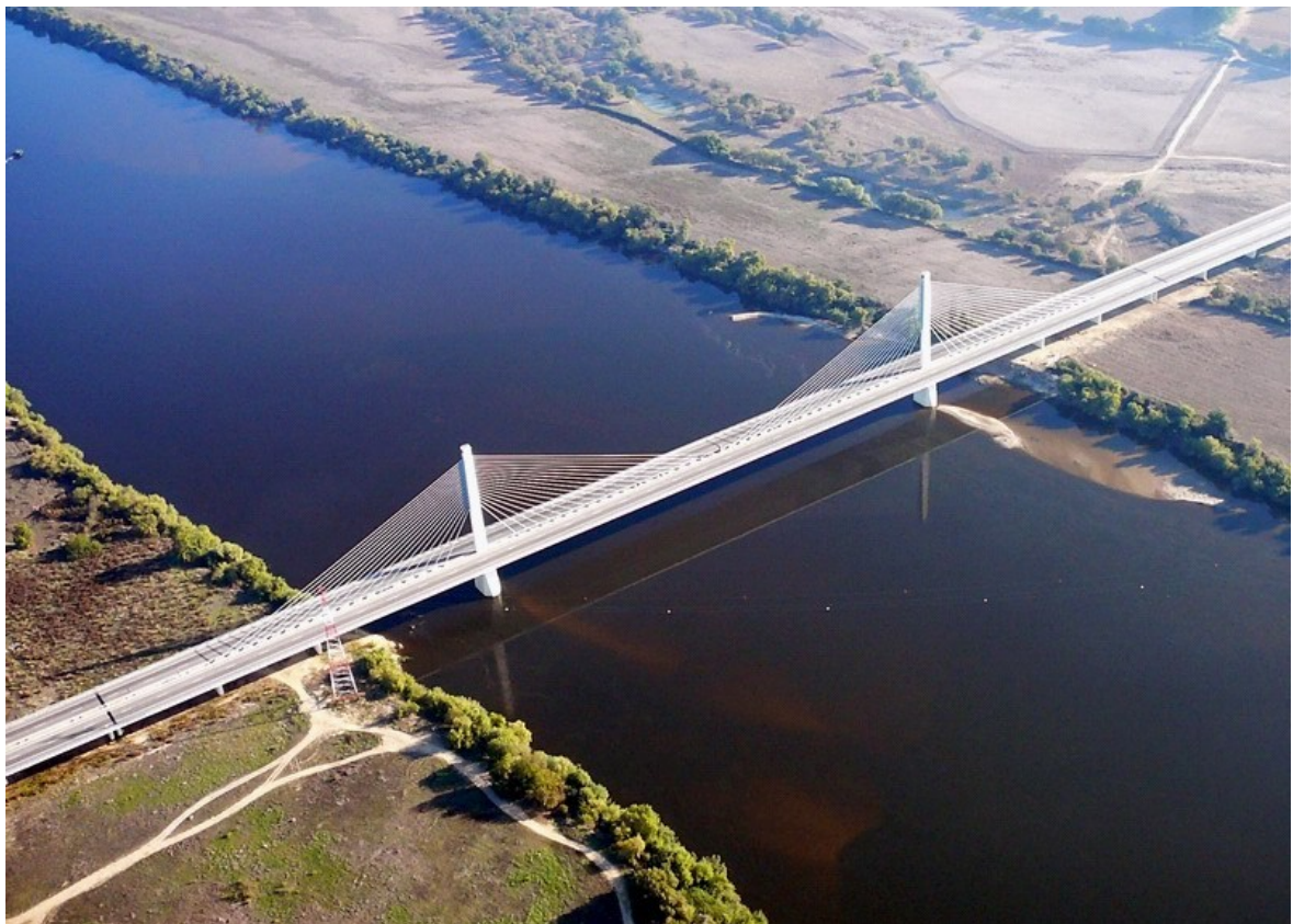
Figura 113 – Ponte Salgueiro Maia, Santarém
