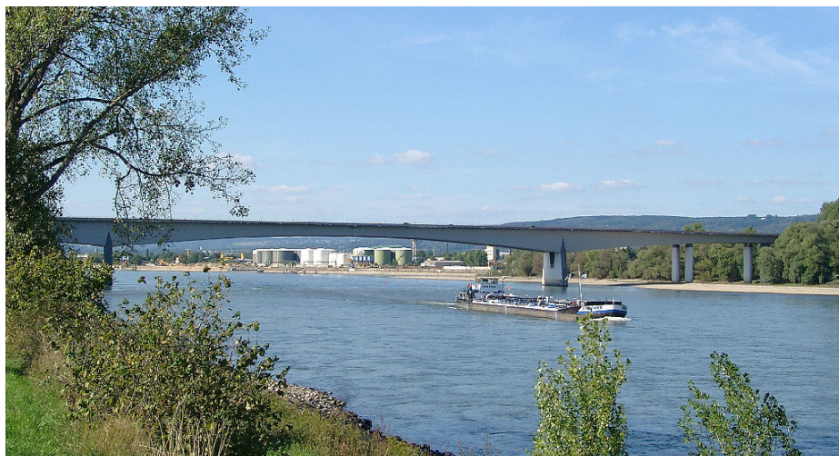
Figura 32 – Ponte Bendorf, Alemanha
