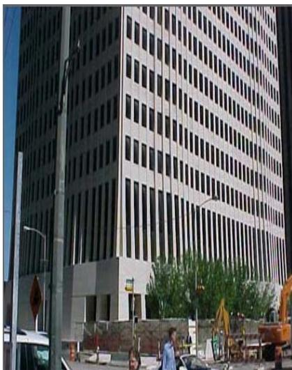
Fig. 3.16 – *One Shell Plaza*, em *Houston* – sistema tubo em betão armado
