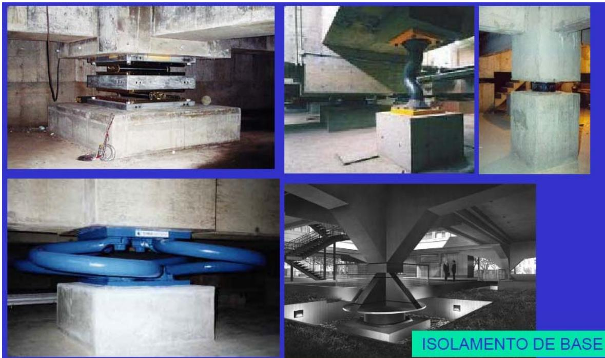
Fig. 3.9 – Vários exemplos de dispositivos que se podem usar para isolar a sapata da restante estrutura [19]
