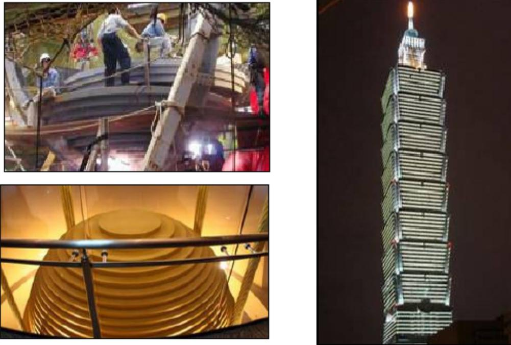
Fig. 3.10 – Amortecedor de massa sintonizado no topo do Edifício *Taipei 101*[10]
