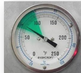
Figura 46 Marcação da pressão de funcionamento correta
