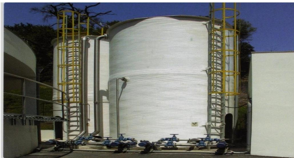
Figura 4.9 – Homogenizador e Espessador
