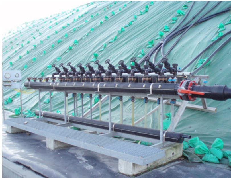
**Fig. 33** – Pormenor da estação de regulação do caudal e da tubagem de ligação entre os poços
