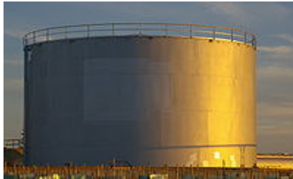
Figura 3.2 – Tanque de armazenamento de petróleo [13].
