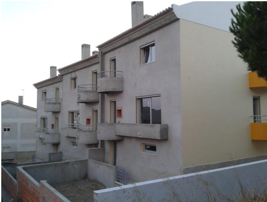
Figura 18 - Rebocos exteriores das moradias
