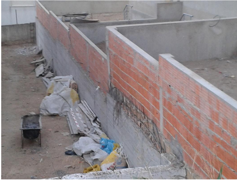
Figura 16 - Muro de suporte construído a tardoz
