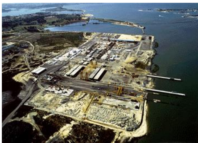
Figura 6 - Estaleiro de pré-fabricação da Ponte Vasco da Gama no Seixal (Fonte: Lusoponte)
