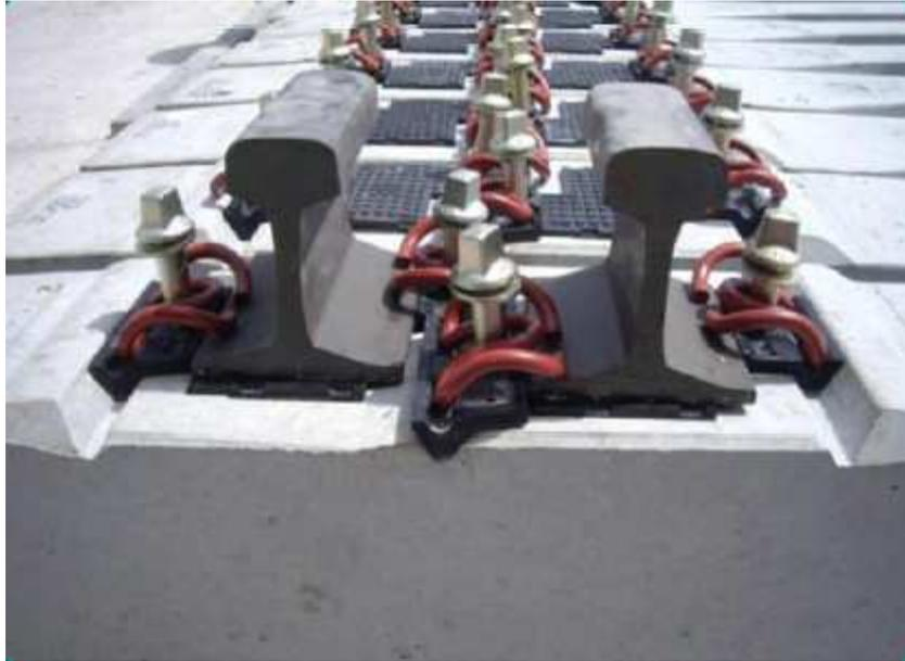
Figura 29 - Fixações em travessas de três carris [39]
