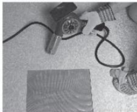
Figura 60 - Recurso a fonte de calor para remoção de um mosaico de linóleo [40]
