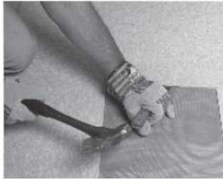
Figura 59 - Recurso ao martelo para remoção de um mosaico de linóleo [40]
