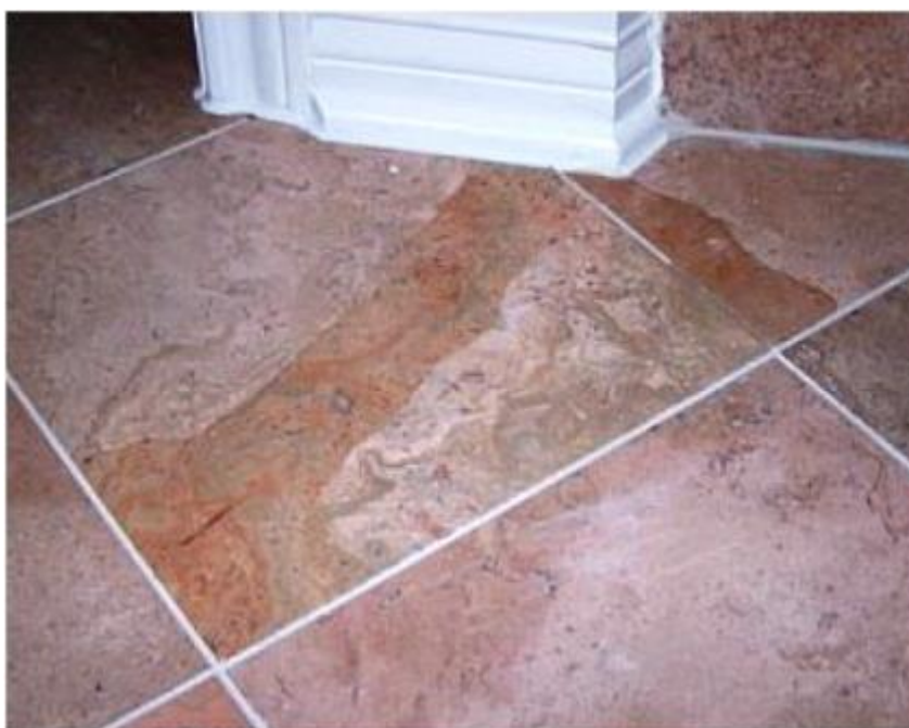
Figura 61 - Revestimento de linóleo com manchas [38]
