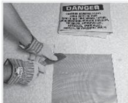
Figura 58 - Remoção de um mosaico de linóleo [40]
