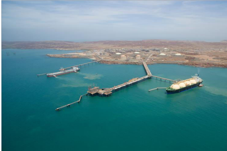
Figura 3-16 - Terminal LNG de Dampier, Austrália (Fonte: Blamclough)
