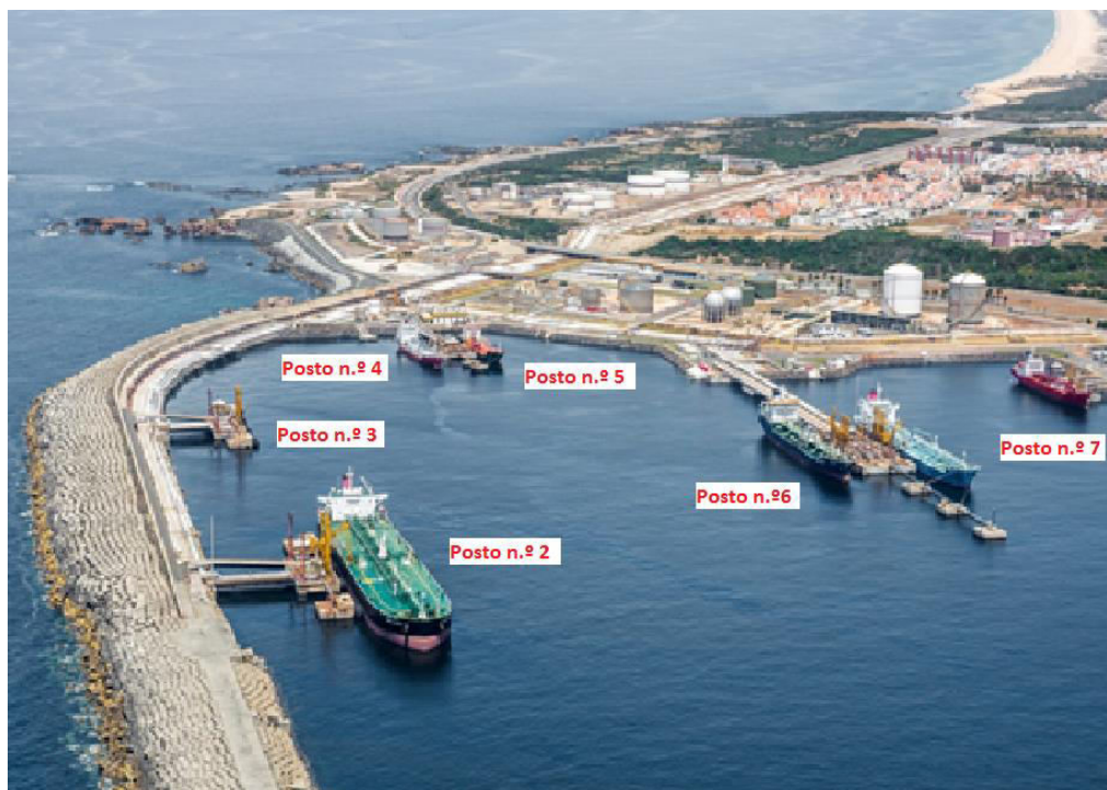
Figura 3-29 - Terminal de granéis líquidos do Porto de Sines (Fonte: Portos de Portugal)
