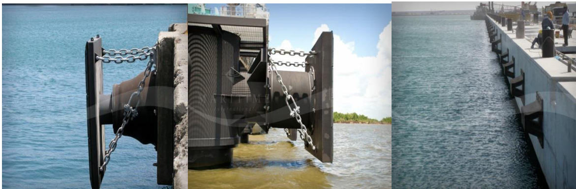
Figura 4-3 - Defensas cónica, cilíndrica e em arco (Fonte: Maritime International)
