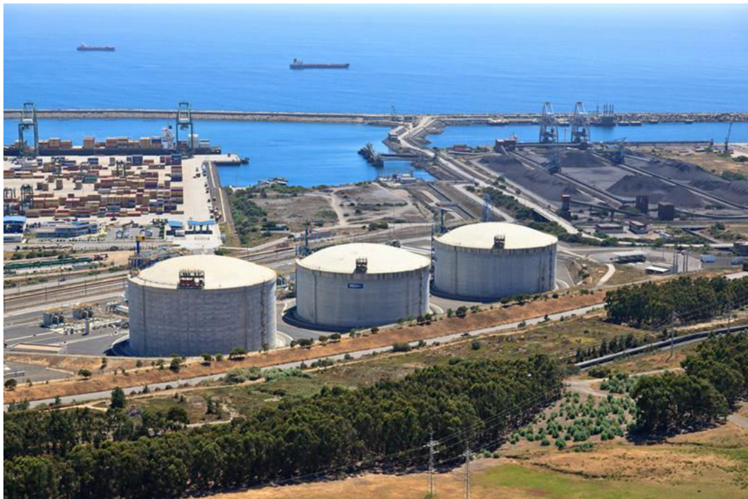
Figura 3-28 - Tanques de armazenamento de GNL do Porto de Sines (Fonte: REN)
