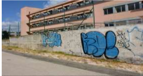
Figura 3 – Trow-up num muro exterior de uma residência universitária
