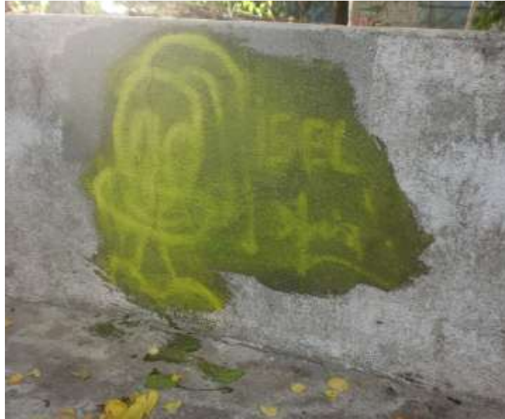
Figura 30 – Grafito completamente coberto do produto de remoção
