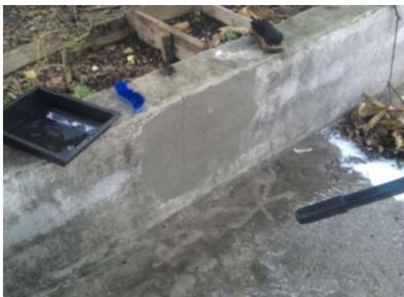
Figura 27 – Remoção total da zona afectada
