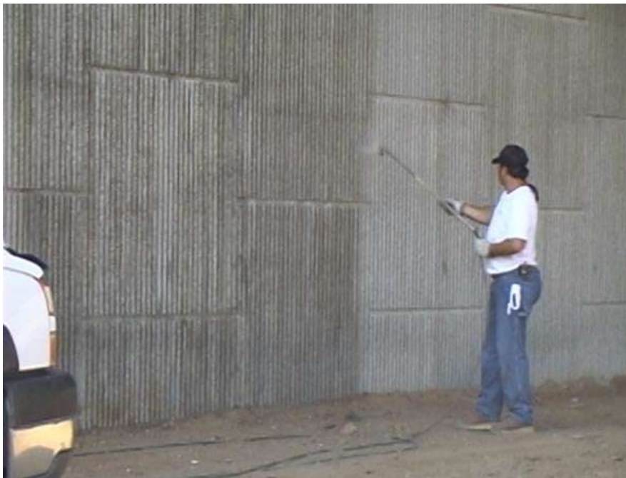
Figura 49 – Aplicação por spray do revestimento anti-graffiti [12]
