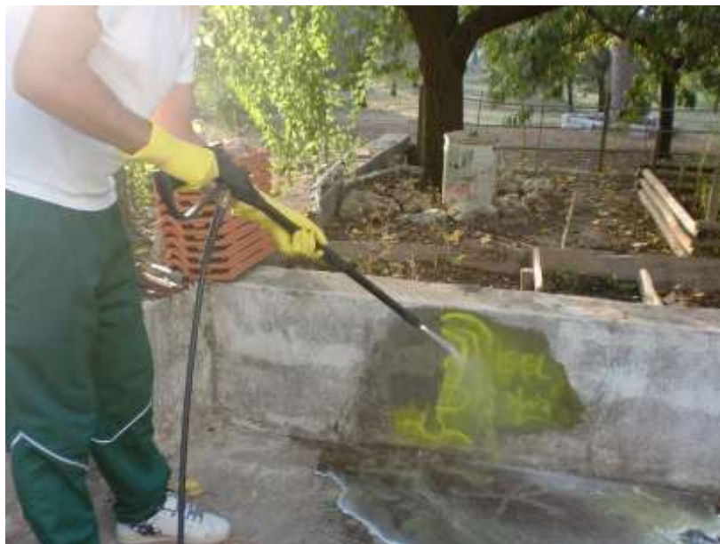
Figura 31 – Projecção de água no murete para remover o gel e o grafito
