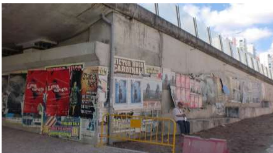
Figura 15 – Colocação de vários cartazes publicitários no início de um viaduto em Lisboa
