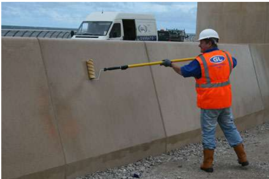
Figura 48 – Aplicação de revestimento anti-graffiti com um rolo [9]
