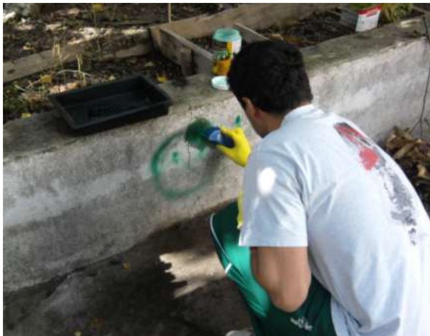
Figura 25 – Colocação do produto de remoção na superfície afectada
