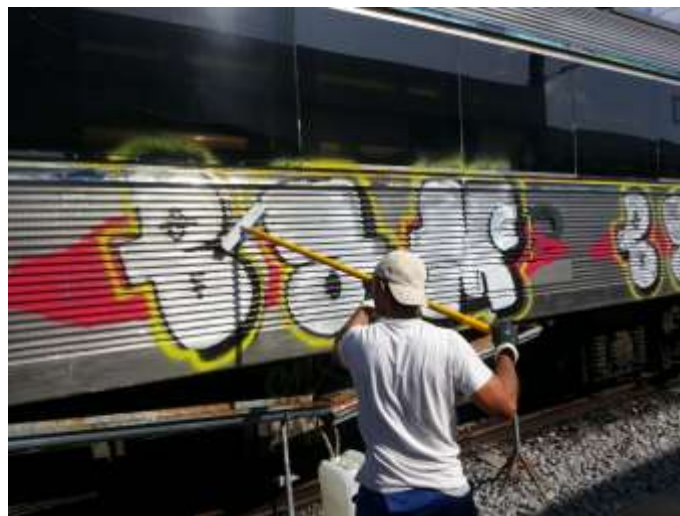
Figura 38 – Aplicação da mistura na superfície
