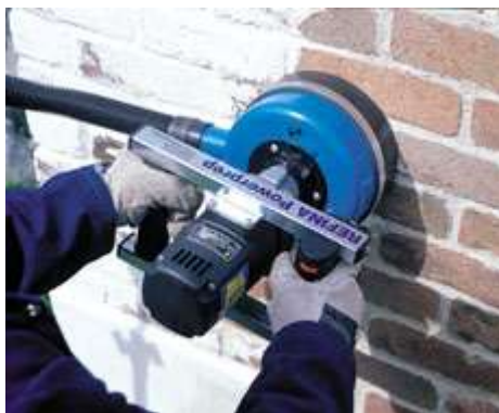
Figura 18 – Limpeza através de uma lixadeira orbital [7]
