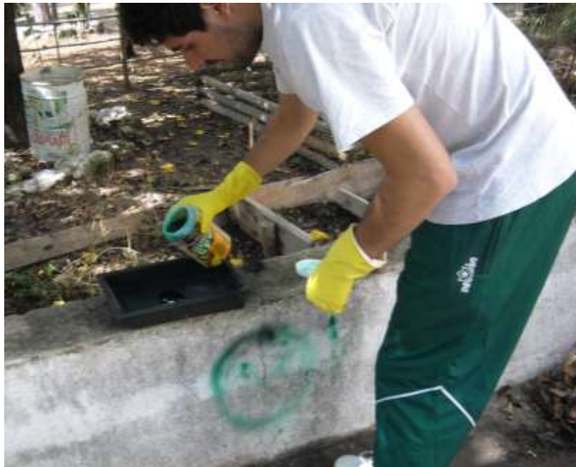
Figura 24 – Passagem do produto de remoção para o recipiente
