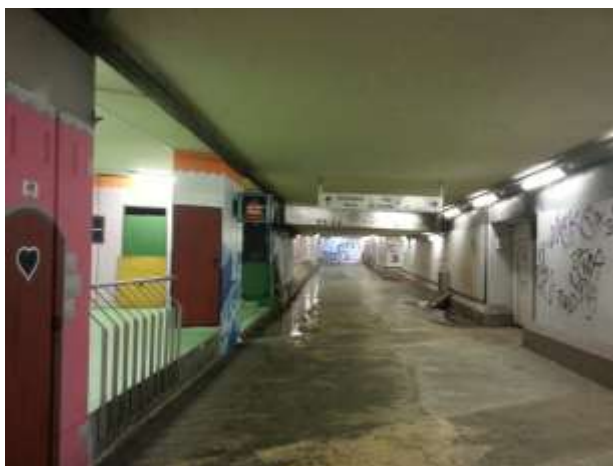
Figura 10 – Túnel de acesso às linhas de uma estação totalmente “grafitada”
