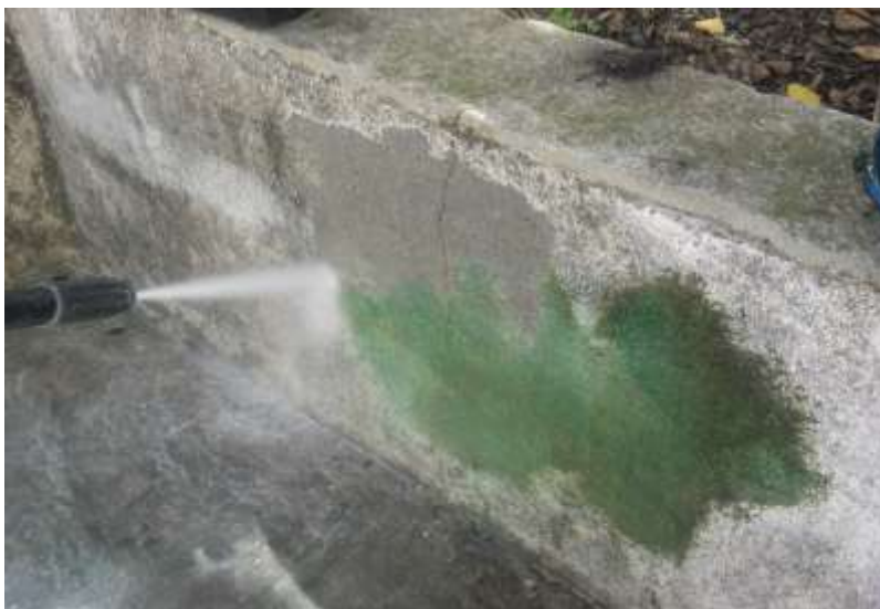
Figura 26 – Projecção de água removendo completamente todo gel e tinta no murete
