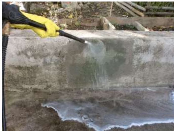
Figura 33 – Nova projecção de água para retirar todo resquício de tinta e gel
