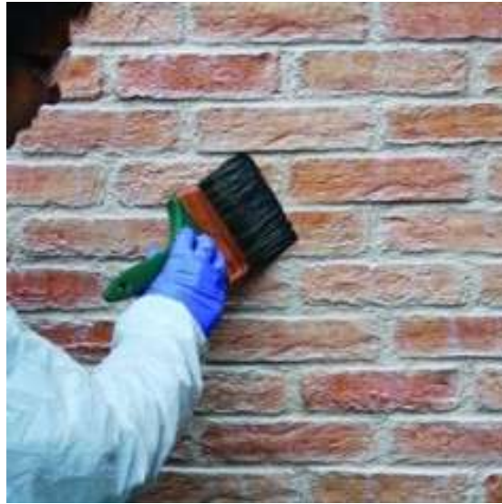
Figura 47 – Aplicação do revestimento através do pincel [6]
