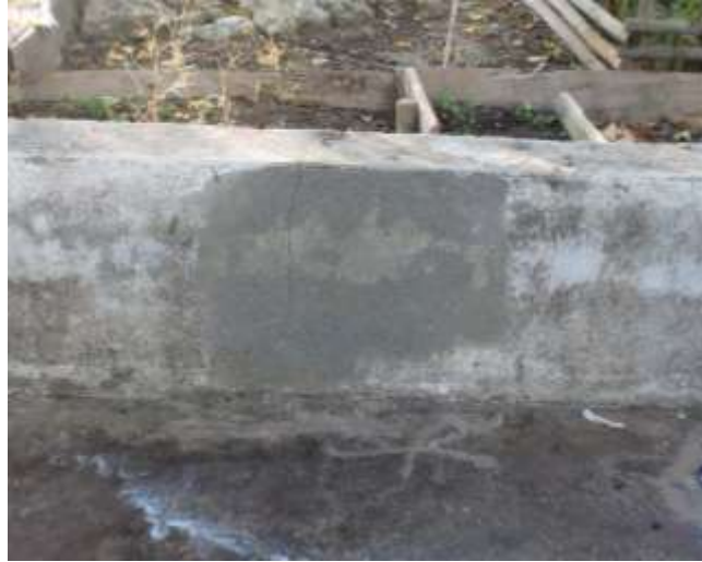
Figura 34 – Remoção completa da área afectada
