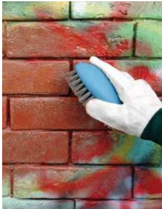
Figura 17 – Utilizando uma escova para remover o grafito numa alvenaria de tijolo de barro [6]
