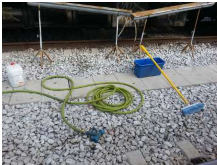
Figura 35 – Material para a execução da remoção
