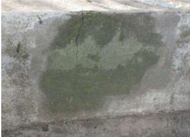
Figura 32 – Ficaram algumas “sombrias” do grafito após a remoção
