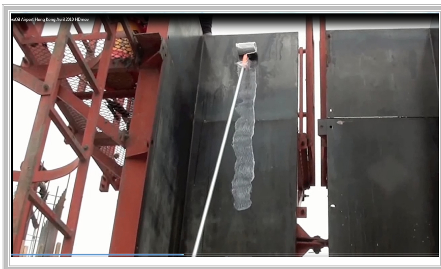
Figura E - Aplicação de óleo descofrante em cofragem vertical com recurso a rolo
