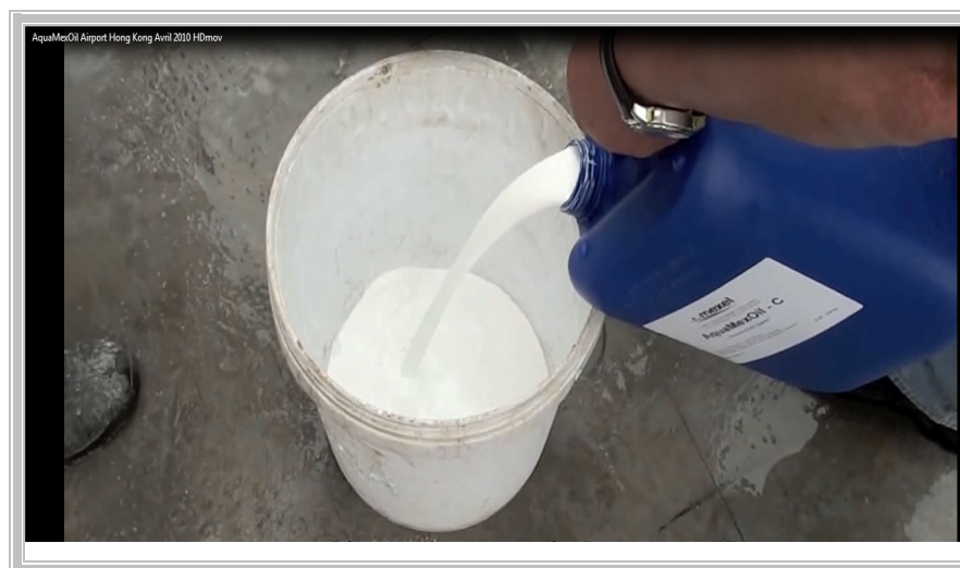
Figura D - Preparação da mistura para ser aplicada com rolo ou trincha
