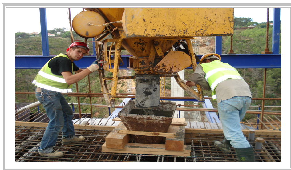
Figura J - Betonagem de uma cofragem horizontal (aduela- carrinho de avanço)
