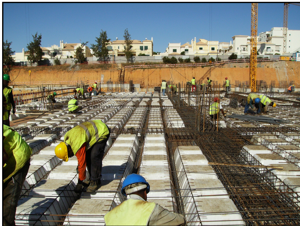
Figura 7-2 Trabalhadores colocando armaduras de aço em laje fungiforme aligeirada
