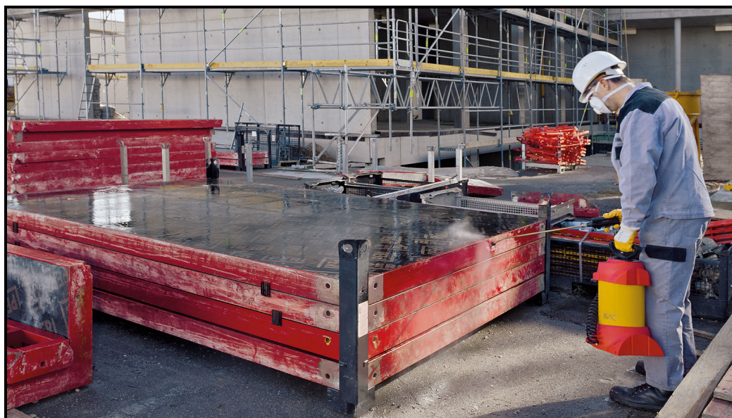
Figura 7-1 Exemplo de montador de cofragem aplicando óleo descofrante com todos os EPI ocasionais recomendados
