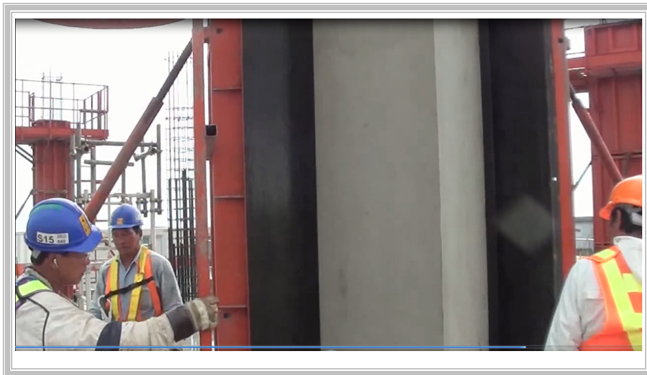
Figura K - Processo de descofragem de um elemento vertical (pilar).
