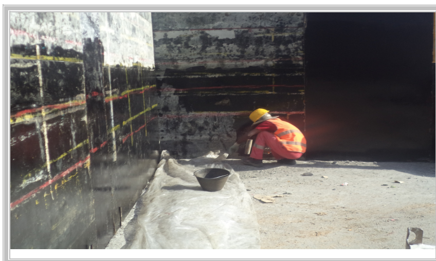
Figura F - Aplicação de óleo descofrante em cofragem vertical com recurso a rolo (Empreitada: Grand Ethiopian Renaissance Dam Project – Etiópia; 2014)
