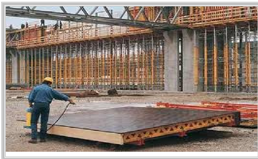
Figura C - Aplicação de óleo descofrante em cofragem horizontal com recurso a pulverizador
