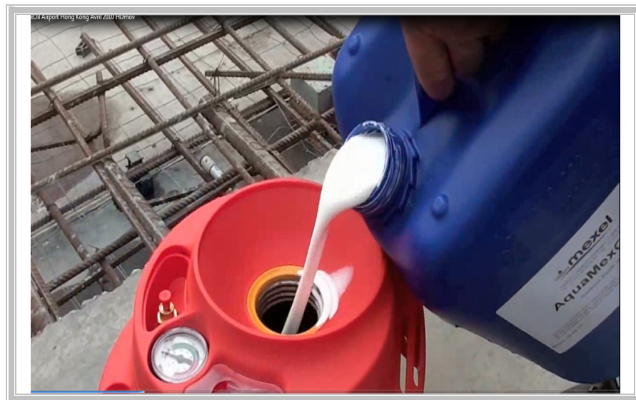
Figura B - Preparação da mistura para ser aplicada com recurso a pulverizador
