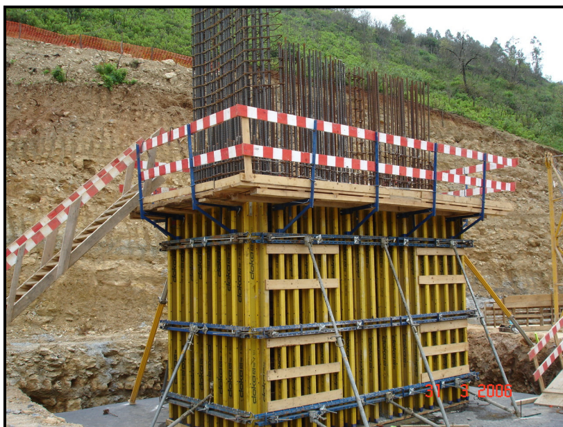
Figura 5-1 Exemplo de um sistema metálico de cofragem vertical
