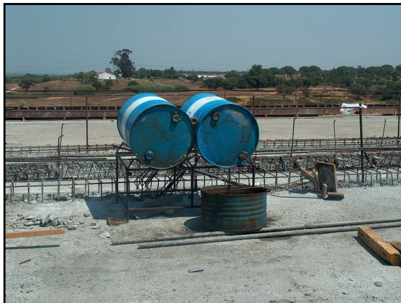
Figura 5-3 Exemplo de armazenamento do óleo descofrante nas frentes de trabalho
