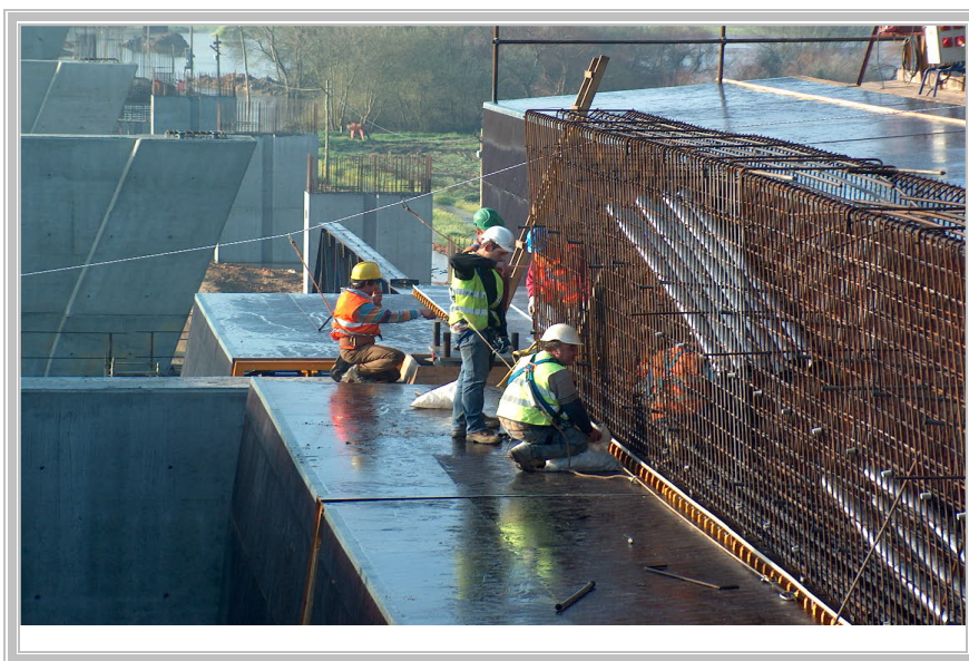
Figura I Colocação de armaduras pré-fabricadas em laje com óleo descofrante aplicado
