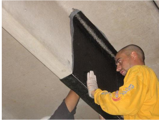
Figura 2.3 - Reforço por encamisamento com fibras de carbono [7].
