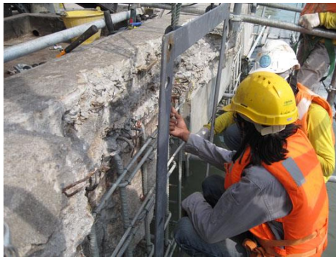
Figura 2.2 - Reforço por encamisamento metálico [7].
