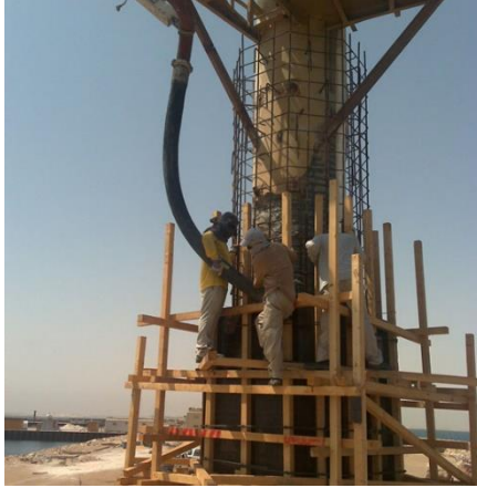
Figura 2.1 - Reforço por encamisamento com betão armado [7].
