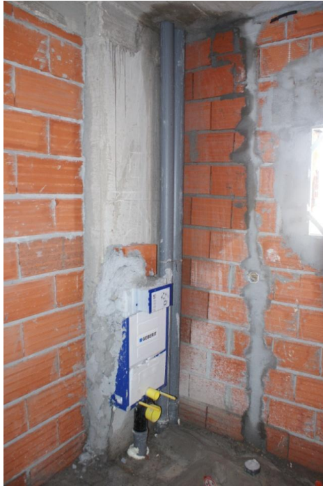
Figura 38 - Tubo de Queda de Águas Pluviais
