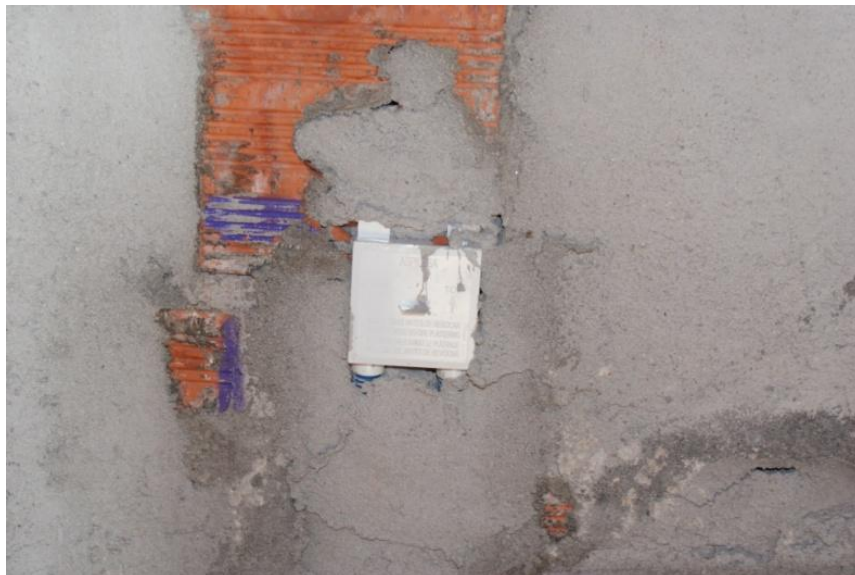
Figura 42 - Tomada da Aspiração Central
