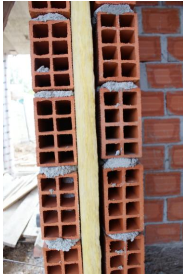
Figura 29 - Constituição da Parede Dupla
