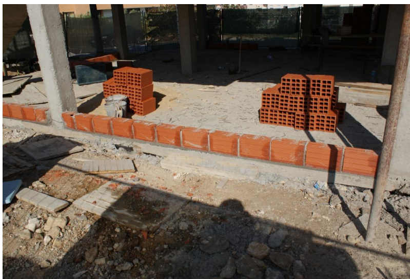
Figura 26 - Execução da Primeira Fiada
