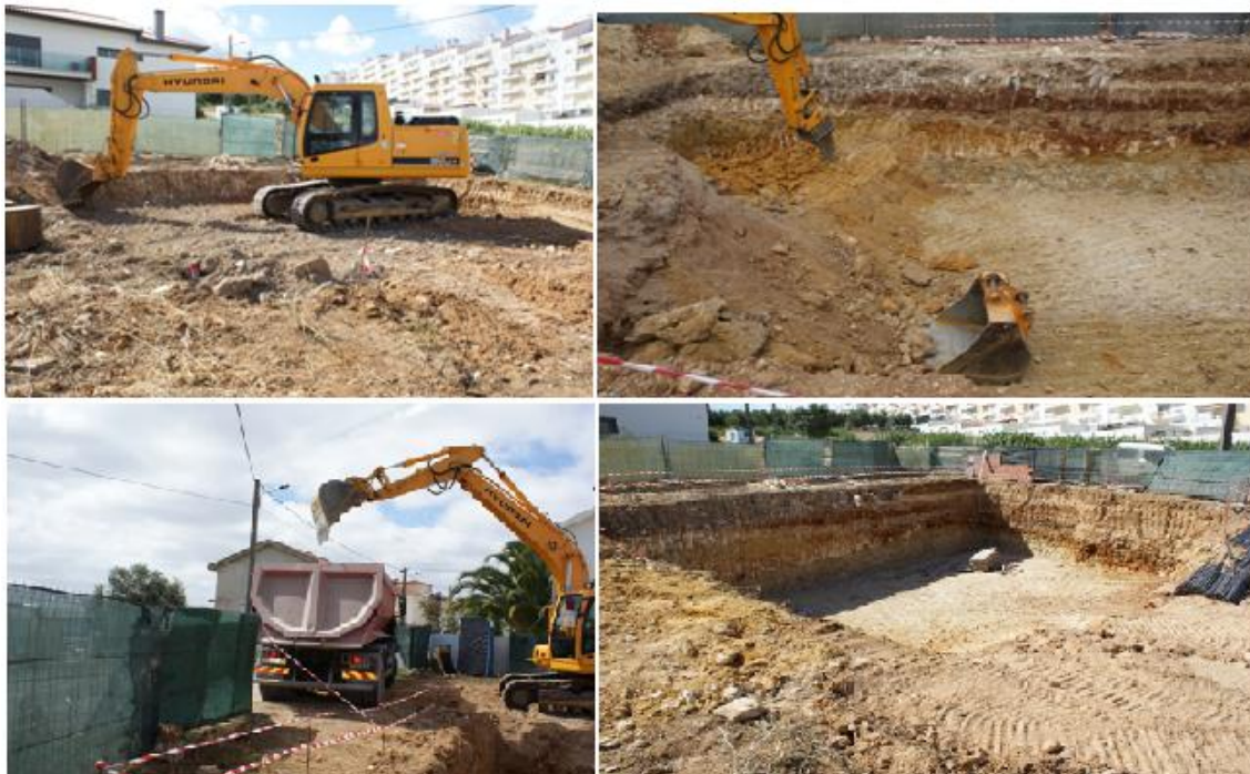
Figura 18 - Fases da Escavação
