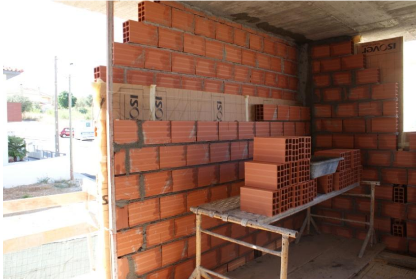
Figura 27 - Elevação da Parede
