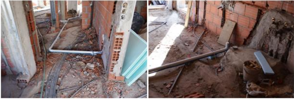
Figura 43 - Pré-instalação da Aspiração Central
