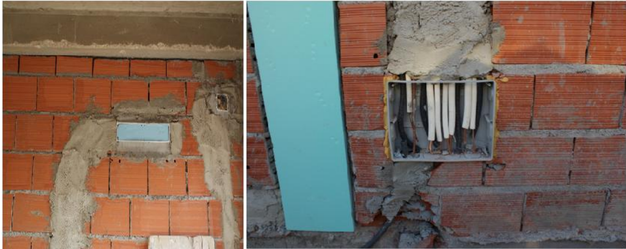
Figura 41 - Pré-instalação de AVAC
