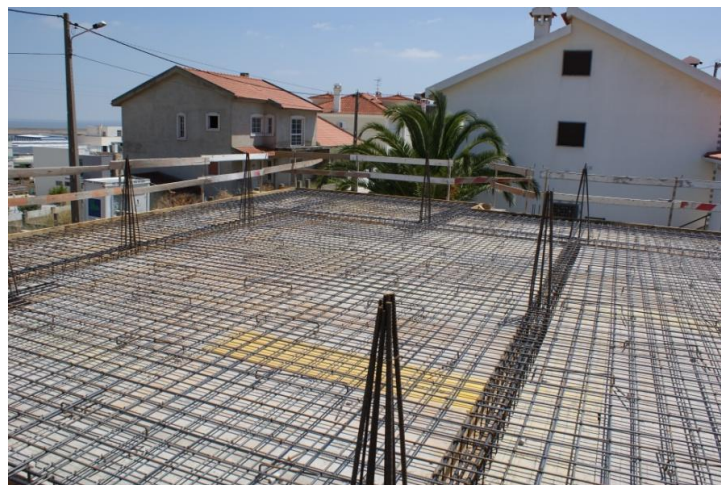
Figura 22 - Armaduras de Laje e Vigas
