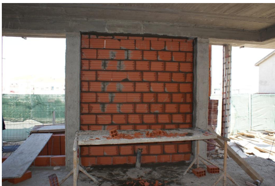
Figura 28 - Fecho da Parede
