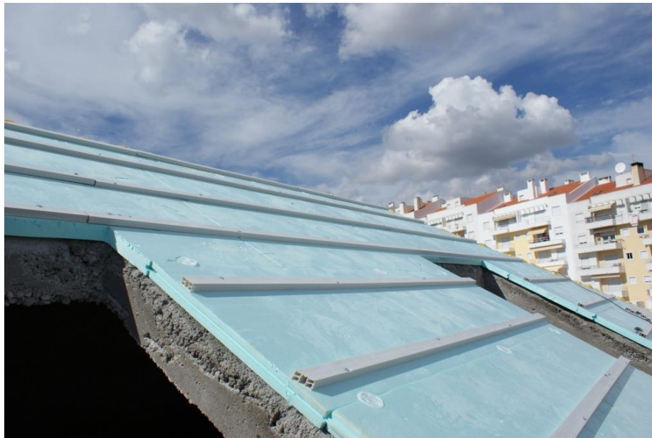
Figura 44 - Cobertura com Isolamento Térmico
