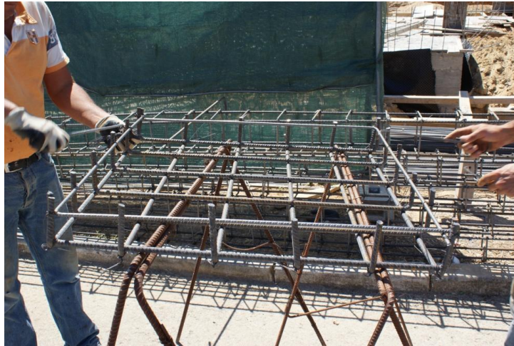
Figura 21 - Armadura de Sapata
