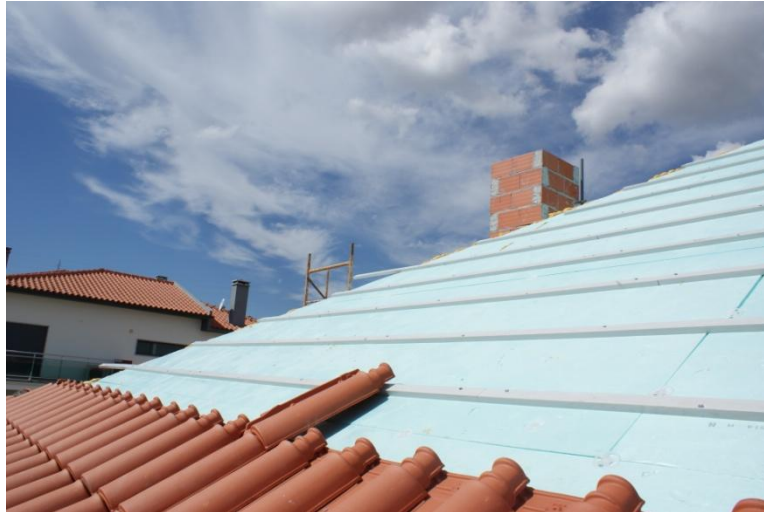
Figura 45 - Telha sobre a Ripa de PVC
