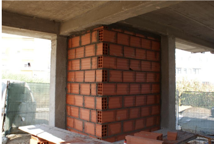
Figura 30 - Travamento das Paredes nos Cunhais
