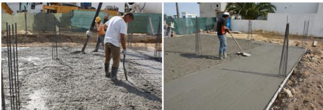
Figura 24 - Vibração e Espalhamento do Betão
