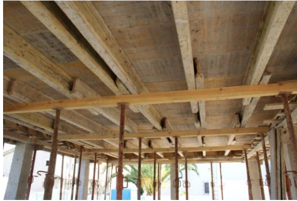
Figura 19 - Cofragem Tradicional Melhorada
