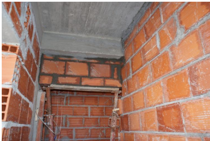
Figura 31 - Execução das Padieiras
