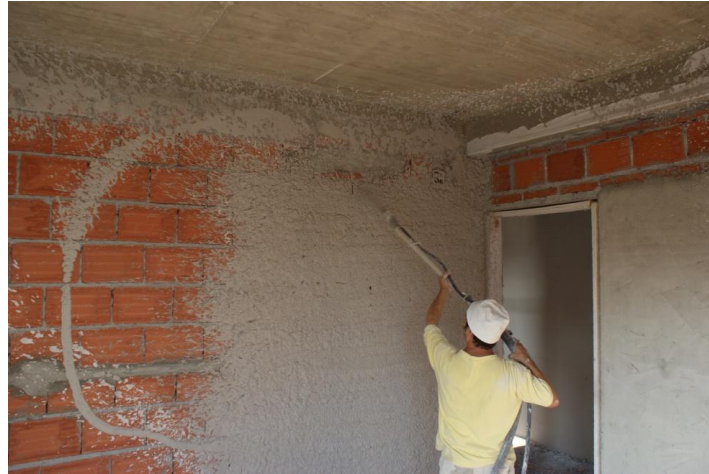
Figura 47 - Projecção do Gesso de Base
