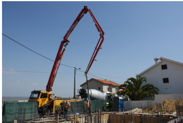
Figura 23 - Betonagem com autobomba
