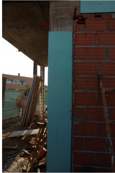
Figura 32 - Isolamento Térmico pelo Exterior
