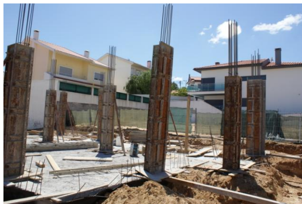
Figura 20 - Cofragem Racionalizada
