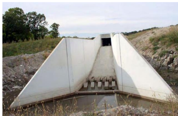
Figura 3.14: Exemplo de uma bacia de dissipação Tipo SAF (extraído de FEMA, 2010)
