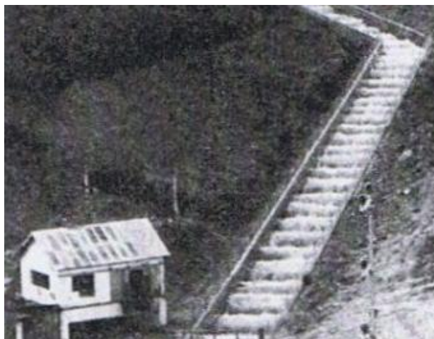
Figura 3.21: Exemplo de uma estrutura com macrorrugosidades – Rampa com travessas (extraído de Ramos, 2010)
