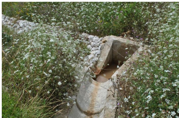
Figura 3.5: Dissipador de energia Tipo Farcimar (junho de 2014, acervo da autora)
