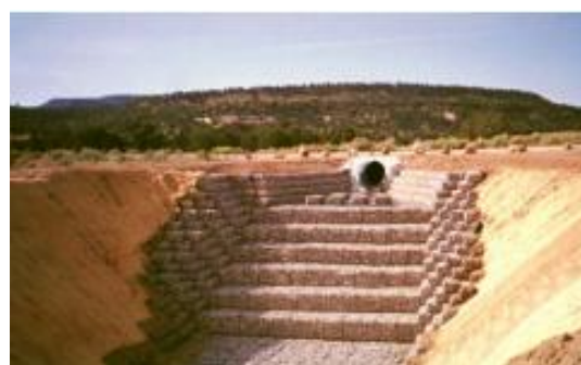
b: Aplicação de gabiões em escada à saída de uma passagem hidráulica
