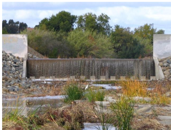
Figura 3.18: Exemplo de uma bacia de dissipação por queda com blocos (extraído do Arquivo Aliso Creek Waterfall)
