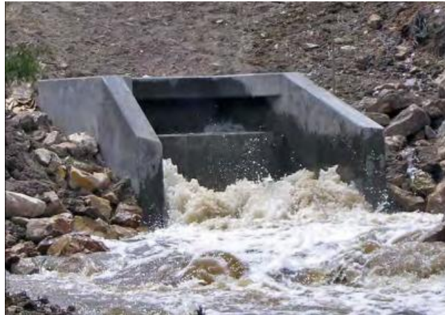
Figura 3.12: Exemplo de uma bacia de dissipação por impacto Tipo VI à saída de uma passagem hidráulica (extraído de FEMA, 2010)
