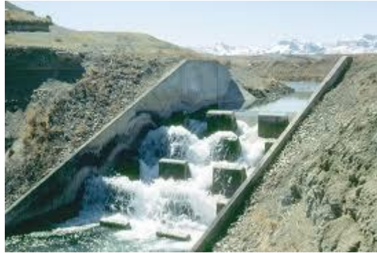
Figura 3.19: Exemplo de uma estrutura com macrorrugosidades – Rampa com blocos (extraído de USDA, 1981)
