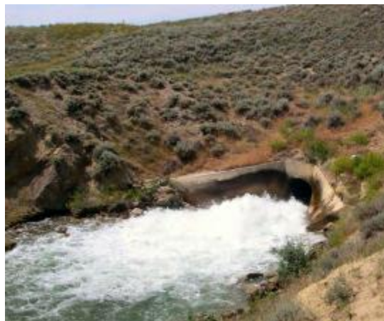
Figura 3.15: Exemplo de uma bacia de dissipação Tipo PWD (extraído de FEMA, 2010)
