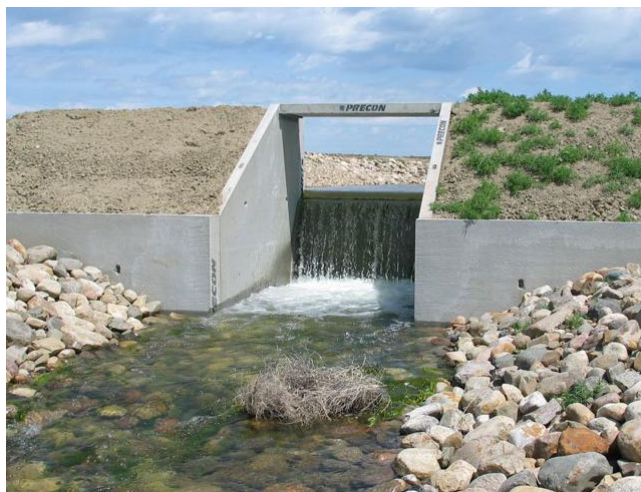
Figura 3.17: Exemplo de uma bacia de dissipação por queda simples (extraído de Precon)
