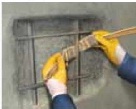
*Figura 4.3 - Aplicação de proteção anticorrosiva (fonte: [8])*
