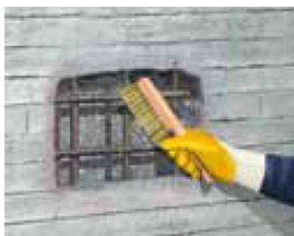
Figura 4.2 - Escovagem para limpeza de armaduras (fonte: [8])
