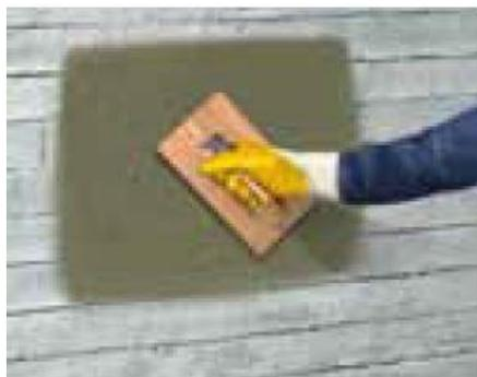
*Figura 4.5 - Alisamento da superfície com talocha (fonte: [8])*
