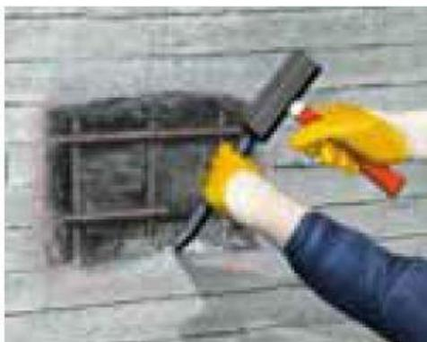
Figura 4.1 - Picagem do betão deteriorado (fonte: [8])
