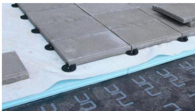
*Figura 4.7 - Exemplo da aplicação dos apoios e lajetas [fonte: forumdacasa.com]*
