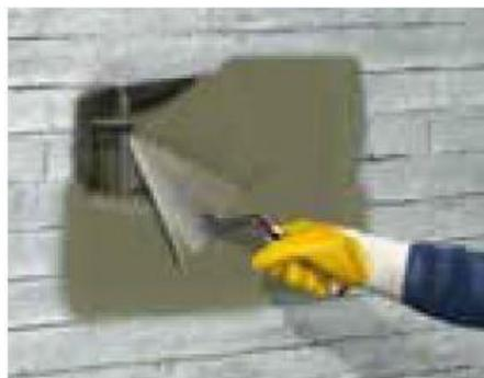
*Figura 4.4 - Aplicação da argamassa com colher (fonte: [8])*
