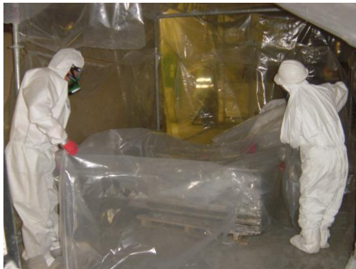
Foto 52 – Remoção de fibrocimento pelo interior, sob as chapas.
