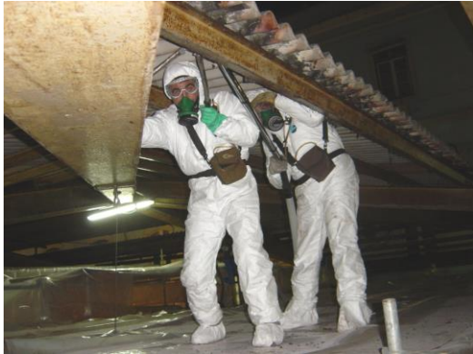
Foto 43 – Remoção de fibrocimento pelo interior, sob as chapas.
