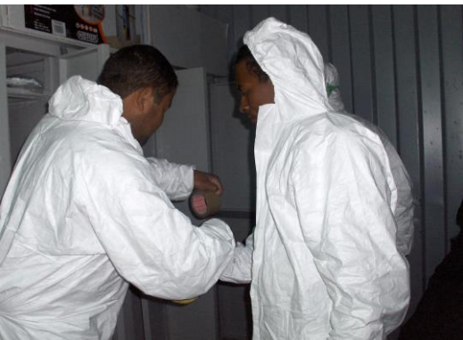
Foto 22 – Trabalhador a selar as luvas e mangas do fato descartável, com recurso a fita adesiva (deve ser resistente à penetração das fibras de amianto).
