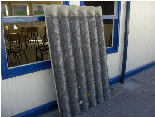
Foto 79 – Chapa de fibrocimento abandonada, sem ter sido embalada com manga plástica.
