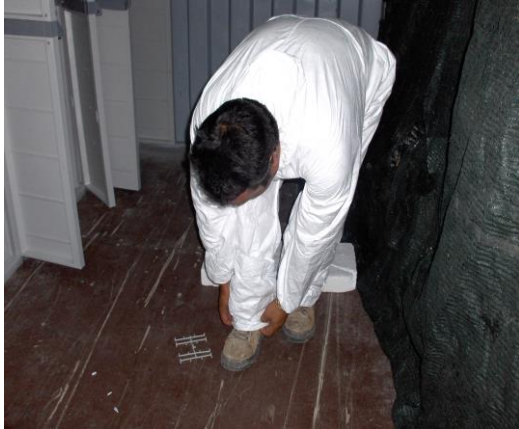
Foto 19 – Trabalhador a vestir fato descartável e botas, na zona limpa.
