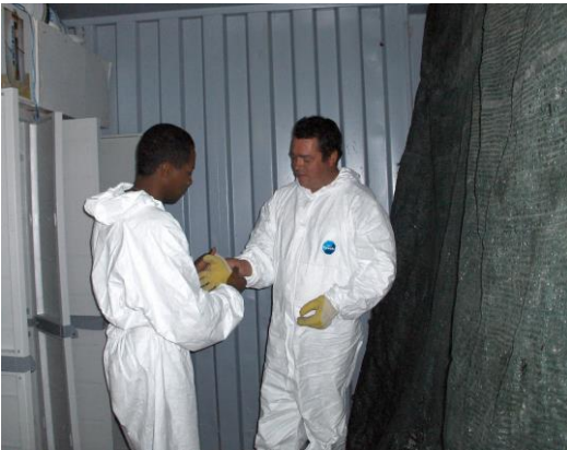
Foto 20 – Trabalhador a vestir fato descartável e luvas, na zona limpa, com apoio de outro trabalhador.
