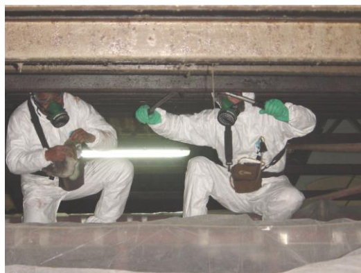
Foto 45 – Remoção de fibrocimento pelo interior, sob as chapas.
