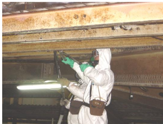
Foto 44 – Remoção de fibrocimento pelo interior, sob as chapas.
