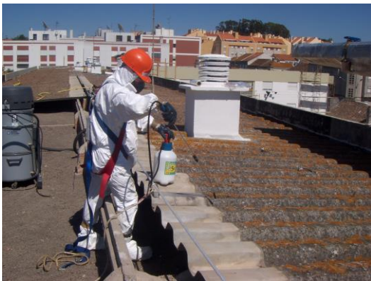
Foto 32 – Remoção de fibrocimento pelo exterior. Aplicação da solução aquosa para o encapsulamento, com recurso a pulverizador.
