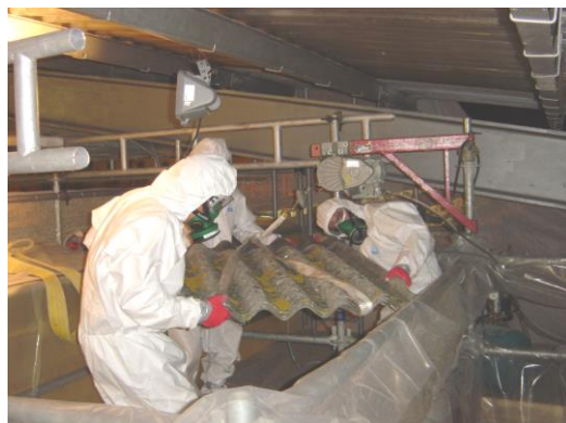
Foto 46 – Remoção de fibrocimento pelo interior, sob as chapas.
