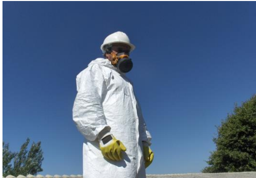
Foto 78 – O Trabalhador tirou o capuz, durante a remoção de fibrocimento.
