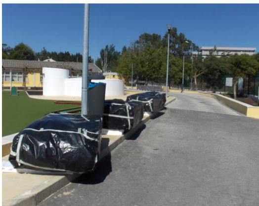
Foto 69 – Chapas de fibrocimento embaladas, mas sem símbolo de amianto.
