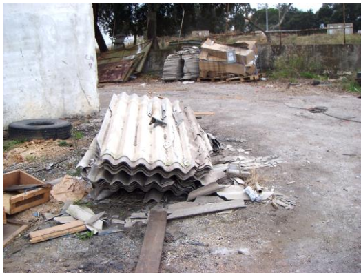
Foto 67 – Chapas de fibrocimento amontoadas, sem estarem embaladas.
