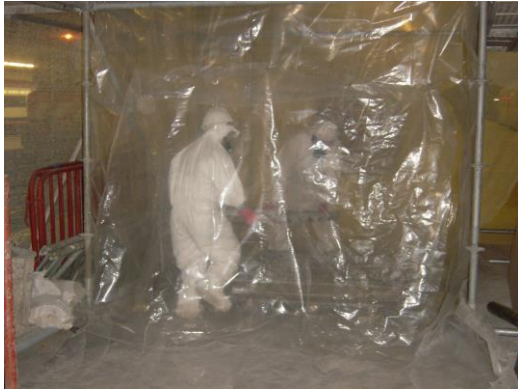
Foto 51 – Remoção de fibrocimento pelo interior, sob as chapas.
