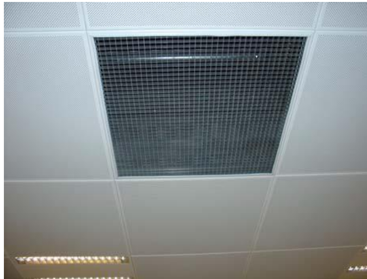
Figura 21 - Grelha de teto, com a função de desenfumagem passiva [17].
