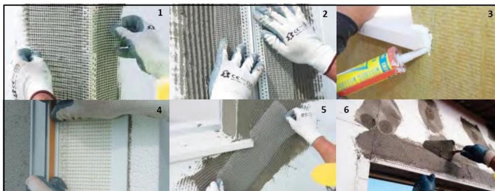
Figura 4.8 - Tratamento de pontos Singulares - Fonte - Adaptado [9]
