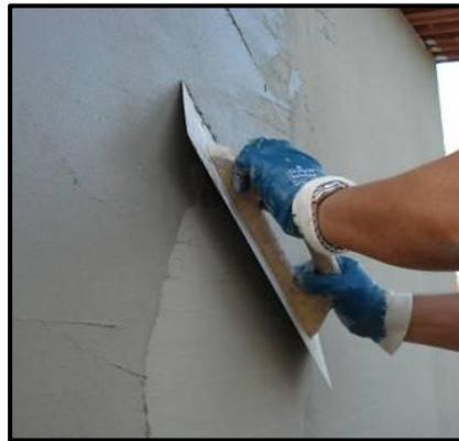
Figura 4.9 – Aplicação de camada de argamassa - Fonte [10]
