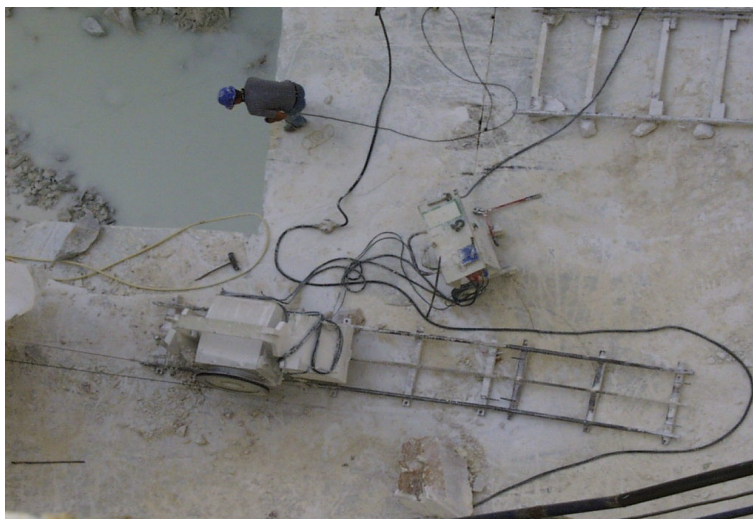
Fig 5.1 – Corte de bloco primário com máquina de fio diamantado (Fonte: autora)
