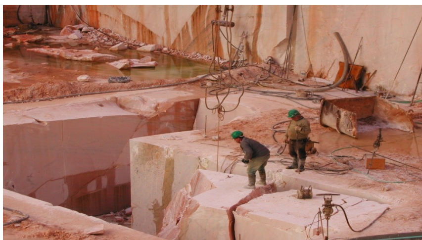
Fig. 5.2 - Preparação de derrube de bloco primário (Fonte: autora)
