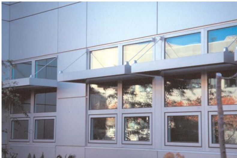
Figura 15 – Instalação de uma prateleira de iluminação num edifício [8]
