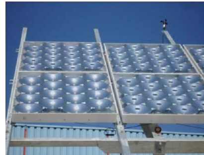
Figura 54 – Exemplo de fotovoltaico com tecnologia de reflexão – alta concentração [15]
