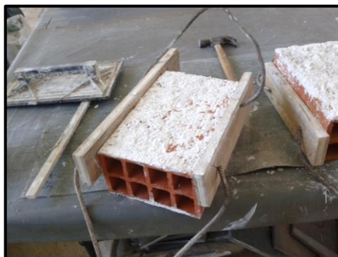
Figura 3.19 - Colocação das réguas de madeira
