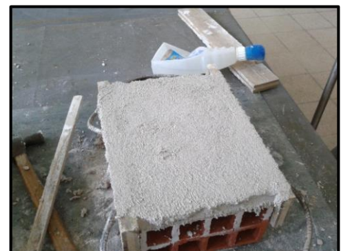
Figura 3.20 - Camada de acabamento
