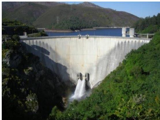
**Figura 2.8** - Descarga de fundo - barragem do Alto Lindoso (Rui, 2010).
