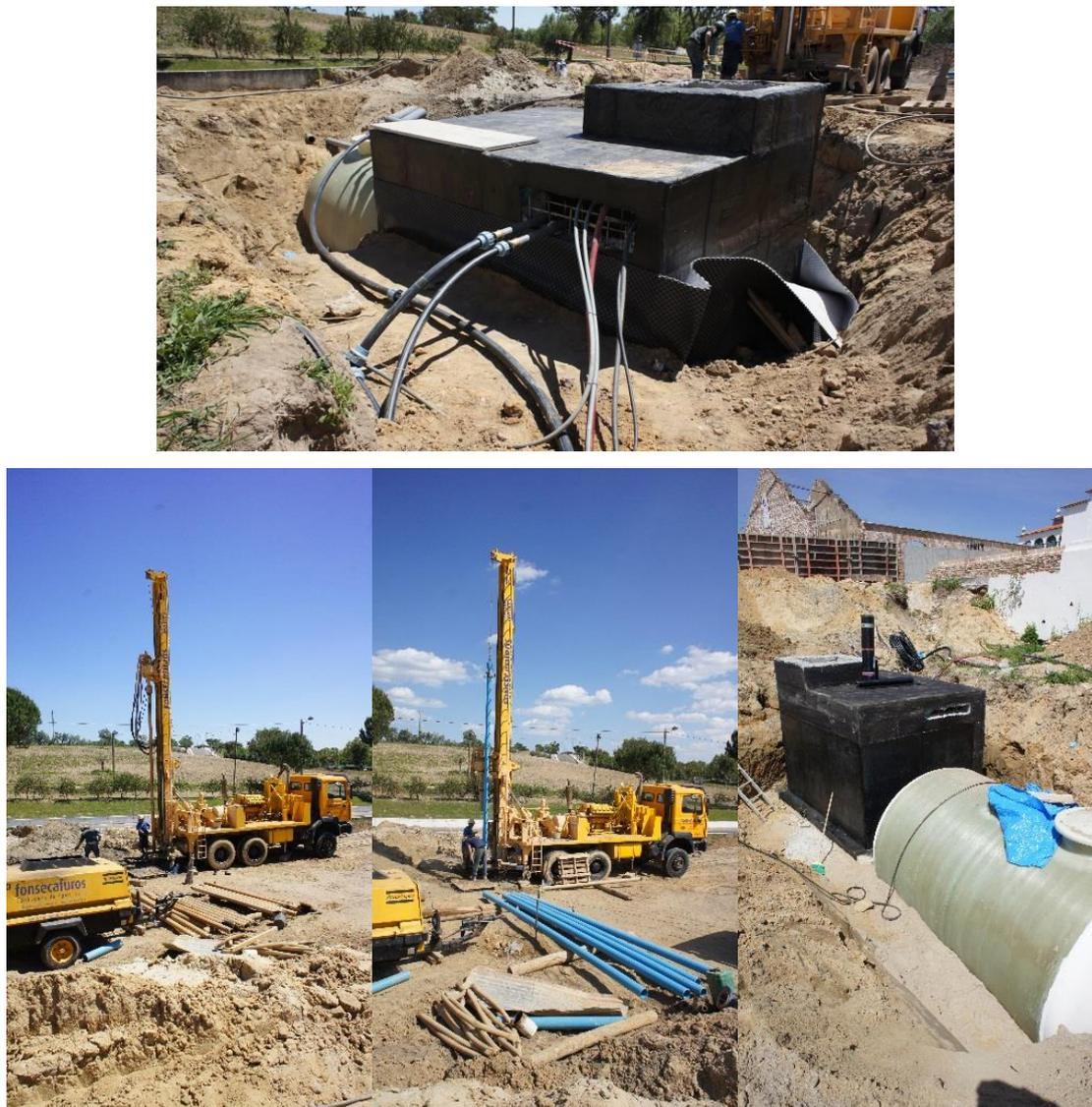
Figura 29 - Exemplo de sequência dos trabalhos de execução do furo de captação e Sistema apoio de rega
