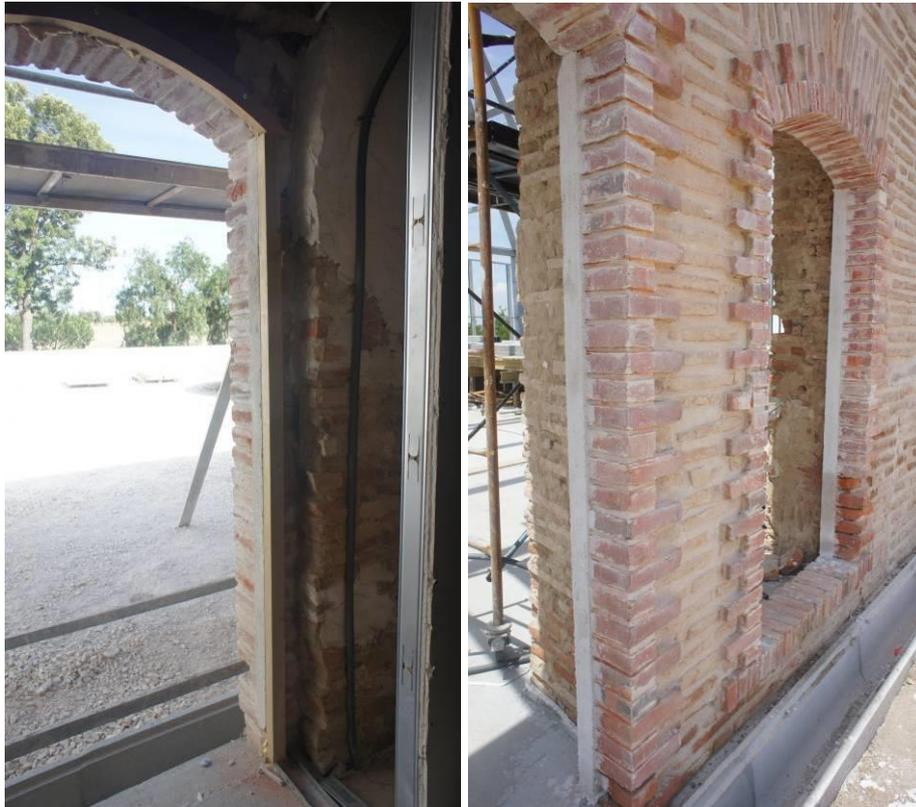
*Figura 40 – Pormenores de execução de meio fio em argamassa de cal, cimento e areia ao traço 1:1:4 para fixação de caixilharia de alumínio- Aplicação de Pré-aro em madeira*
