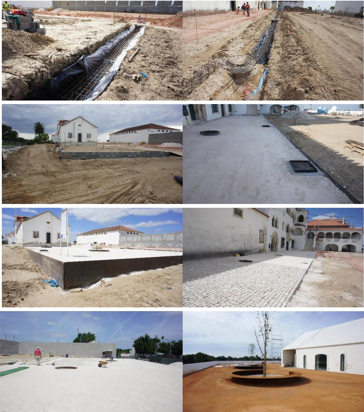
*Figura 28 - Exemplo de sequência dos trabalhos de arranjos exteriores – pavimentos
