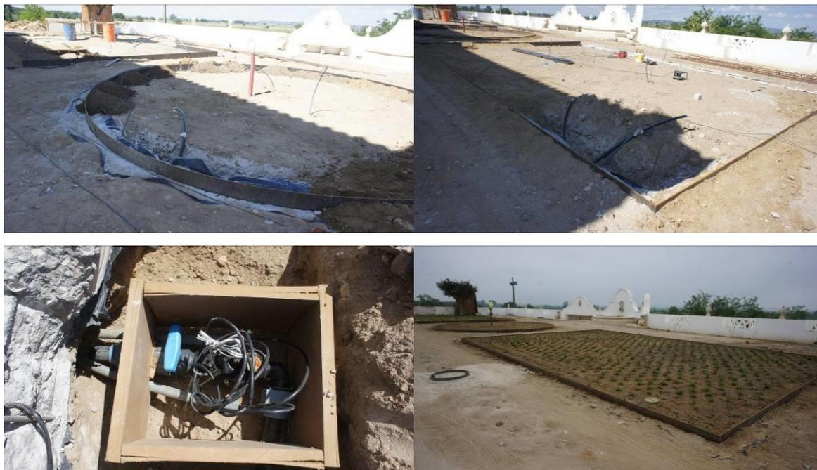
*Figura 30 – Exemplo de sequência de trabalhos de instalação de rede de rega*
