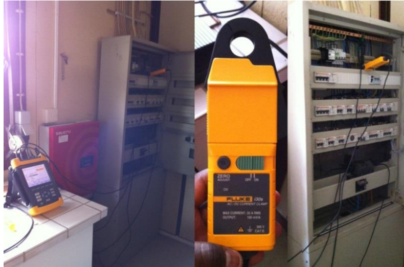
Figura 5.12: Pinça amperimétrica FLUKE i30s e ligações.
