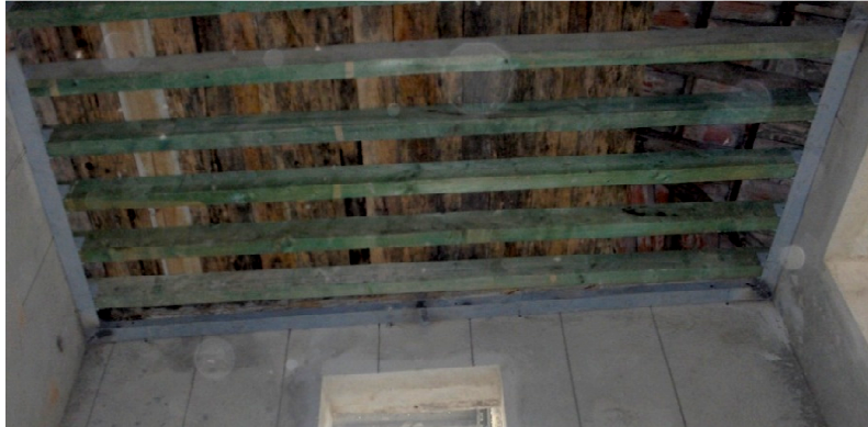
Figura 14 – Solução estrutural de reabilitação, cintagem pelo interior com cantoneira metálica onde apoiam os vigamentos de madeira do piso.
