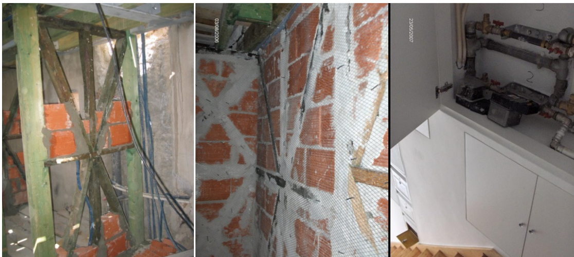
Figura 27 – Esq. execução parede resistente,
