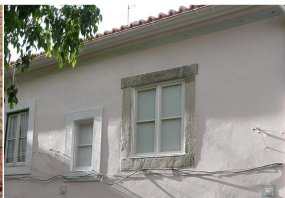
Figura 6 – Fachada com reforço estrutural em chapa metálica chumbada sob o beirado e tirantes ao nível do piso no sentido transversal
