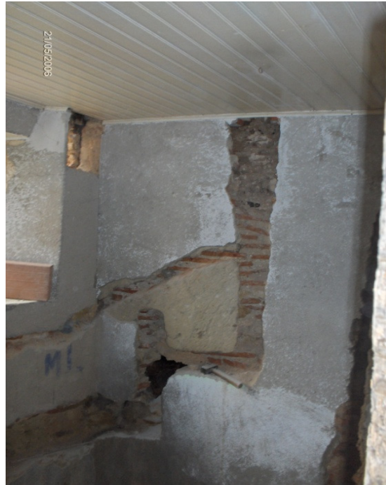
Figura 9 - Roços para tubagem rede de águas e esgotos em reabilitação
