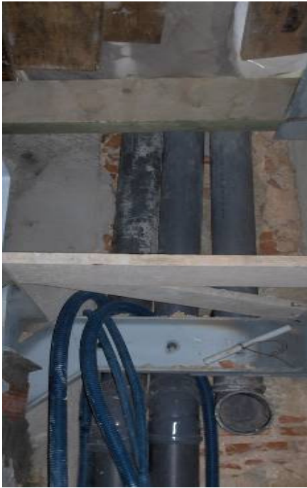
Figura 8 – Execução de redes novas, travessia entre os vazios da estrutura
