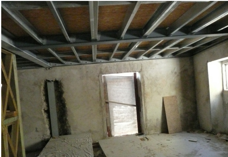
Figura 16- Vista inferior de um piso com da estrutura em "aço leve"
