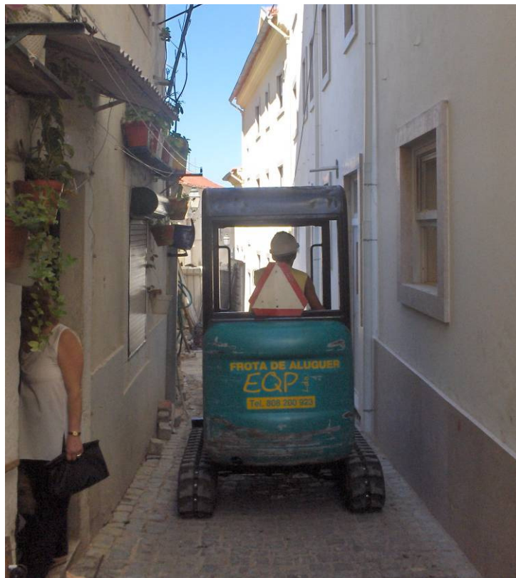
Figura 2 – Acesso à frente de obra dificultado pela largura do arruamento.
