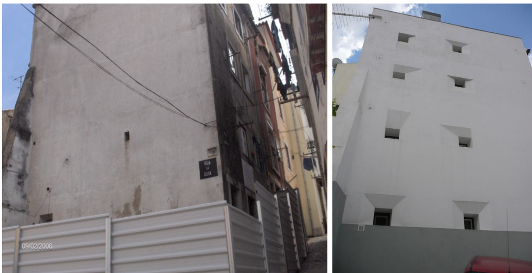
Figura 23 – Empena antes e após a Intervenção
