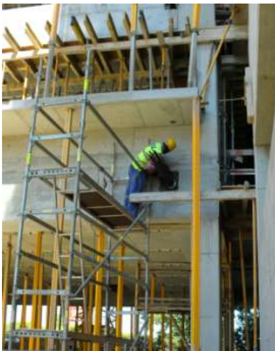
Figura 79 - Trabalhador a efectuar a descofragem
