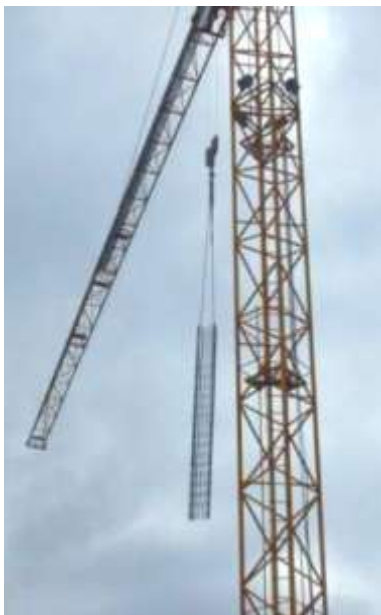
Figura 60 - Elevação de armadura de pilar
