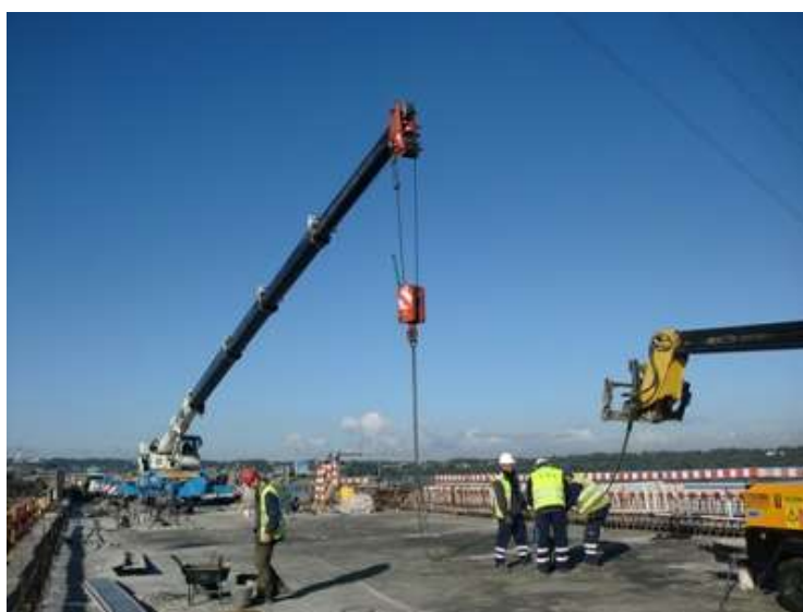
Figura 55 - Grua a efectuar o levantamento do macaco
