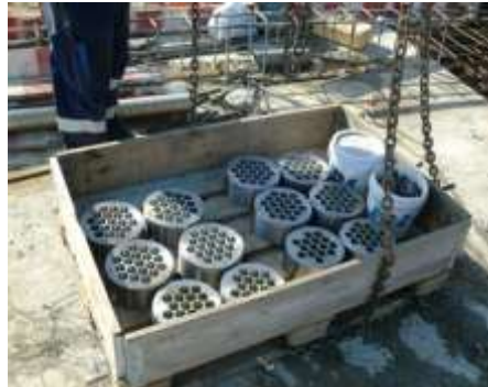
Figura 64 - Recepção dos pratos ou cabeças de ancoragem
