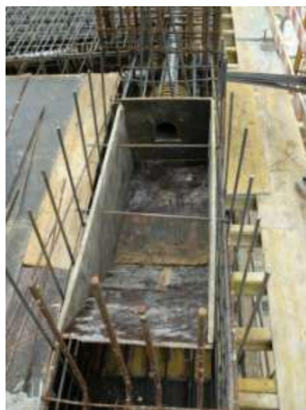
Figura 61 - Elevação dos cordões de pré-esforço e pontas sem protecção
