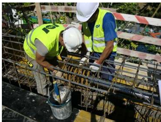
Figura 72 - Colocação da hélice
