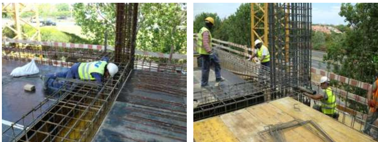
Figura 68 - Colocação de travincas e bainhas
