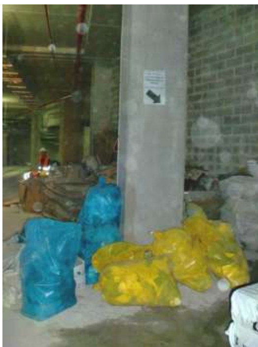
Figura 46 - Zona de armazenamento de resíduos
