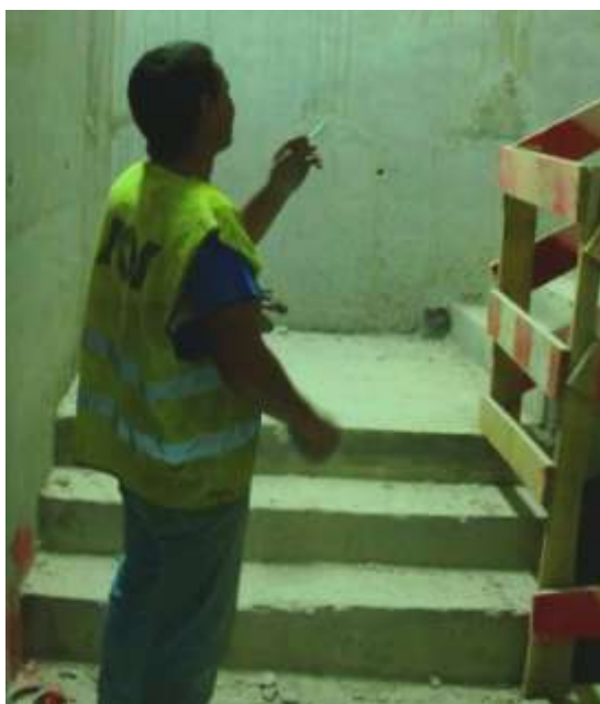
Figura 48 - Trabalhador a fumar em obra
