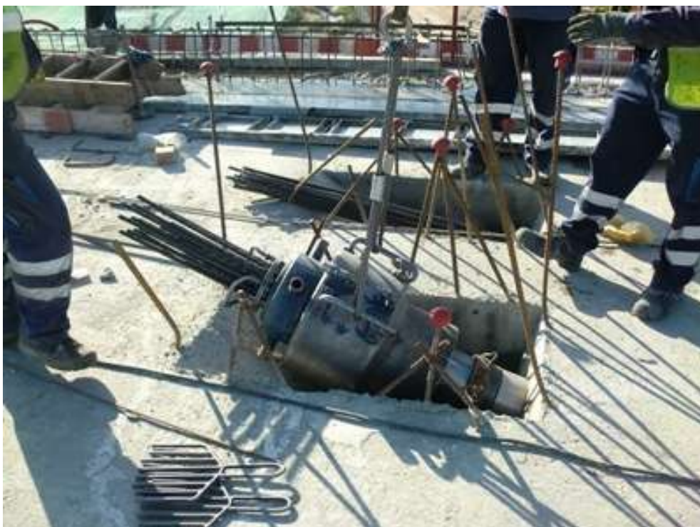
Figura 77 - Macaco a efectuar o puxe do cabo
