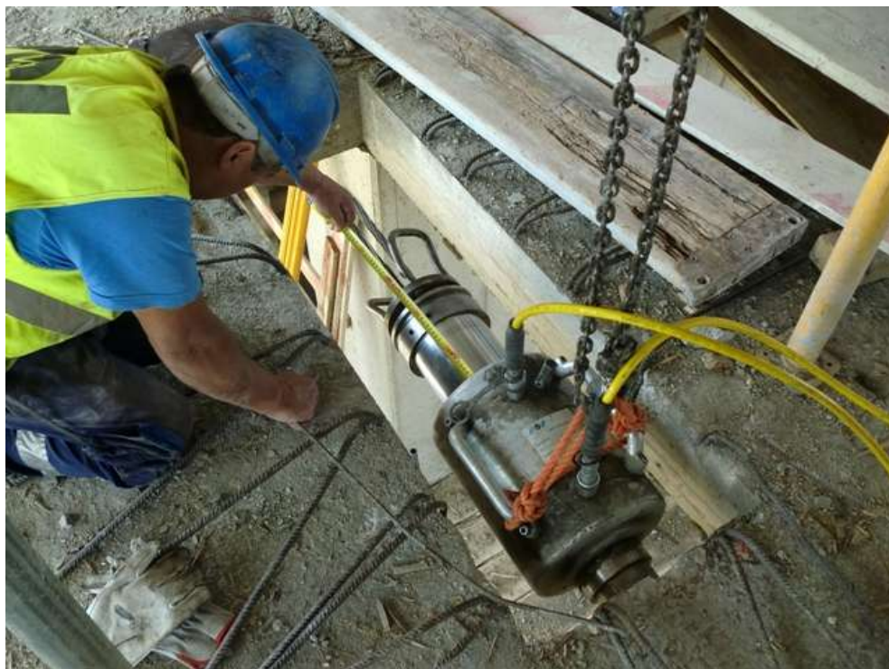
Figura 78 - Medição do alongamento
