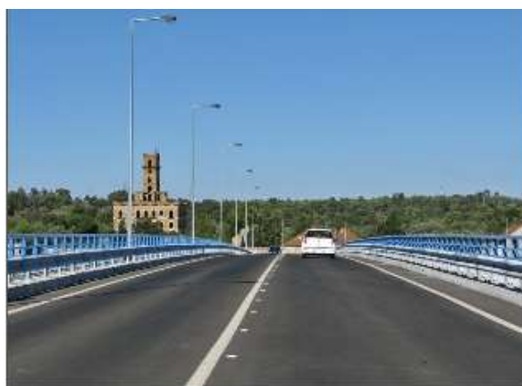
Figura 24 - Pontão de Coina evidenciando as duas faixas de rodagem
