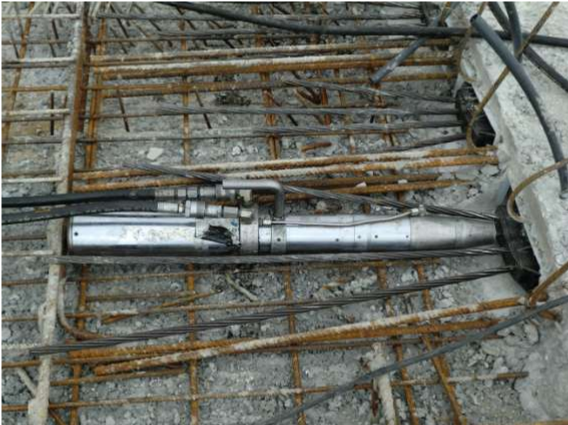
Figura 27 - Macaco monocordão
