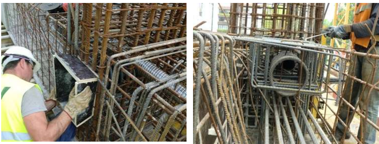
Figura 71 - Colocação de caixa e armaduras de reforço
