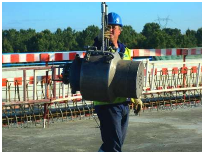
Figura 56 - Trabalhador ajuda na orientação do macaco
