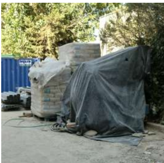
Figura 66 - Acomodação do cimento e da máquina de injeção
