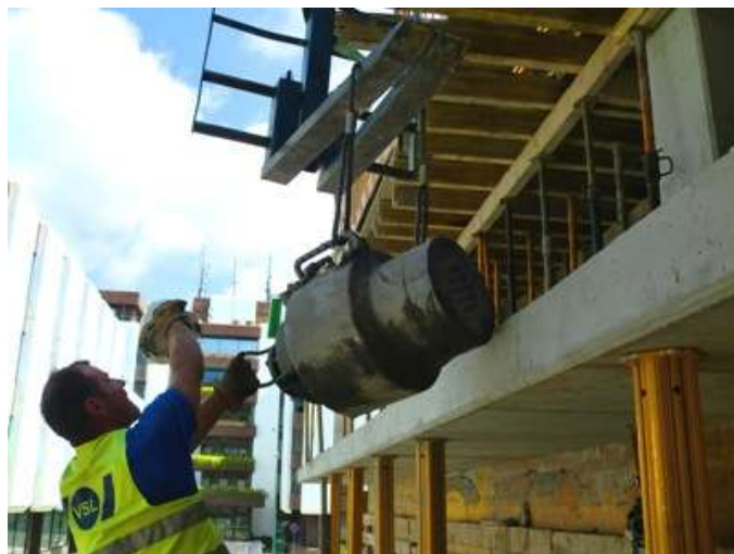
Figura 57 - Deslocamento do macaco por cavalete e por grua
