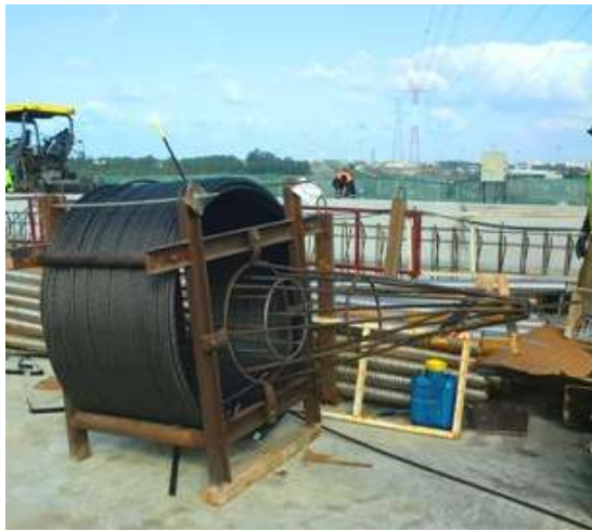
Figura 65 - Desenrolador com a bobine de aço e acomodação das bainhas
