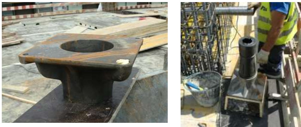
Figura 70 - Casting e trompeta
