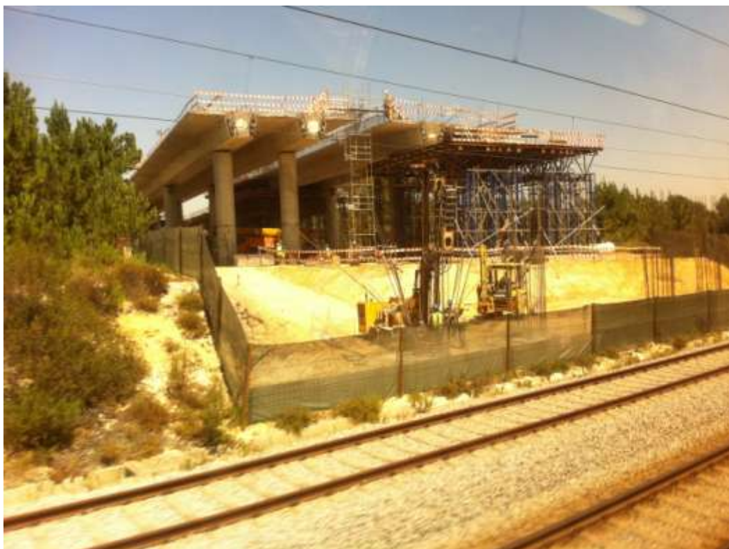
Figura 16 - Viaduto Coima 1 evidenciando as nervuras
