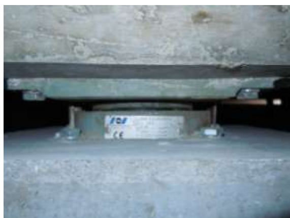
Figura 19 - Aparelho de apoio tipo pot-bearing
