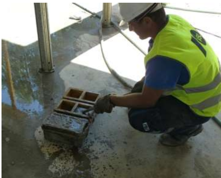
Figura 83 - Enchimento dos cubos com calda
