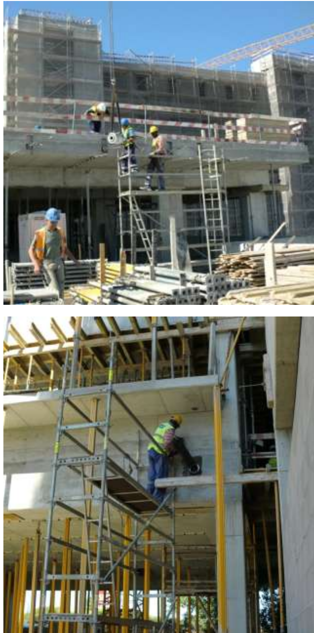
Figura 41 - Utilização de andaimés
