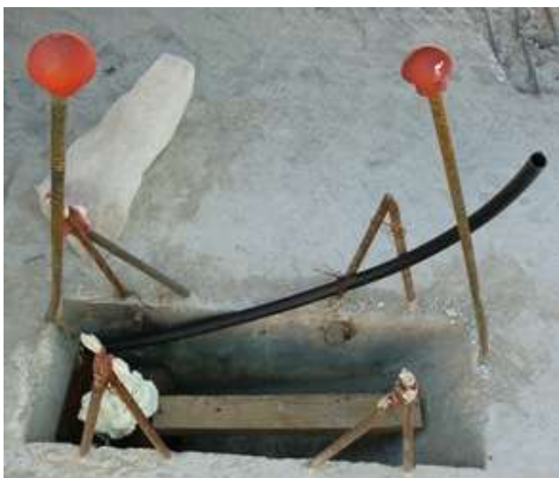
Figura 62 - Cogumelos a proteger as pontas dos varões
