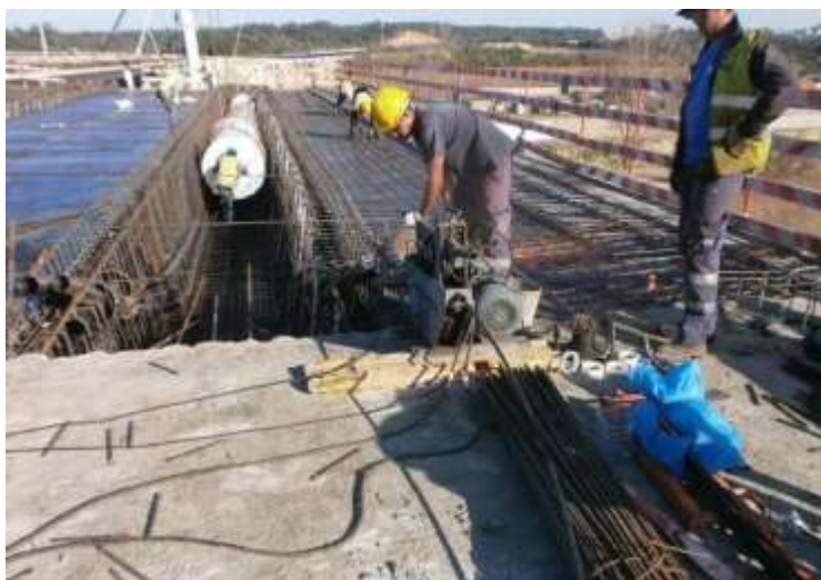
Figura 74 - Enfiamento com máquina vs. manual
