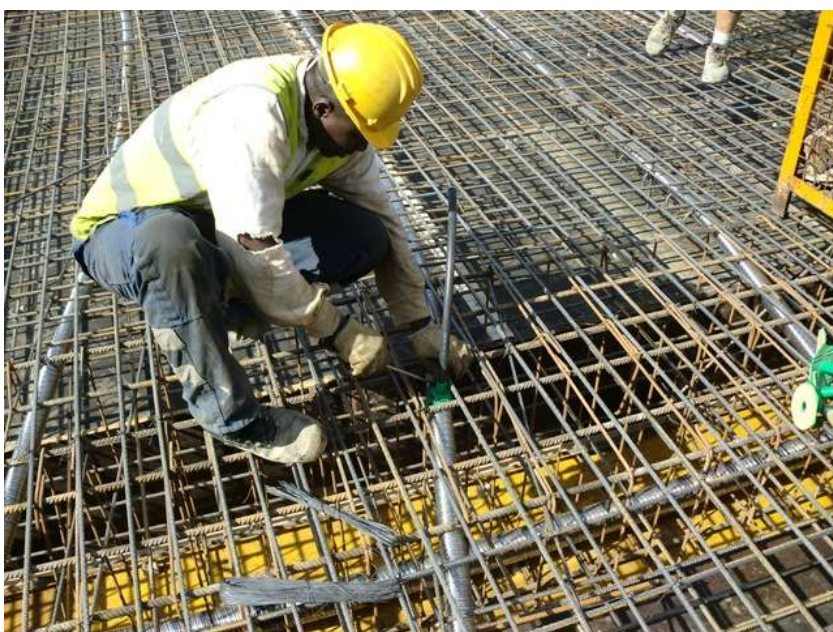
Figura 73 - Colocação dos tubos de purga
