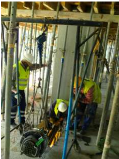
Figura 57 - Deslocamento do macaco por cavalete e por grua
