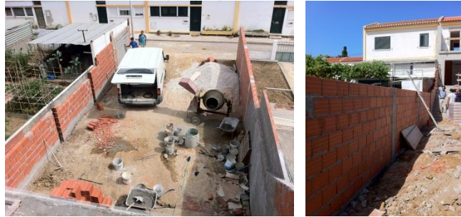
Fig. 5.61 - Muros laterais de vedação na zona do logradouro
