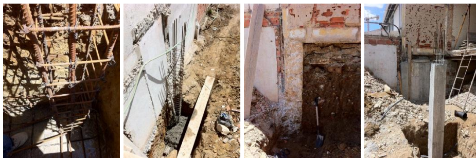
Fig. 5.17 - Abertura das sapatas, posicionamento das armaduras e betonagem destes elementos
