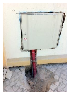
Fig. 5.41 - Caixa exterior para contador do gás
