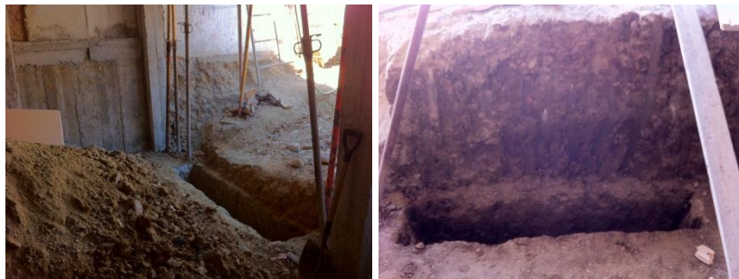
Fig. 5.34 - Execução de sapata sob paredes de alvenaria ao nível da cave
