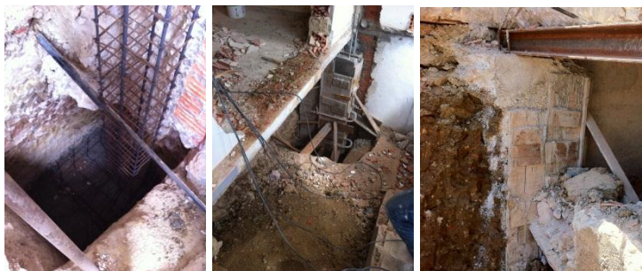
Fig. 5.11 - Posicionamento das armaduras das sapatas e pilares e cofragem destes elementos
