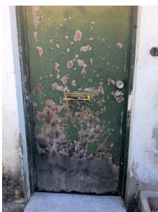
Fig. 3.11 - Degradação de portas e caixilharias
