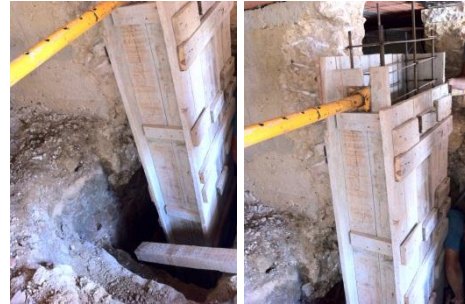
Fig. 5.21 - Cofragem e execução do pilar central da cave
