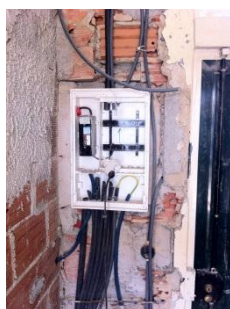
Fig. 5.42 - Caixa para novo quadro elétrico
