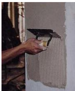
Fig. 5.59 - Cordões de cola feitos com talocha dentada
