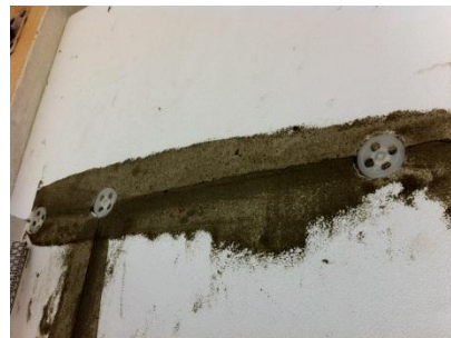
Fig. 5.51 - Fixação mecânica das placas EPS
