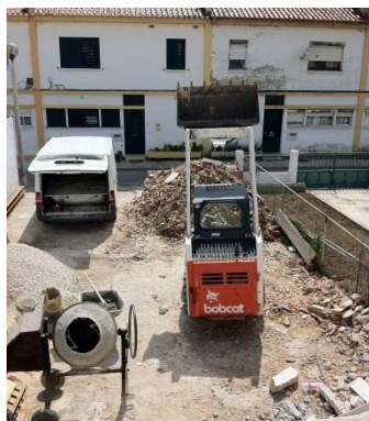
Fig. 5.4 - Estaleiro de obra e zona de armazenagem de entulho
