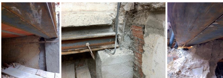
Fig. 5.12 - Posicionamento de vigas metálicas
