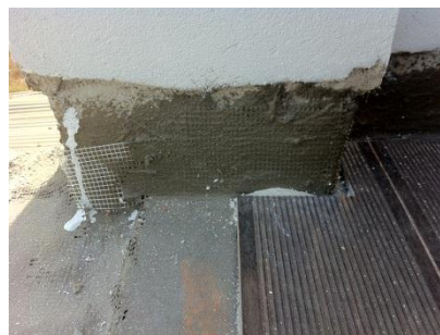
Fig. 5.56 - Acompanhamento nas paredes do reboco de impermeabilização e rede de fibra de vidro
