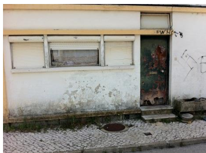
Fig. 3.11 - Degradação de portas e caixilharias
