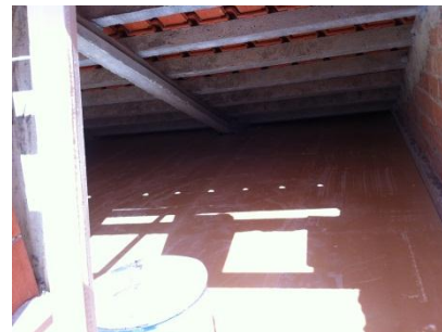
Fig. 5.9 - Aplicação do isolamento térmico na esteira
