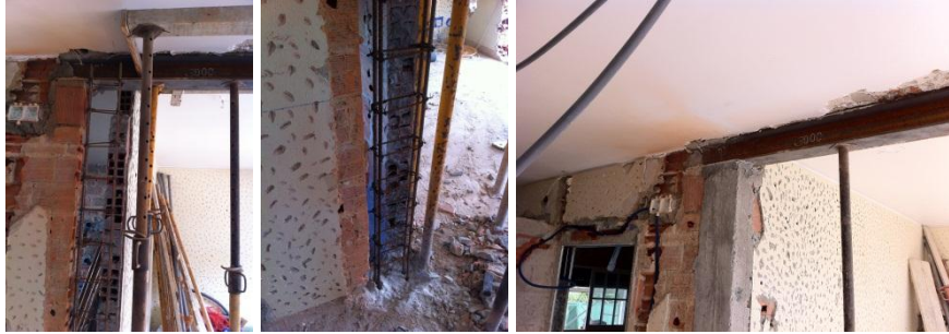
Fig. 5.16 - Execução de pilar e apoio de viga no mesmo
