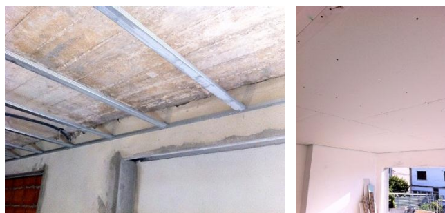
Fig. 5.45 - Estrutura e teto falso aplicado
