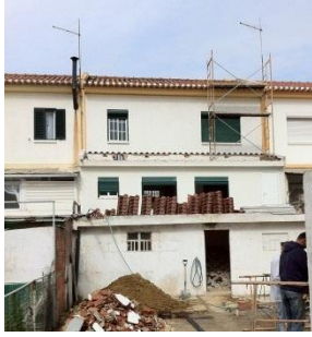
Fig. 5.5 - Andaime para acesso à cobertura
