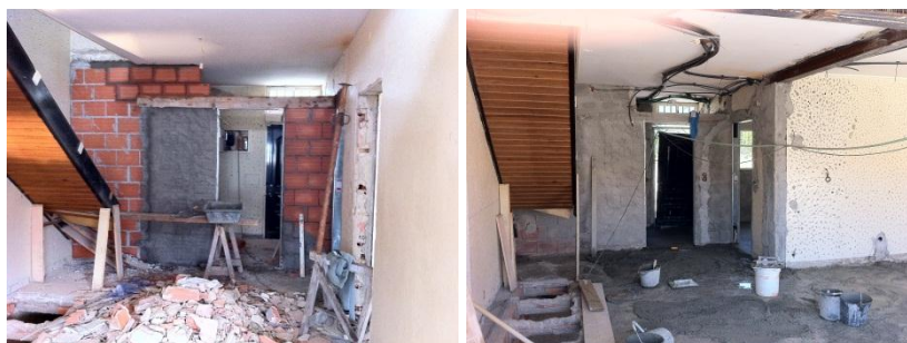
Fig. 5.37 - Execução de parede da casa de banho e hall de entrada ao nível do rés-do-chão
