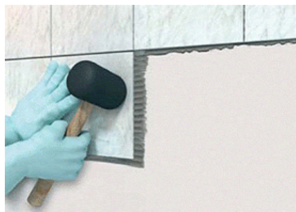
Fig. 5.60 - Recurso a maço de borracha para correto esmagamento dos cordões de cola
