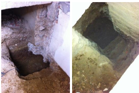
Fig. 5.10 - Abertura das sapatas
