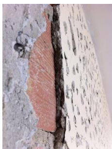
Fig. 5.57 - Picagem do reboco
