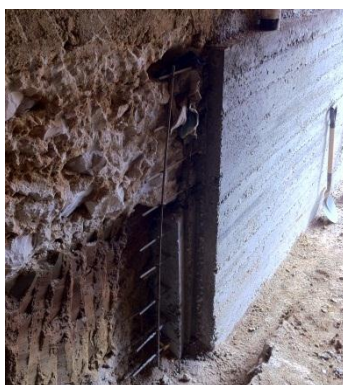
Fig. 5.26 - Pormenor do muro de contenção
