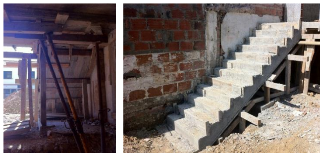
Fig. 5.31 - Execução da escada de acesso ao logradouro
