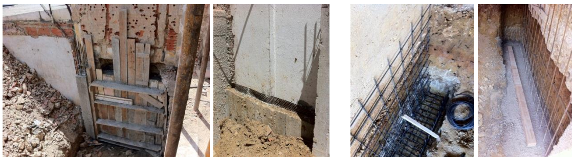
Fig. 5.18 - Muros de suporte entre pilares
