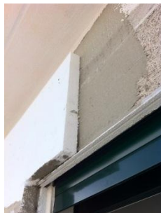
Fig. 5.50 - Colagem das placas EPS
