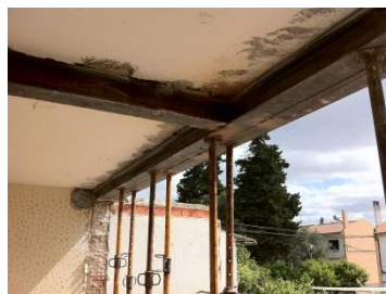
Fig. 5.15 - Posicionamento das vigas metálicas após demolição da fachada
