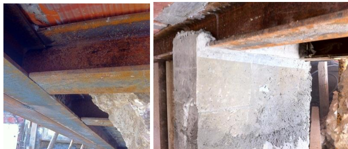
Fig. 5.22 - Apoio das vigas metálicas perpendiculares às fachadas nas vigas já existentes e no pilar central da cave
