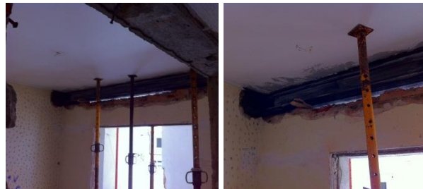
Fig. 5.14 - Posicionamento das vigas metálicas
