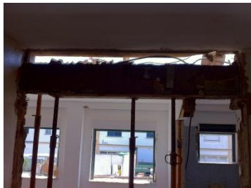
Fig. 5.13 - Escoramento e execução de abertura ao nível do primeiro piso
