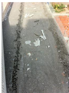
Fig. 5.55 - Incorporação da rede de fibra de vidro no reboco de impermeabilização
