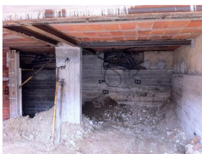
Fig. 5.29 - Escavação e contenção da cave finalizadas
