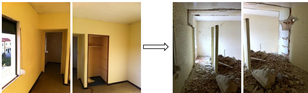
Fig. 5.36 - Demolição das paredes dos quartos ao nível do primeiro andar
