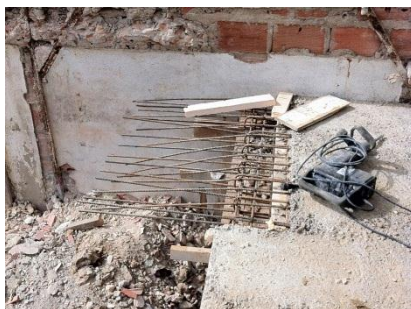
Fig. 5.28 - Pormenor das armaduras de espera para escada
