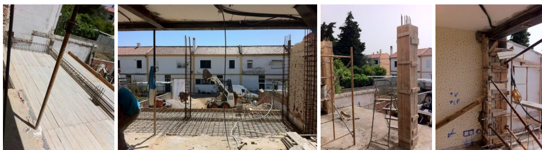
Fig. 5.27 - Cofragem, posicionamento da armadura e betonagem de laje de piso e pilares do rés-do-chão
