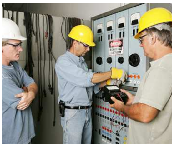
Figura 10. Inspeção Visual na manutenção de um edifício
