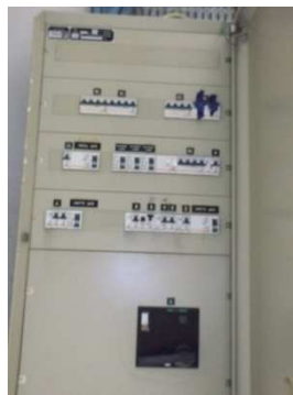
Figura 41. Quadro Parcial do Edifício DEM-ISEL
