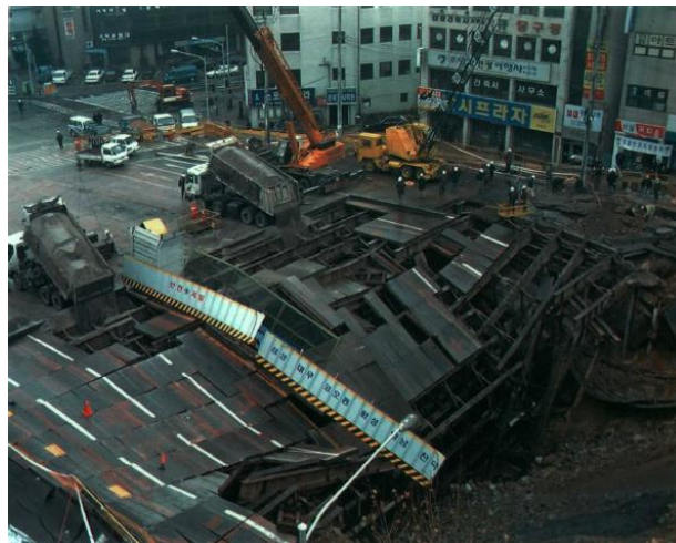
Figura 9 – Colapso no Taegu Metro, Coreia do Sul, 2000, que afectou toda a rua e edifícios adjacentes. [8]
