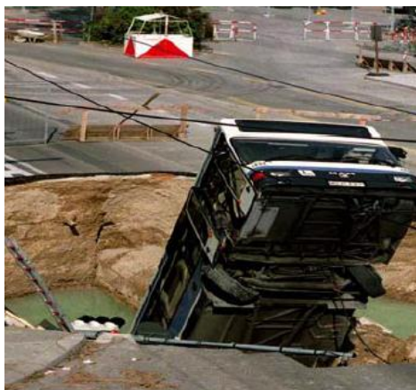
Figura 11 – Colapso à luz do dia em Munique, 1994. [ http://munichre.com ]
