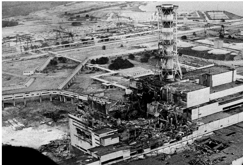
Figura 2 – Reactor destruído em Chernobyl após o acidente nesta central nuclear em 1986. [ http://boston.com/bigpicture/ ]
