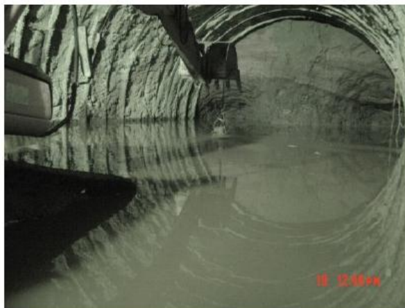
Figura 22 – Bombagem de água de uma frente de escavação inundada. [5]
