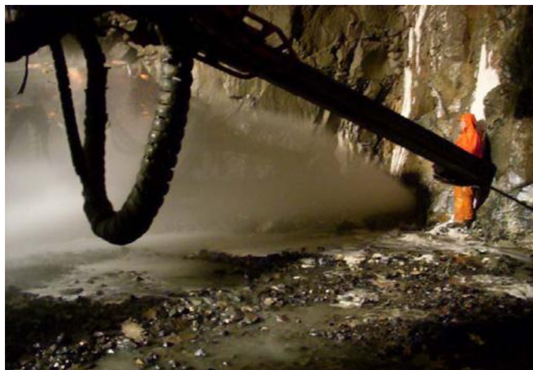
Figura 15 - Durante a construção do projecto Sauna Hydropower, na Noruega, a pressão dos fluxos de água chegou aos 40 bar. [ http://meyco.basf.com ]
