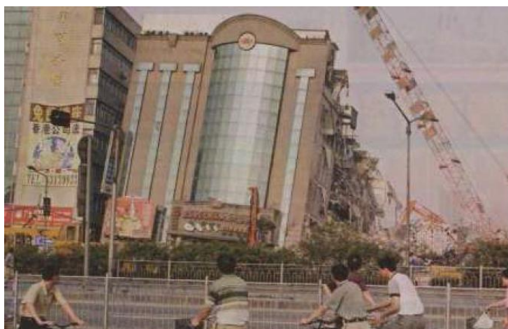
Figura 4 – Colapso durante a construção do metro de Shanghai, 2003. A deficiente gestão de riscos em empreendimentos pode levar a efeitos catastróficos. [Munich Re Group, 2006]
