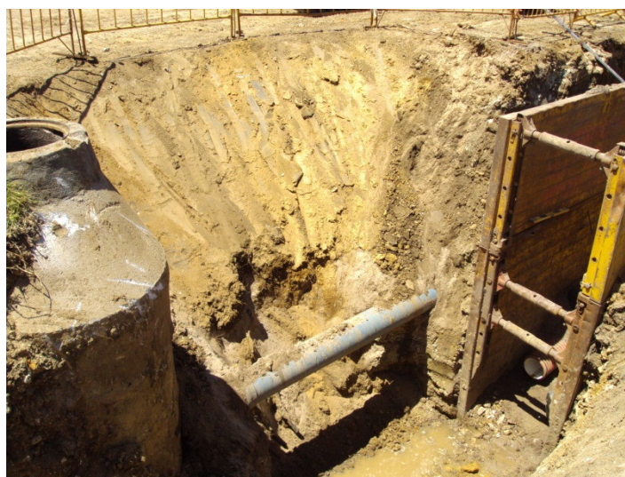
Imagem 18- Abertura de vala em talude
