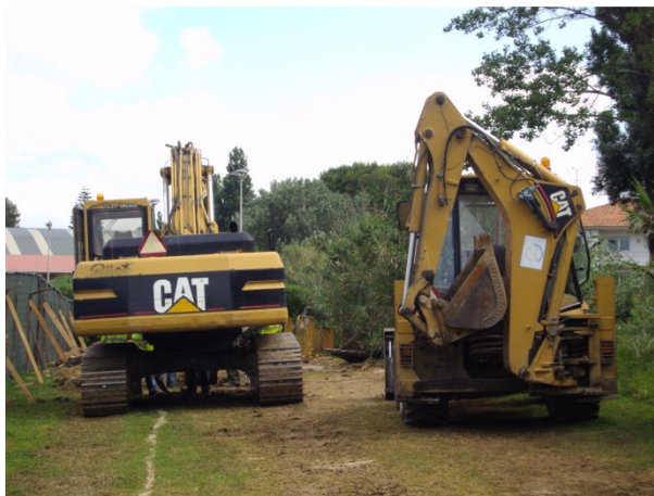
Imagem 15- Escavadora Giratória CAT325 e Retro-Escavadora CAT 438
