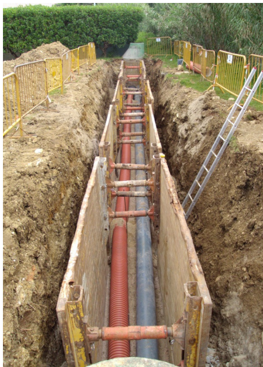
Imagem 33- Tubagens paralelas Colector derivação/Emissário Existente
