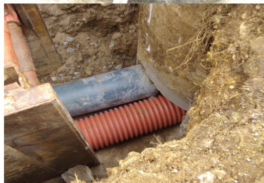
Imagem 34- Vista do interior da Câmara de Visita Imagem 35- Ligação à Camara de Visita
