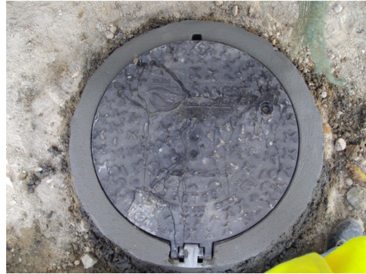
Imagem 53- Colocação de tampa
