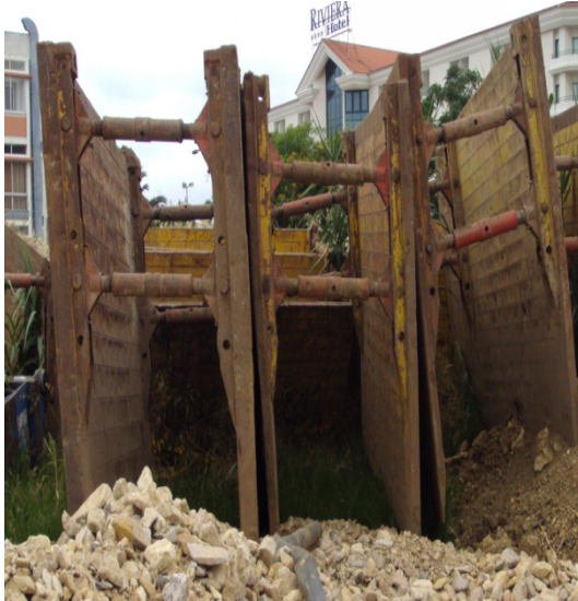
Imagem 16- Painéis de entivação tipo LTW
