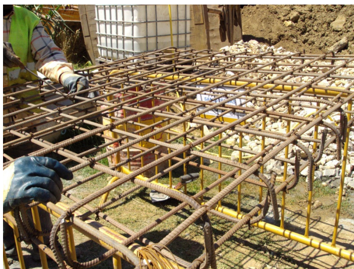
Imagem 44- Execução de armadura para reforço de fundo de CV
