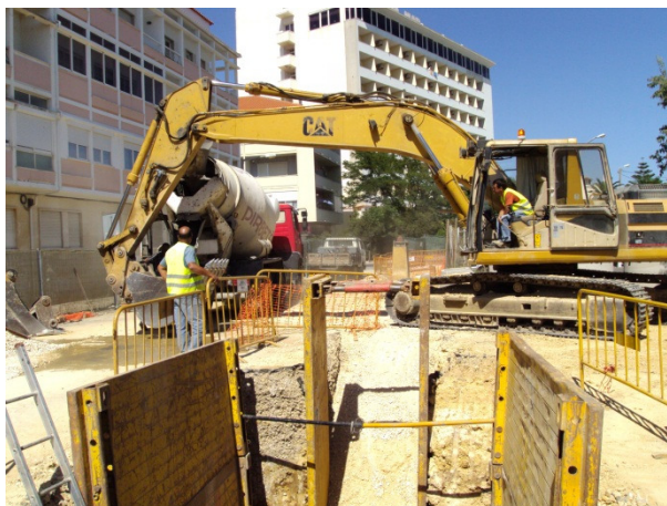
Imagem 45- Betonagem do fundo de uma caixa
