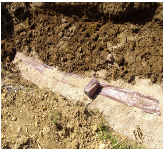
Imagem 31- Colocação de banda avisadora
