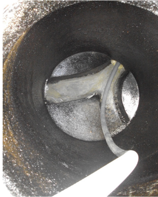
Imagem 42- Derivação para interior de CV
