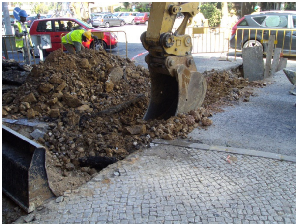
Imagem 28- Abertura de vala, 3ª Fase
