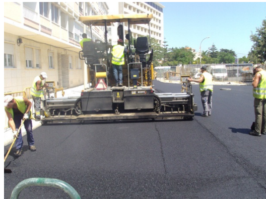
Imagem 65- Execução do Pavimento Betuminoso
