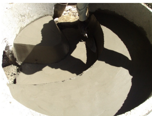
Imagem 46- Execução de caleira
