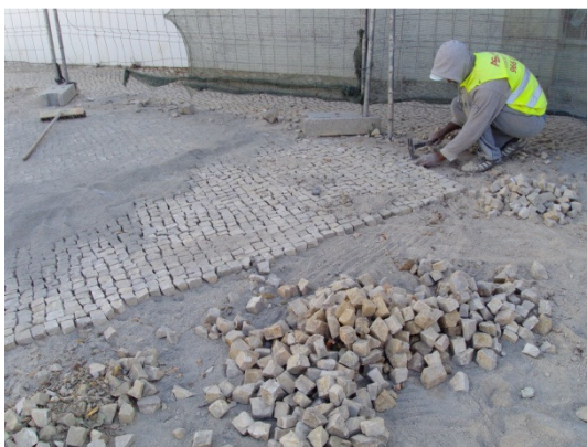
Imagem 58- Reposição de calçada, 3ª Fase
