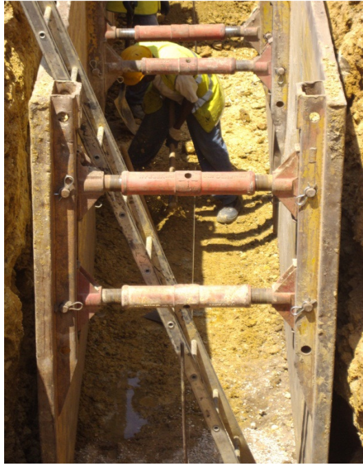
Imagem 25- Alinhamento do fundo da vala com fio-de-prumo
