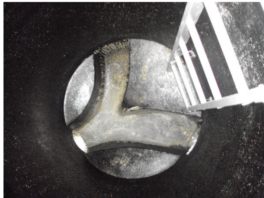
Imagem 56- Colocação de escada devidamente orientada
