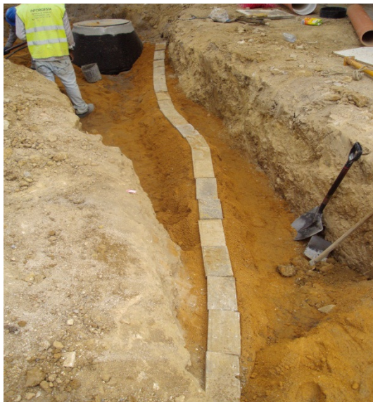
Imagem 72- Sinalização de Infra-estrutura (Rede de Media Tensão)
