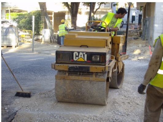
Imagem 62- Compactação de "tout-venant" com cilindro de rastos lisos
