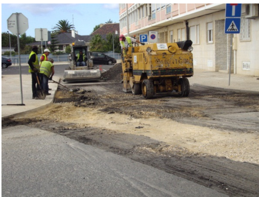
Imagem 63- Fresagem do Pavimento
