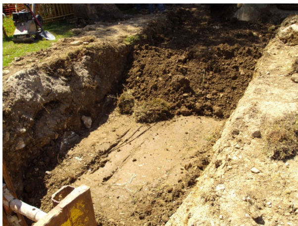
Imagem 27- Aterro por camadas devidamente compactadas, 1ªFase
