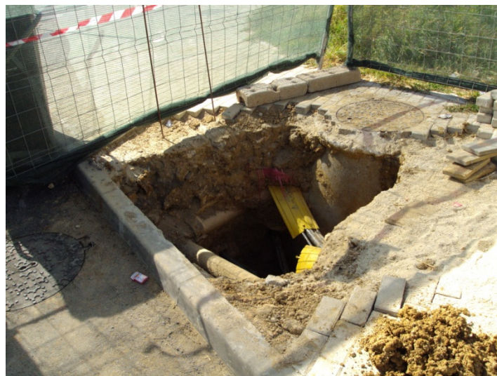
Imagem 9- Vedaçao na Rua de Luanda com Bekaert, sondagem manual
