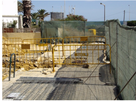
Imagem 11- Vedação 2ª Fase
