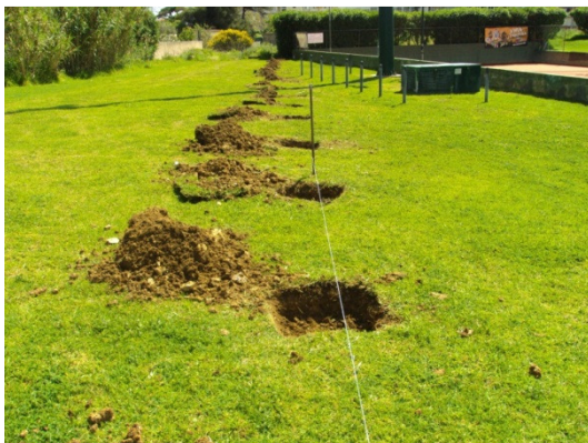
Imagem 4- Início de montagem de vedação
