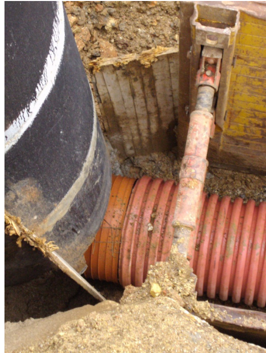
Imagem 49- Ligação Tubagem-Gola passa-muros
