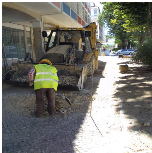
Imagem 26- Arranque de calçada de vidroço, 3ªFase
