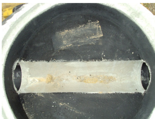
Imagem 47- Fundo de caixa pré-fabricado 180º
