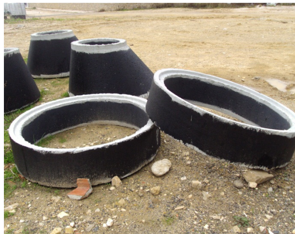
Imagem 43- Cúpula e anel pré-fabricado
