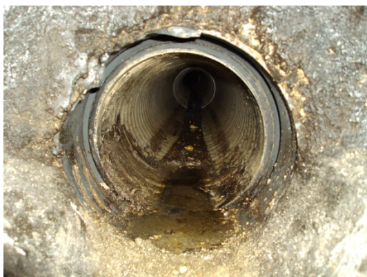
Imagem 1- Tubagem a reabilitar
