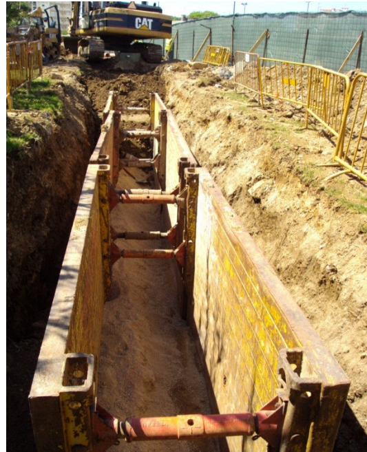
Imagem 17- Aplicação dos painéis de entivação
