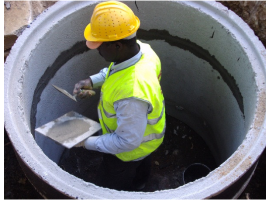
Imagem 51- Remate com argamassa nas juntas
