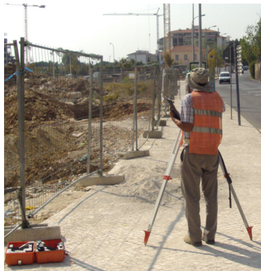
Imagem 12- Marcação topográfica de zona de trabalho
