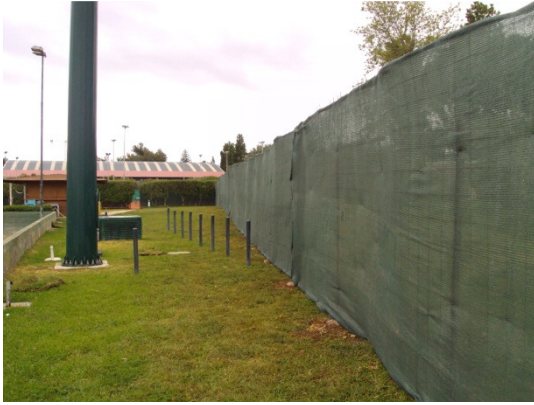
Imagem 10- Vedação 1ª Fase
