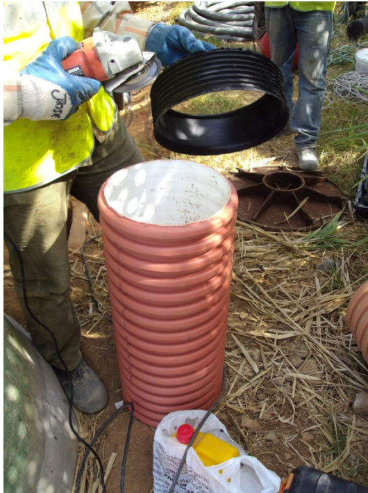
Imagem 48- Ensaio de colocação de gola passa-muros
