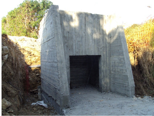
Imagem 57- Câmara de Válvula de Maré
