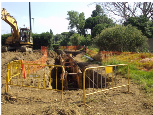
Imagem 19- Protecção de vala 1ª Fase
