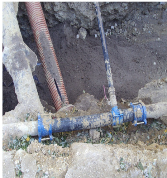
Imagem 73- Reparação de Infra-estrutura danificada (Ramal de abastecimento)
