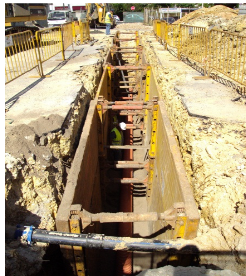
Imagem 30- Aplicação de tubagem
