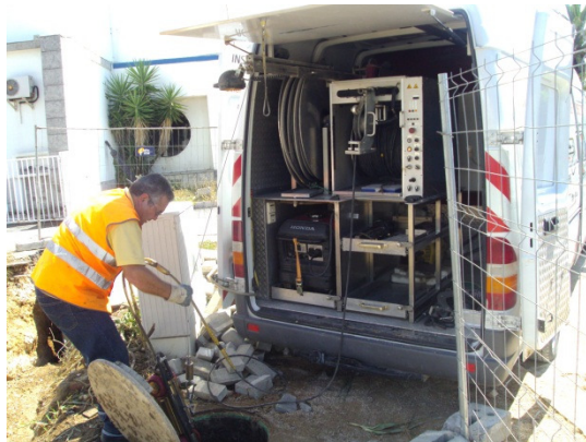
Imagem 13- Colocação de robot em Câmara de Visita
