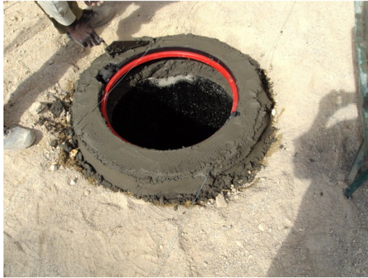
Imagem 52- Execução do aro em argamassa
