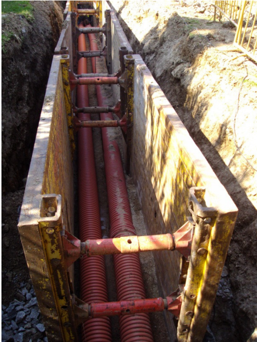
Imagem 36- Substituição do Novo Emissário
