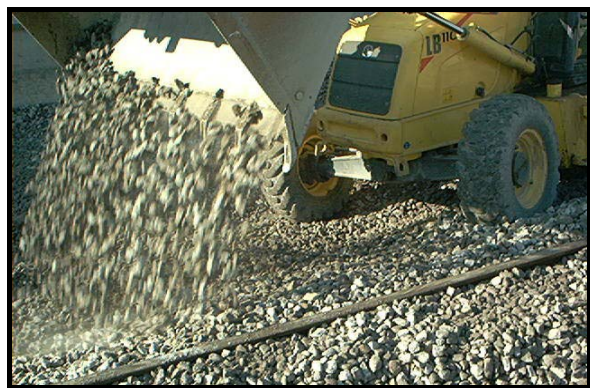
Figura XI – Descarga de balastro. (GIBB Portugal)
