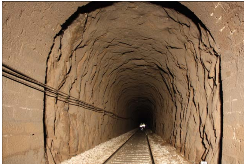
Foto 2 – Interior do túnel
