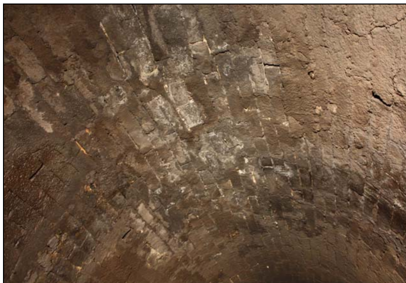
Foto 3 – Abóboda em alvenaria no interior do túnel
