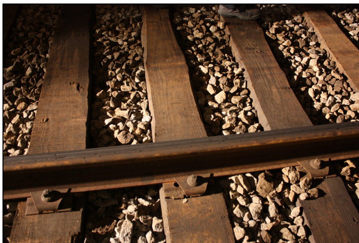
Foto 4 – Armamento de via no interior do túnel
