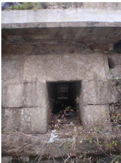
Foto 6 – Órgão de drenagem de via, que atravessa inferiormente a via encaminhando a água para uma linha de água existente.
