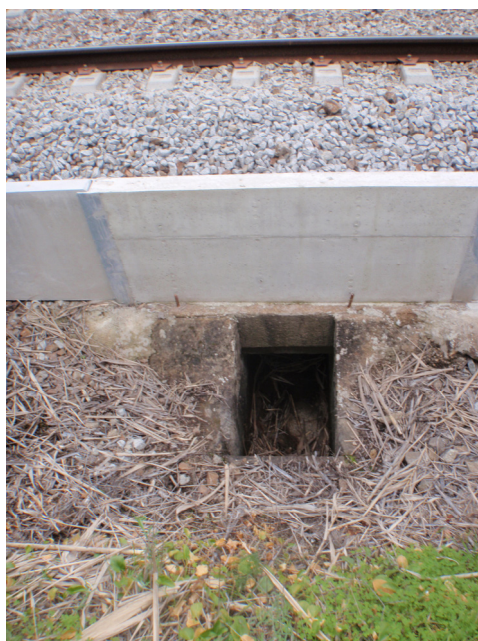
Foto 5 – Órgão de drenagem de via
