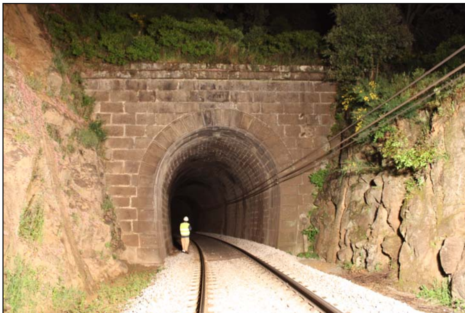
Foto 1 – Entrada no Túnel do Loureiro
