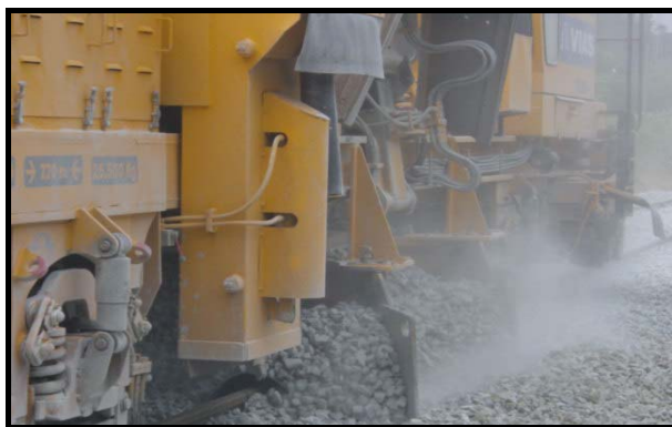
Figura XII – Regularizadora de balastro. (GIBB Portugal)
