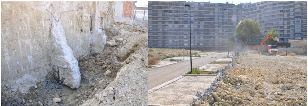
Foto 4 e 5 – Fase de Escavação, contenção e estrutura
