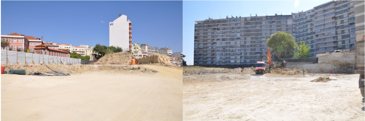
Foto 2 e 3 – Início da Fase de Escavação, contenção e estrutura
