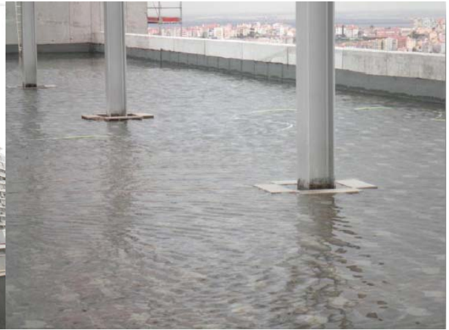
Foto 7 – Impermeabilizações Cobertura
