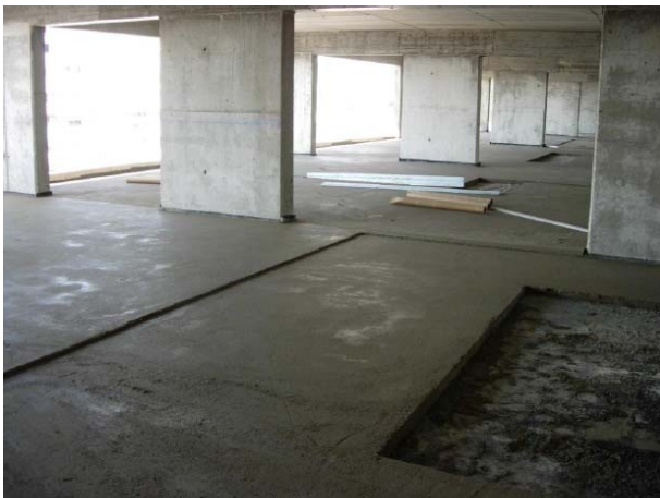
Foto 8 – Betonilhas nos quartos
