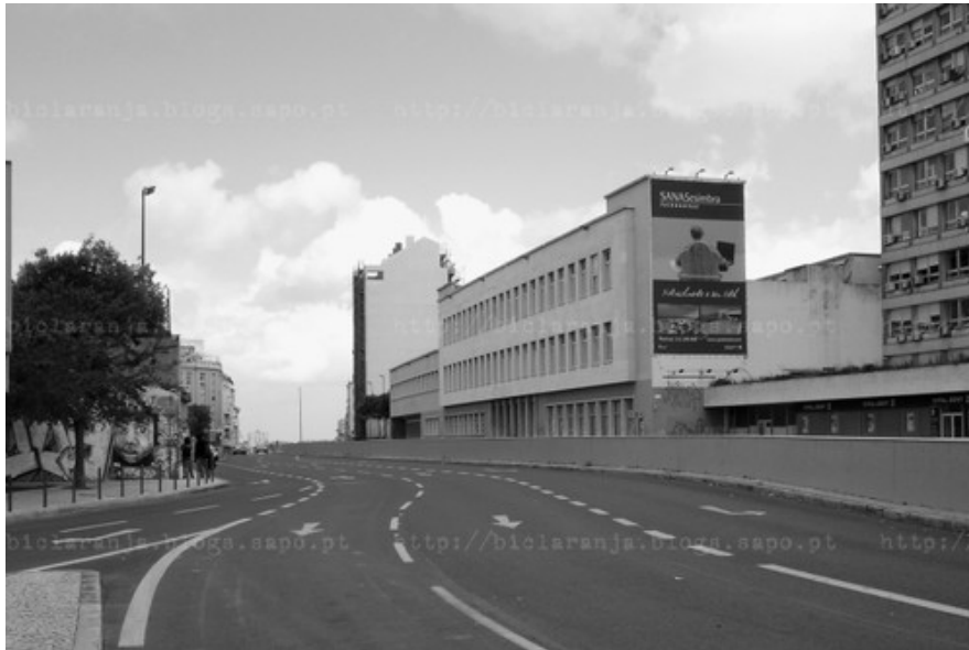
Foto 1 – Edifício Nova Base antes da demolição
