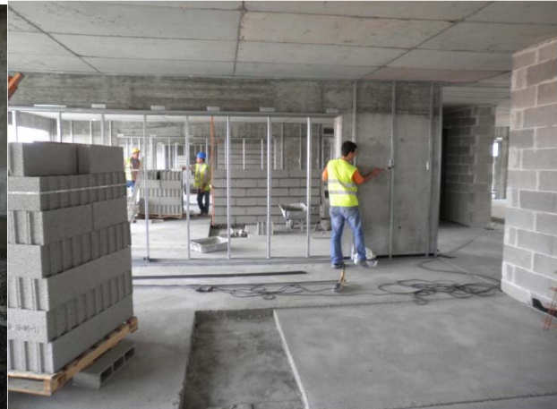
Foto 9 – Paredes em Blocos e Pladur
